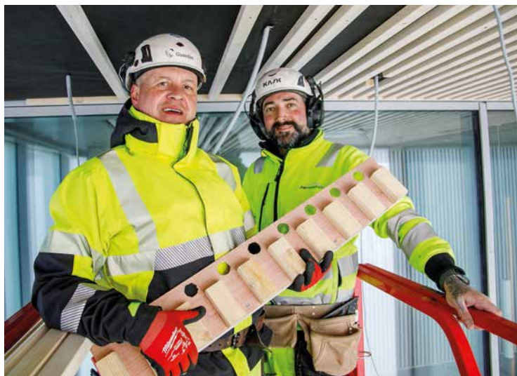
– Vi lurte på hvordan vi skulle løse oppgaven, og fant ut at vi trengte en mal å skyte trespikeren etter, sier Jack Ellery (t.h.) som utviklet malen sammen med Robert Michlik.
