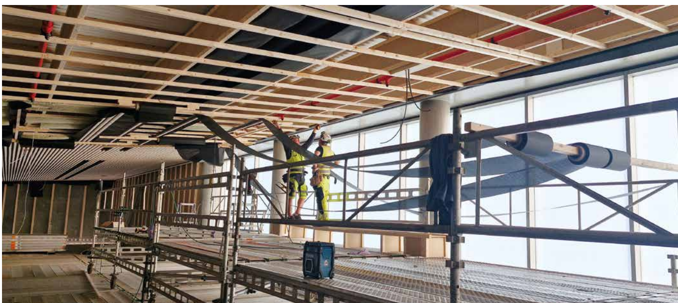
Taket ble ferdigstilt felt for felt, og ikke hele strekk i ett. Her er det klargjort for å legge duk før spilene blir siste prikk over i-en.
