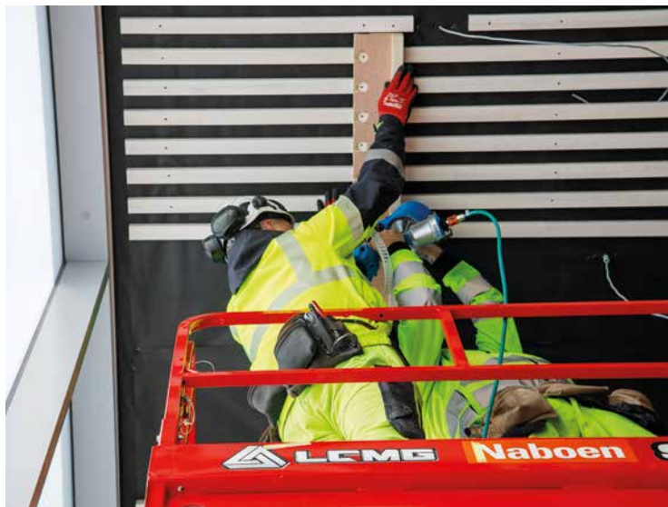
– Vi lurte på hvordan vi skulle løse oppgaven, og fant ut at vi trengte en mal å skyte trespikeren etter, sier Jack Ellery (t.h.) som utviklet malen sammen med Robert Michlik.
