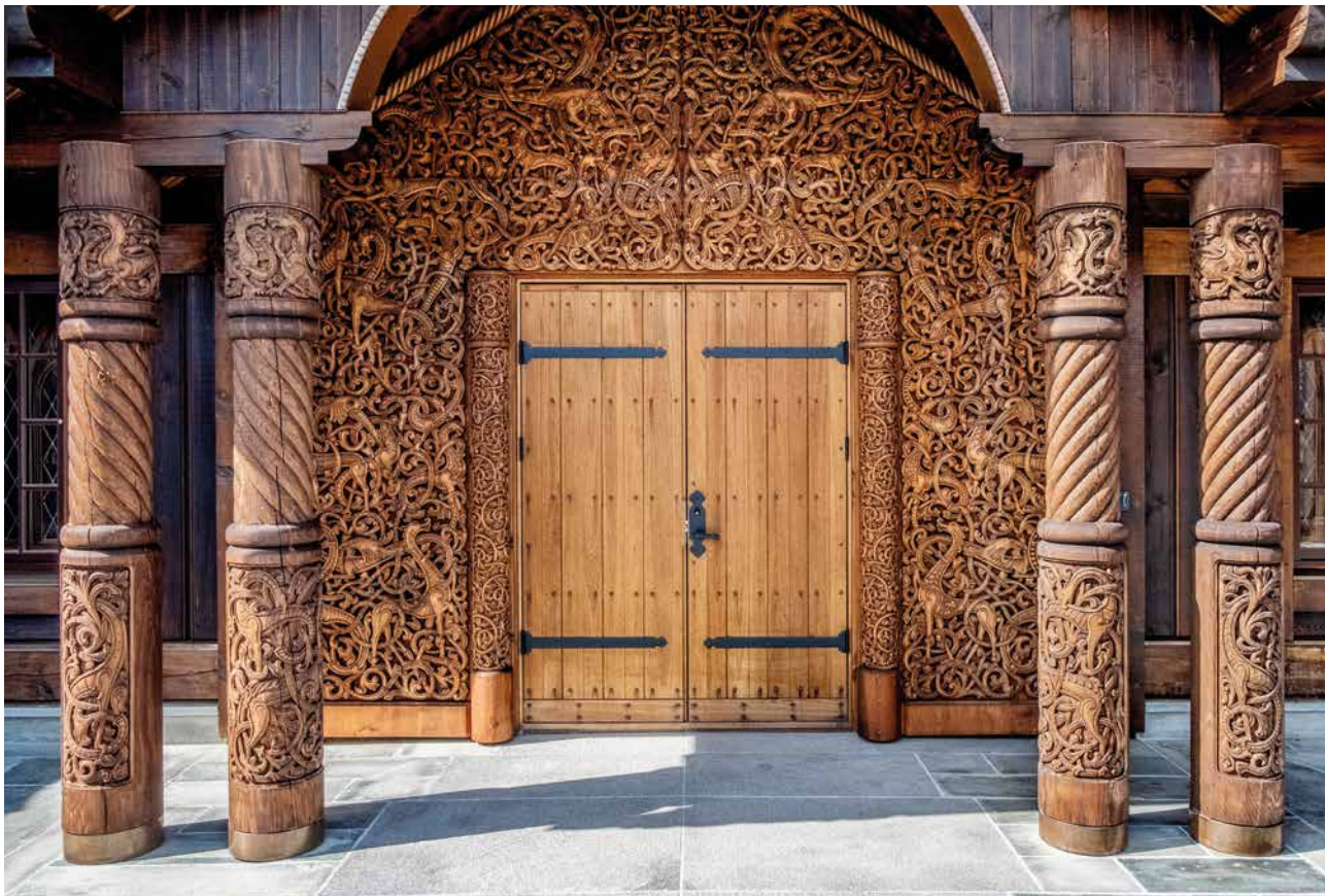
Materialene til selve portalen hadde treskjæerne liggende i verkstedet fra før. Det kommer fra en skog nord i Rennebu, og et gammelt sagverk som la der, på grensen til Midtre Gauldal. Treskjæerne har selv besøkt skogeieren, og var på vandring mellom enorme furustammer, da de spurte om det gikk an å få felt noen av disse.
