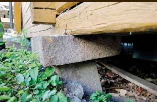
Solid fundamentering med store steiner har sørget for å holde stabburet stabilt og tørt.
