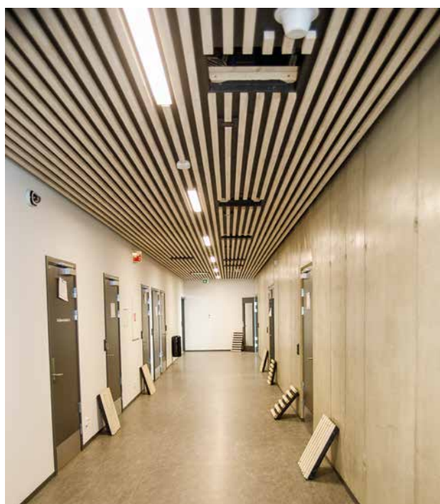
Lys og dyser for brannslukning er lagt i fukt med spilene. Noen av de siste ferdige inspeksjonslukene venter på å bli satt opp.
