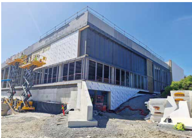
Jærmester føret ut med masonittstendere på ytterveggene for å isolere utenpå betongen. Tykkelsen på utlektingen varierte fra cirka 6–35 cm for å oppnå slett fasade. (Tre nederste foto: Jørn Krogedal/Jærmester)
