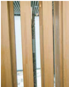
Spilene foran plexiglasset i 2. etasje over resepsjonen er montert slik at de skjuler stenderverket.
