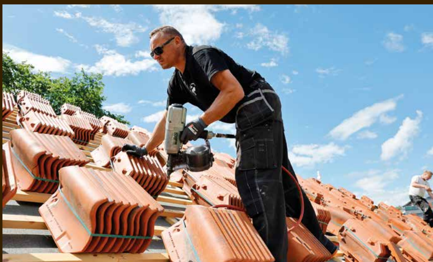
Tømrer Valdas Miracas gjør seg ferdig med undertak og lekter før stabburet får tegltak.
