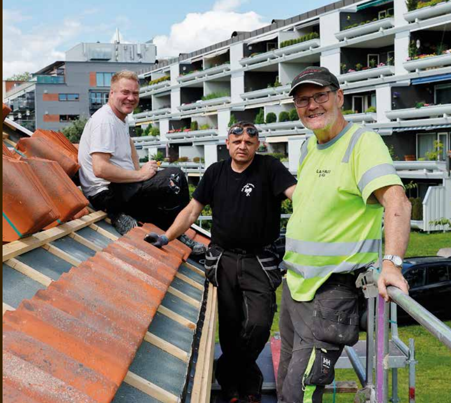
Byggmester Kay Runar Bjørnfeld, tørmrermester Hallvard Slaathaug og tømrer Valdas Miracas er snart ferdig med restaureringen av stabburet på Ullern.
