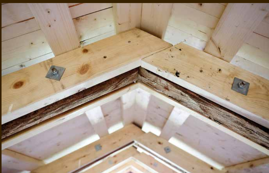
Taket er gjenoppbygget for å tåle et tyngre tegltak. De nye taksperrene har stå på begge sider og gjennomgående gjengestag.
