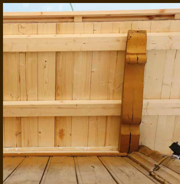
Vannbord og taklekt er utført i malmfuru, mens impregnerte materialer bevisst er valgt bort.
