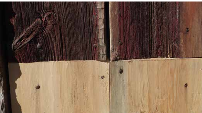
Veggen ved siden av inngangsdøren til utedoen er spunset.
