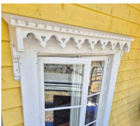
Alt listverk rundt vinduene er nye, i all hovedsak håndlaget av tømreerne til Klimabygg. Den forseggjorte dekoren over vinduet er det eneste som ble frest ut med Klimabyggs sin CNC-fres.
