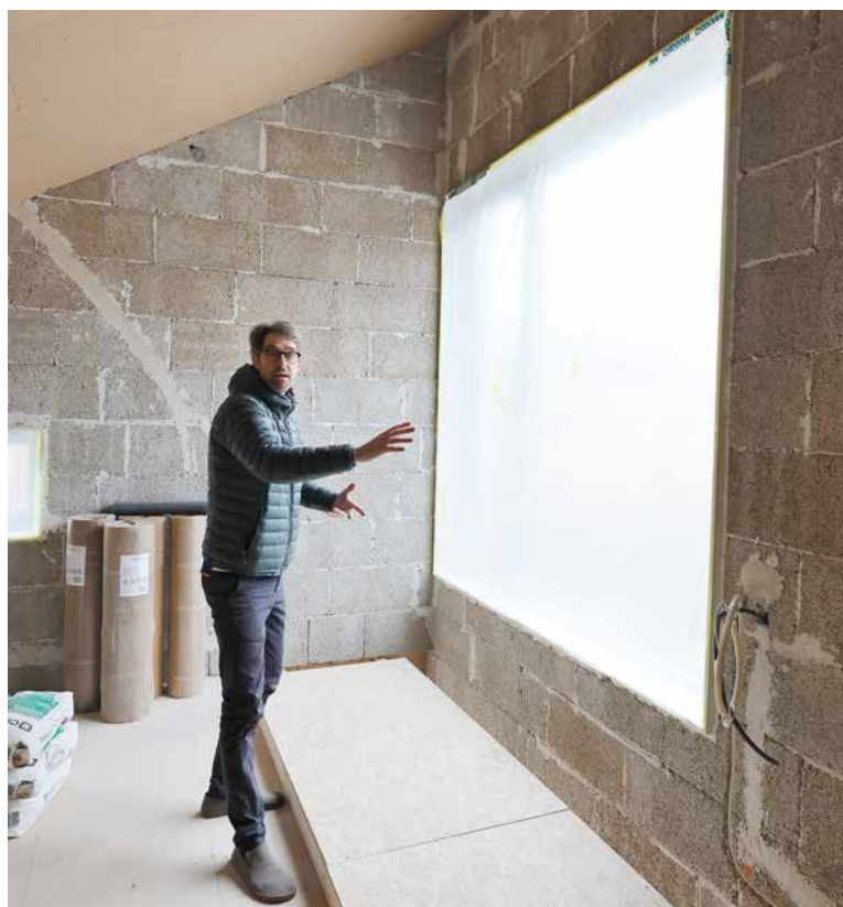
– Dette er en pustende vegg. Det er ingen plast her, sier Dalziel foran stuevinduet i tilbygget.
