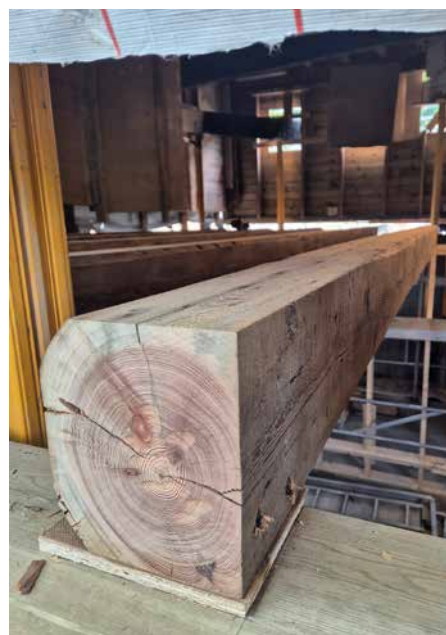
Solid gjenbruksvirke brukes til bærebjelker i 1. etasje. De går helt ut slik at ytterveggen hviler på bjelkene.
