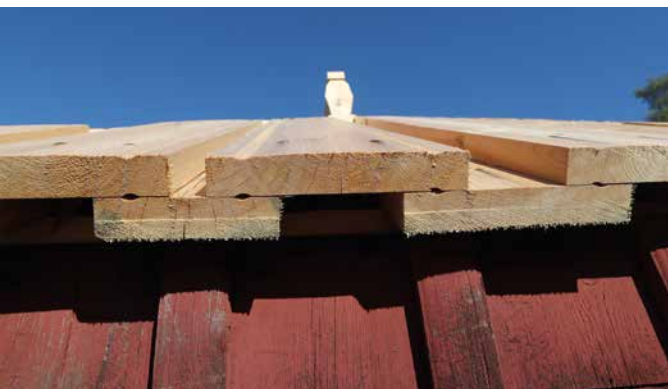
Overliggerne - de øverste bordene på taket - har bortimot 100 prosent kjerneved. Det er både kjerneved og yteved på underliggerne. Legg merke til at marga er midt på oversiden av takbordene.
