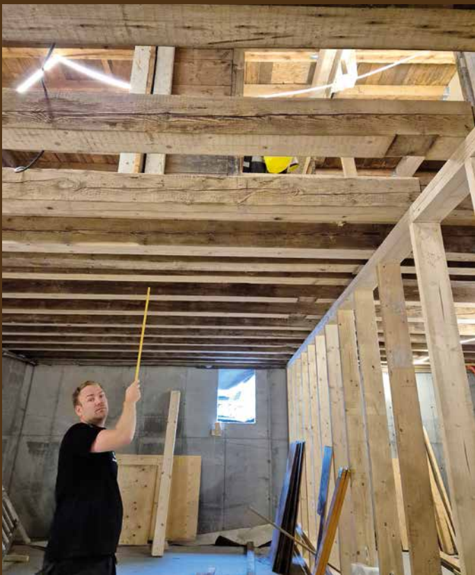
Anleggsleder Kim-Alexander Nilsen fra Klimabygg viser takhøyden i kjelleretasjen. Bjelkelagskonstruksjonen til 1. etasje består av gjenbruksvirke fra Toftegaard Treleast (det gamle TV2-bygget).
