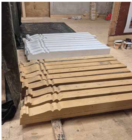
Nye taksperrprofiler laget av Klimabyggs tømreere, er klare for maling.
