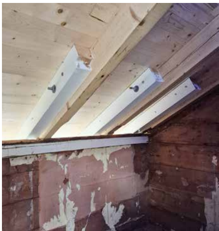
Siden profiltaksperrere var mindre, og måtte vises på utsiden, ble de lagt på siden av taksperrere.
