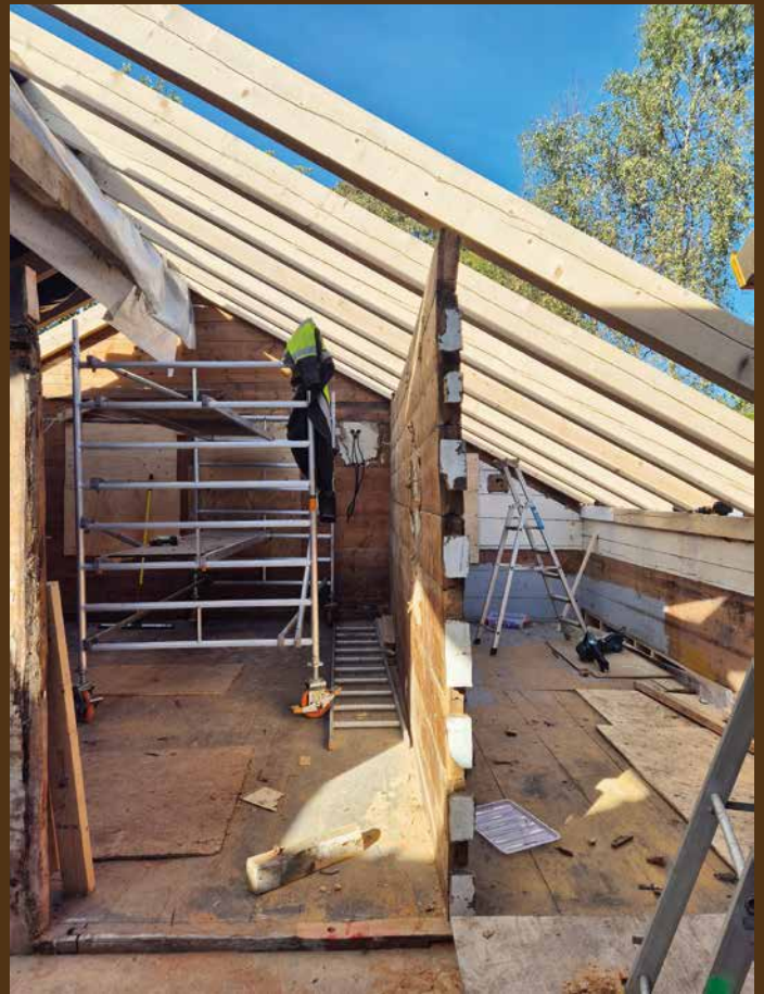
Den gamle takkonstruksjonen var i så dårlig stand at alt måtte rives og måtte bygges ny med sperr fra samme tidsepoke. De opprinnelige hanebjelkene er erstattet med taksperr som hviler på mønre-drager. Det øker innvendig takhøyde.
