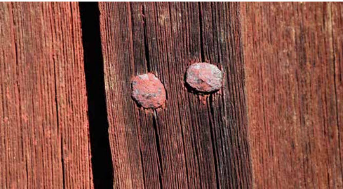
Det ble opprinnelig brukt håndsmidde spiker til å feste bordkledningen på utsiden av utedoen.
