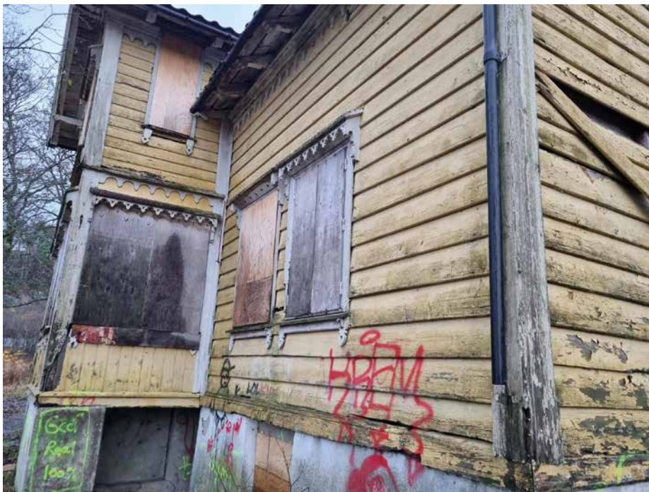
Klimabygg tettet huset før restaurering. Det hadde blitt ei nedslitt rønne, brukt av bydelens løse fugler.
