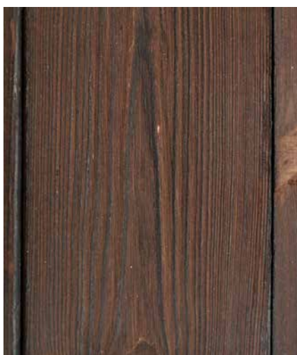
Brent børstet malmfuru kledning, med Aquatan fargepigment.
