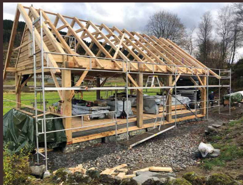
Reising av grinda, dag to: - Grindverket ble produsert på forhånd. Da vi begynte å reise, var bygget under tak på fire dager. [Foto: Magne Kleiveland]
