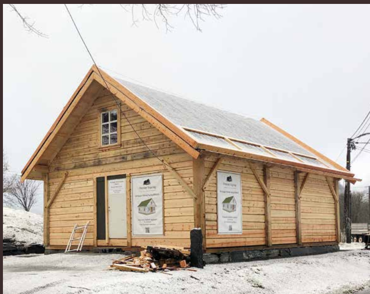
Før vindauger vart skorne ut i tømmerveggene. [Foto: Magne Kleiveland]
