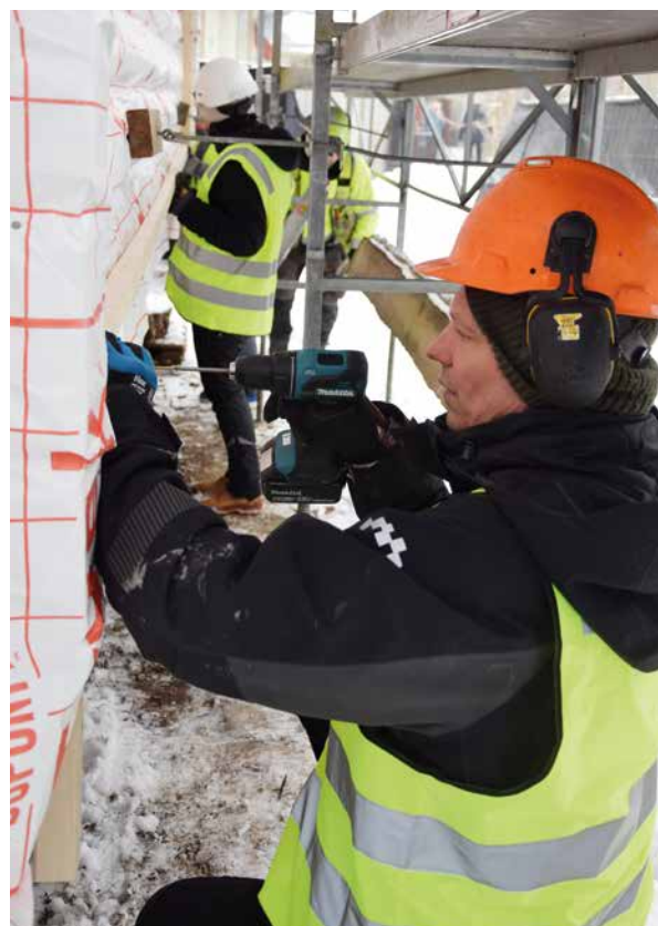
PÅFORING: Mathias Hirkow skrur fast spikerslag til påforing på den ene stabbursveggen.
