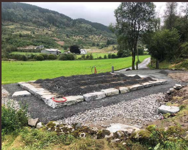
Matjorda fungerer som isolering og lufting så lenge konstruksjonen er diffusjonsåpen. Tetting ville ødelagt prinsippet. [Foto: Magne Kleiveland]
