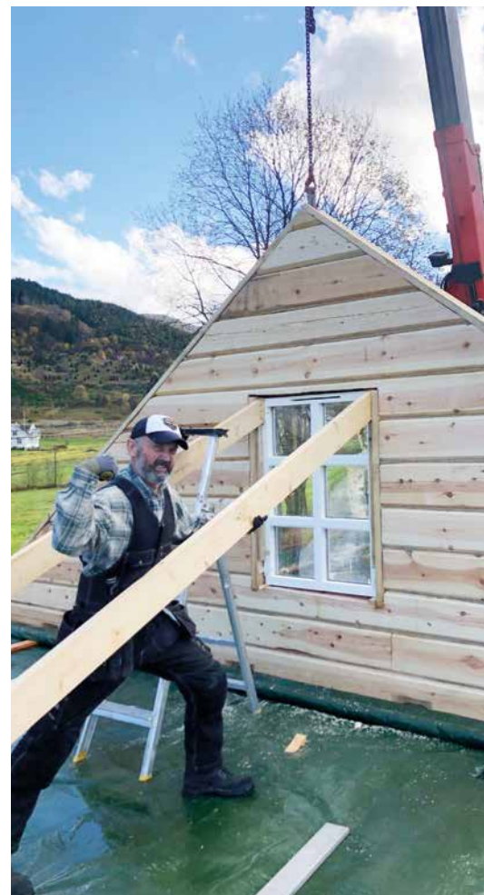
Her reiser James Henry Alexander Chaplin ei av tømmerveggene til Bokhuset. [Foto: Magne Kleiveland]
