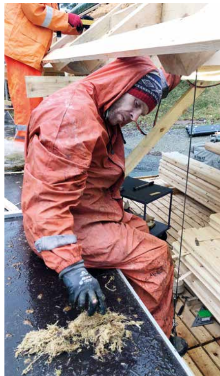
Tradisjonshåndverker Lasse Eriksen isolerer Bokhusets tømmervegger med husmose - slik det alltid har vært gjort. [Foto: Magne Kleiveland]
