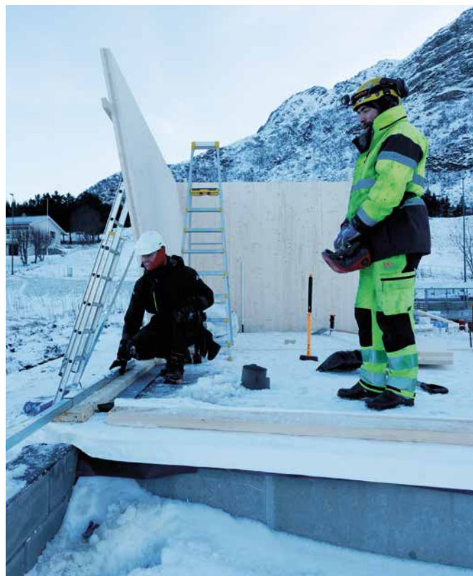
Tømrer Emil Hustoft fra Byggalf monterer massivtre med Tor-Vidar Wangen fra BKT. (Foto: Olav-Inge Alfheim)
