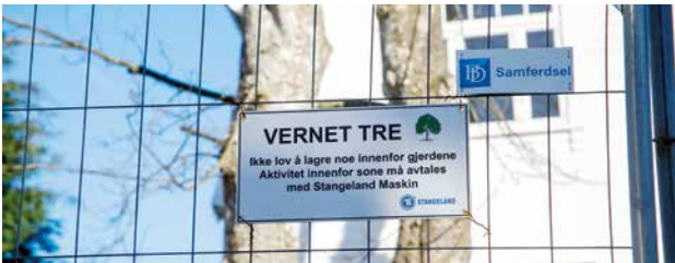
Tomta inneholdt flere freda trær. De gjerdes inn for ikke å bli skadet av byggarbeidet.
