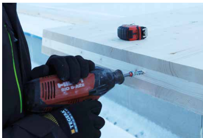
Innskruing av fester for sertifisert løftesystem beregnet på elementer, massivtre og limtre levert av Motek. (Foto: Olav-Inge Alfheim)
