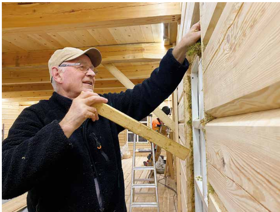
Leiv Mæle, leiar i byggenemnda dyttar mose i tømmerveggane. [Foto: Magne Kleiveland]
