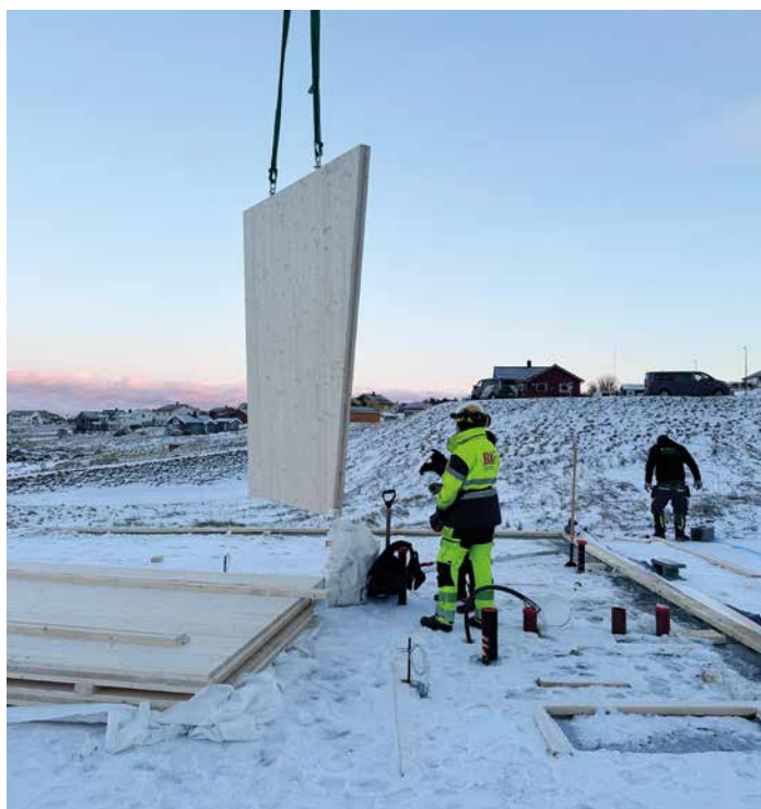
Tre av hovedbærlinjene er i massivtre, kombinert med skjult søyle- og dragerkonstruksjon i limtre. (Foto: Olav-Inge Alfheim)
