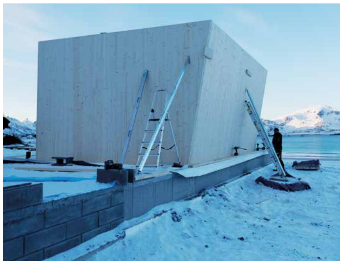
Hovedbæringen er løst med massivtre i tre linjer, kombinert med skjult søyle- og dragerkonstruksjon i limtre. (Foto: Olav-Inge Alfheim)
