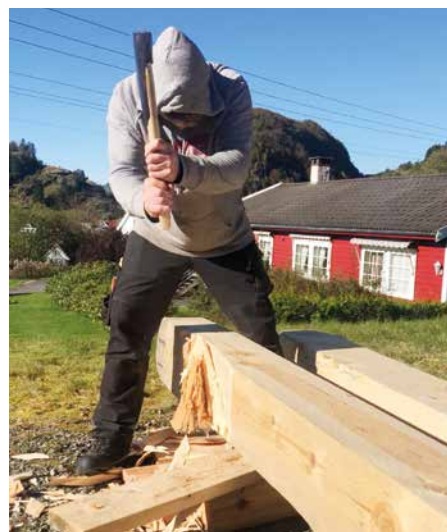
Tobias høgg betahalsar til grindbygget Bokhuset på Osterøy. [Foto: Magne Kleiveland]
