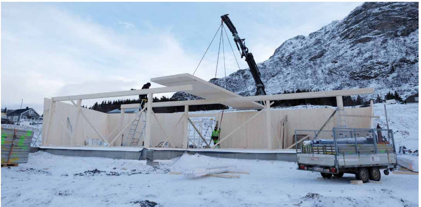
Eneboligen er på rundt 150 m 2 i én etasje, med åpne hovedarealer uten innvendige bærepunkter. (Foto: Olav-Inge Alfheim)
