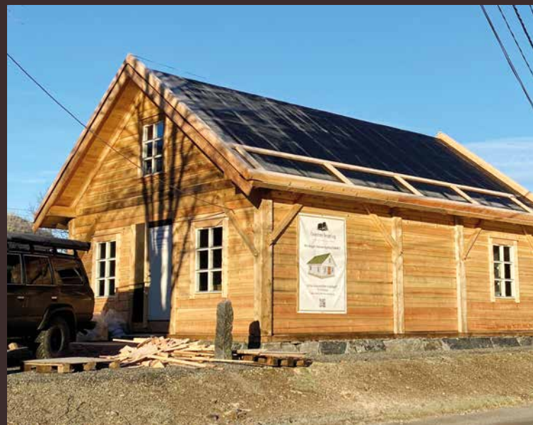
Første vinter var taket på Bokhuset uten ferdig isolasjon, likevel brukte bygget rundt 5000 kWh på et år. [Foto: Magne Kleiveland]
