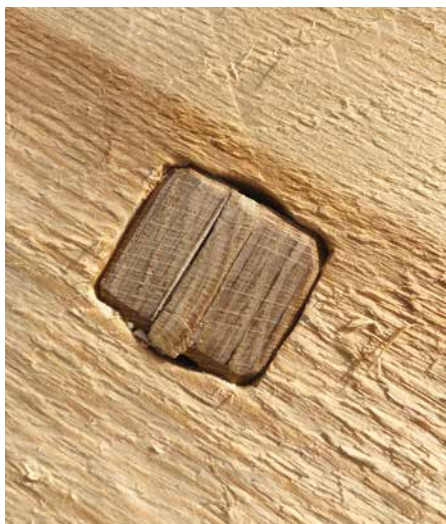
Nagle av ask med kontrakile. [Foto: Magne Kleiveland]
