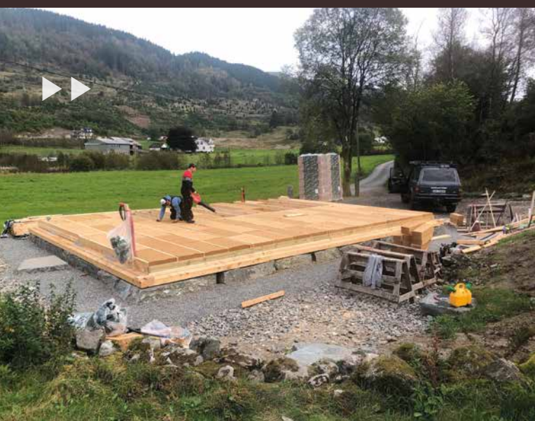
James Henry Alexander Chaplin og Tobias Haga bygger dekket på Bokhuset. Gulvet er isolert med 35 centimeter matjord og 20 cm trefiber - helt uten betong. [Foto: Magne Kleiveland]
