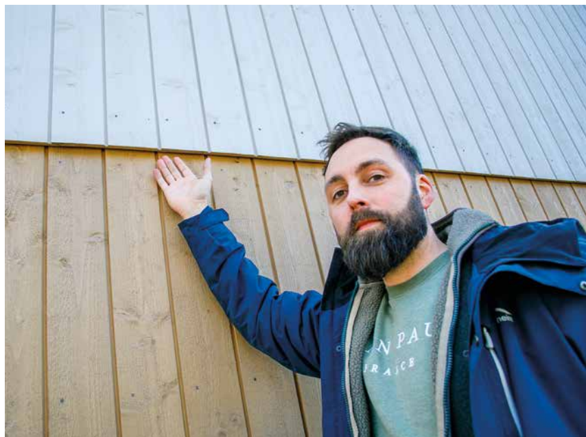
Ved å dobbeltlekte ut et «sprang» midt på vegg, får fasaden bedre lufting. – Det gir også litt mer liv til fasaden, sier Idar Sør-Reime.
