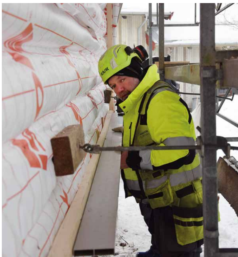
KILER: Spikerslagene må justeres med kiler for at påforingen skal bli rettere enn den gamle tømmerstokken. Marius Hansen sjekker underveis.
