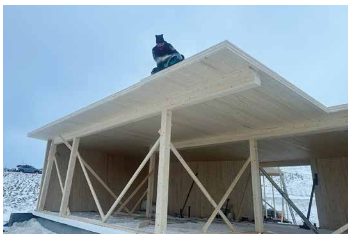
– Med massivtre får vi ei full skive, og dermed veldig god vindavstivning, noe som er viktig i de klimatiske forholdene vi har her. (Foto: Olav-Inge Alfheim)
