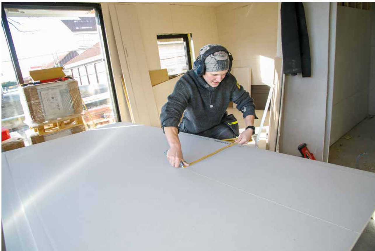
Tømmermann Daniel Berre tilpasser gipsplaten med hjelp av tommestokk og tapetkniv.
