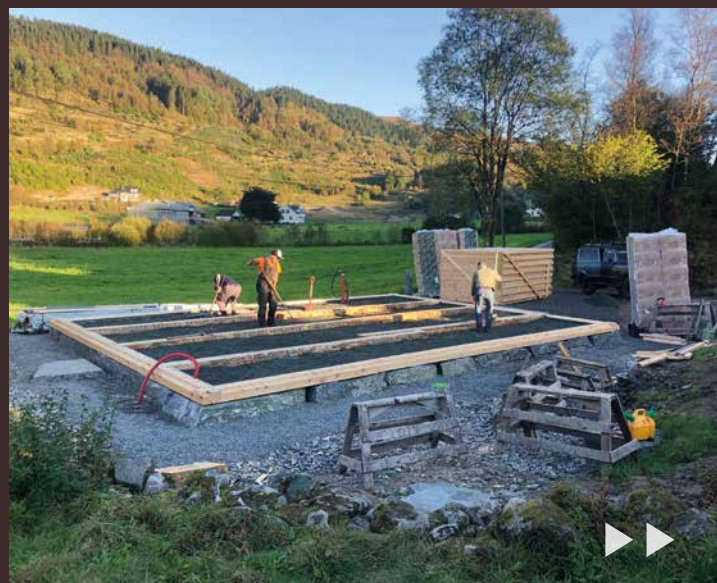
James Henry Alexander Chaplin bearbeider grunnmuren med leire etter at rammen er lagt. [Foto: Magne Kleiveland]
