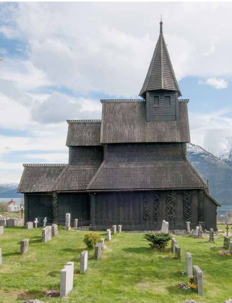
Urnes stavkirke ble pakket inn i plast og behandlet med den giftige gassen phospin mot husbukk så sent som i 1983. (Foto: Leif Anker, Riksantikvaren)
