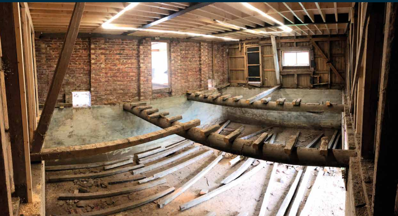
Det gamle høyrommet og møkkakjelleren da det var tømt og klart for gjenoppbygging med grus, singel, kjøresterk isopor, plast og betong.
