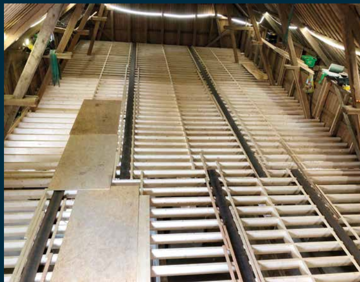
Låvegulvet (her sett nedenfra og ovenfra) bæres av nye stålbjelker av typen HEB 200, som deler tregulvet i tre spenn. Mellom stålbjerkene ligger tre bjelkerekker med 2x8-tommers bjelker med cc 300 mm. Gulvbordene består av 1,5x8 tommer plank. Deretter ble det isolert med 250 mm Glava.
