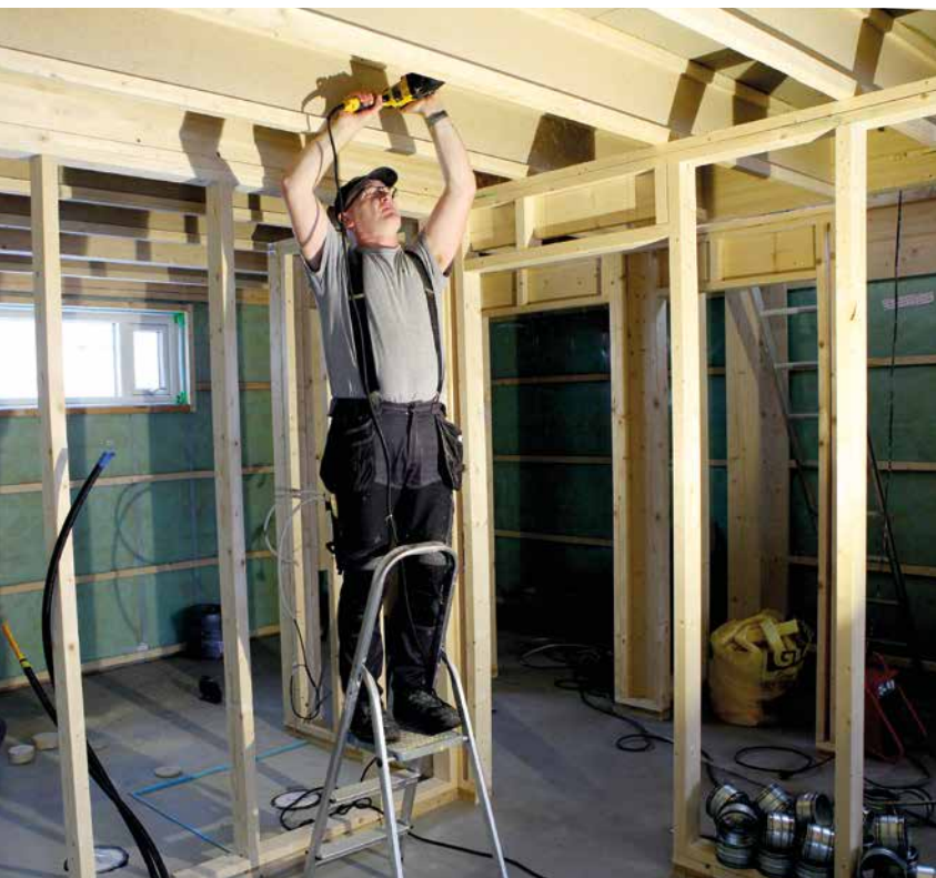
Tømrer Artūras Novickis i Bygg og Hageanlegg borer gjennomføringer i en av de nye boligene.
