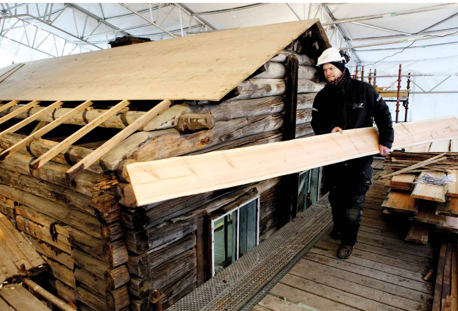
Tømrer og bas Lars Gustav Dal med et nytt takbord som senere skal monteres over det som nå er taket på bygget.
