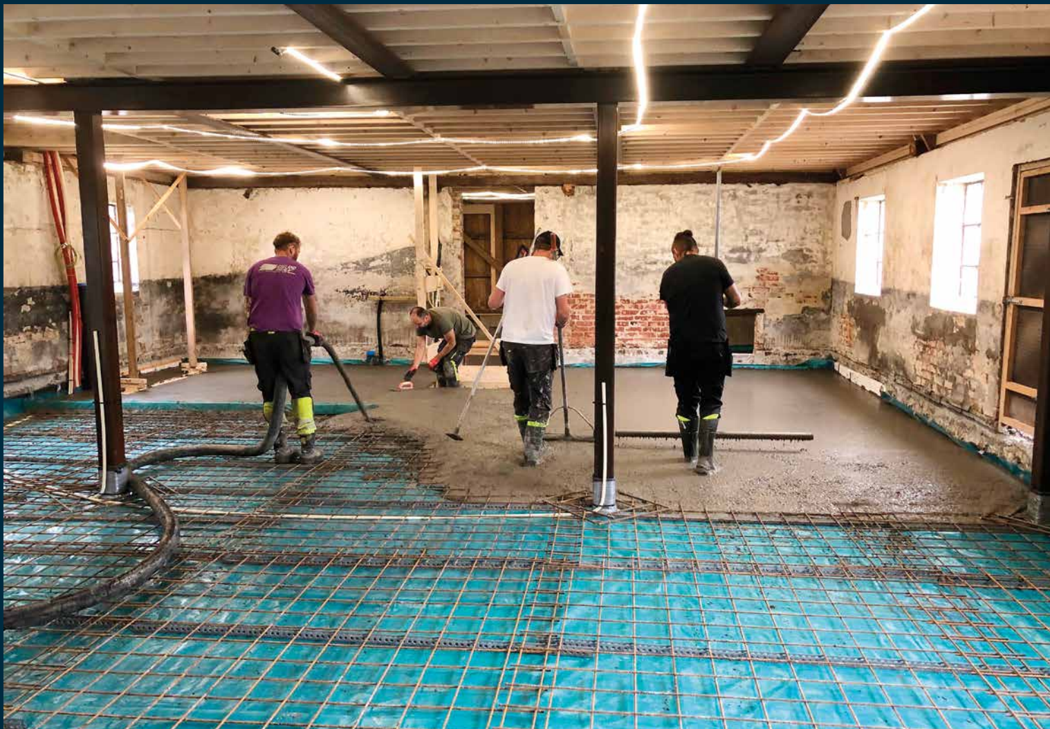
120 mm betong er lagt ut over et dobbelt lagt plast, for å hindre at betongen sprekker etter tørking. (Alle foto på oppslaget: Privat)
