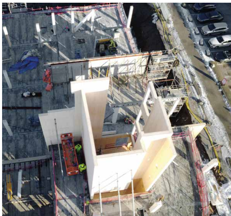
Montasje av bæresystemet Flexiwood og trappehus av massivtre. (Foto: Betonmast)
