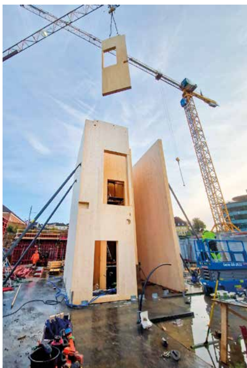
Montasje av bæresystemet Flexiwood og trappehus av massivtre. (Foto: Betonmast)
