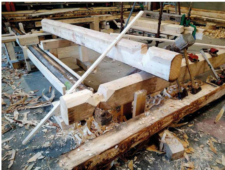
Her lafter de nye stokker «opp-ned» på de gamle, godt bevarte tømmerstokkene fra huset. Dette er inne i hallen til snekkerverkstedet på Dal i Eidsvoll. De nederste originale stokkene var fjerde rad på huset på husmannsplassen. (Foto: privat)
