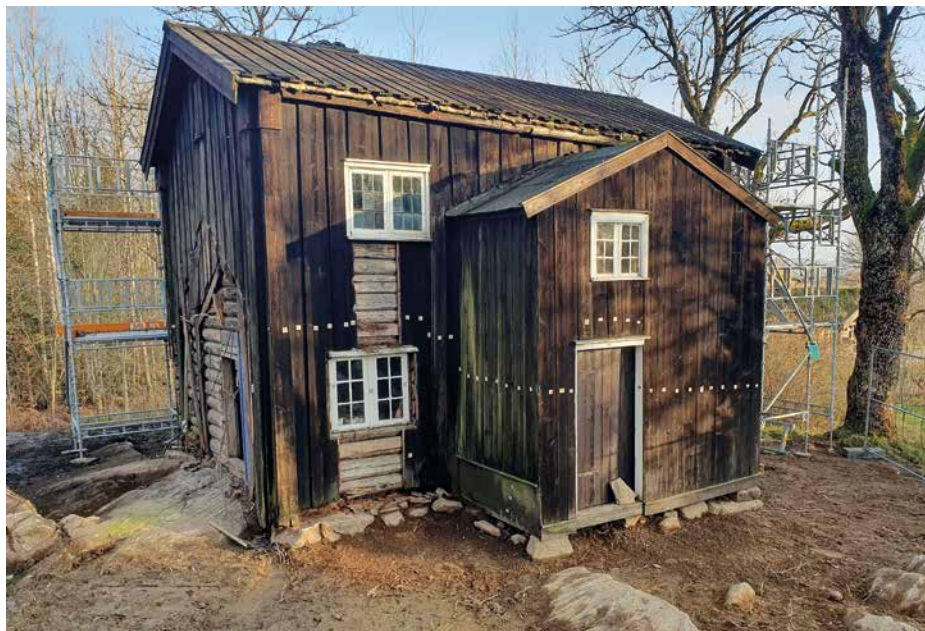
Dette er hovedbygningen på husmannstunet i en forberedende fase av prosjektet. (Foto: privat)
