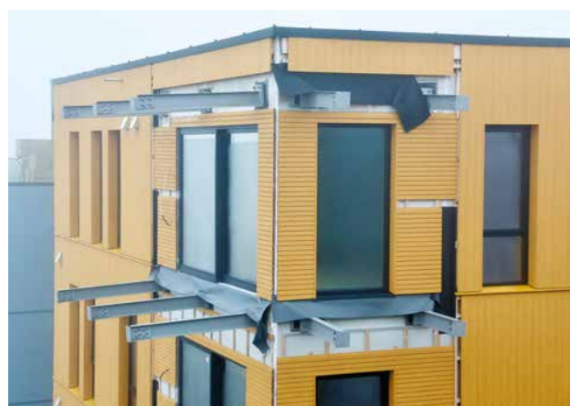
Balkongene er prefabrikkerte elementer som hektes rett på fasaden.
