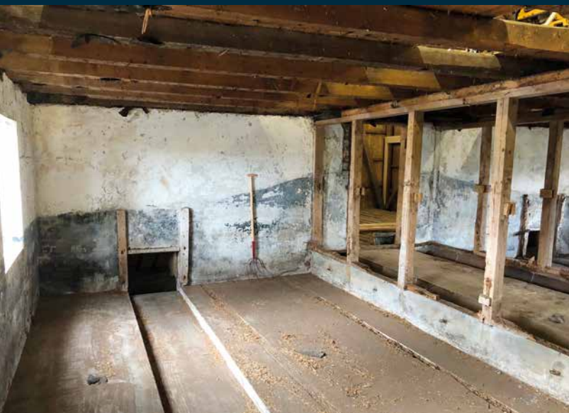
Brønnhuset, som nå blir bad, før renoveringen startet.
