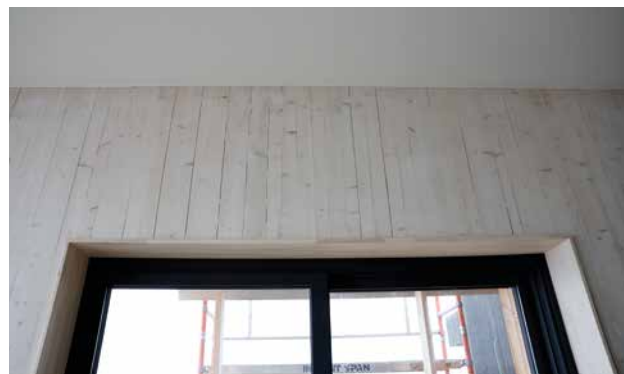
Tømmerne bruker en egenutviklet løsning for listing i leilighetene som skjuler gipskantene.
