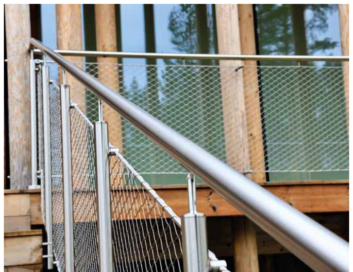
Rekkverket utenfor museet er smidd på Ø.M. Fjelds verksted i Kongsvinger: – Det var tegnet på en måte som ikke lot seg bestille, så vår egen smed laget det. Det ble så fint at vi beholdt det som det er. Rekkverket tar ikke blikket fra bygget, men utførelsen er nydelig.
