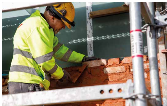
Den nederste delen av fasaden kles med ombrukstegl.
