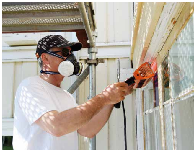
VARMELAMPE: Som Arve Øfstaas viser, må det gamle kittet varmes opp så det blir lettere å fjerne.
