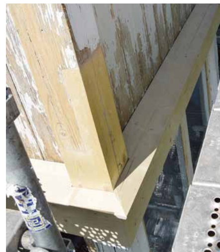
UTBEDRET: Vannbord og deler av hjørnestolpen er skiftet ut.
