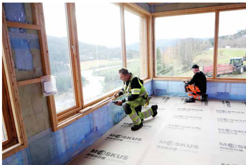
Tid for å lekte ut veggene innvendig, fra venstre Magne Vidar Rise og Stein Havdal.
