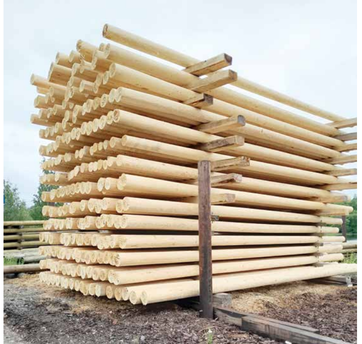
Alle 380 tresøyler ble høvlet og bearbeidet på plassen i løpet av tre uker. (Foto: Lasovsky Johansson Architects og Lipinski Arkitekter)
