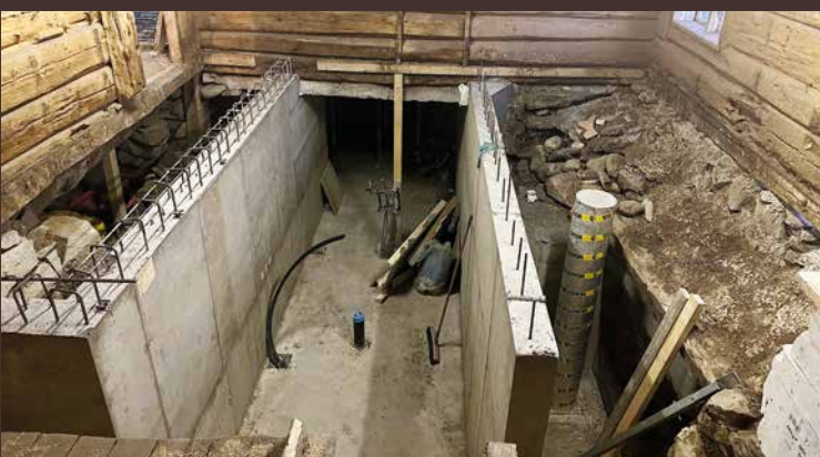
Her var det sauefjøs. Her blir det støpt vegger i kjelleren, før det støpes etasjeskiller. Denne delen av huset blir stue og kjøkken.
