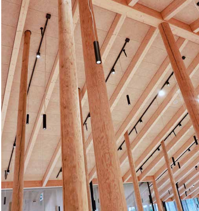
Det kompakte taket er isolert med Rockwool, skråner 17 grader og bæres av limtretragere som er inntil 18 meter lange.
