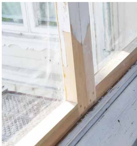
NYTT TRE: Råtne deler av vindusramma er erstattet med tettvokst furu som er felt inn til halv ved og skråskjært for at vann blir ledet bort.
