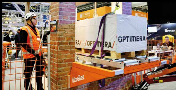
LIFTROLLER fra Bergen demonstrerer hvordan tunge materialer kan transporteres opp fra bakkenivå og inn i etasjen de skal brukes.
