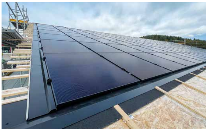
Deler av taket dekkes med solceller som erstatter ordinær takteking. Installert effekt blir 75 kWp.
