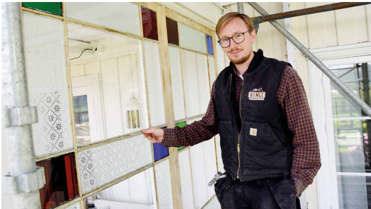
FRITT FOR KITT: Alt gammelt kitt og gammel maling er fjernet, nå skal nytt kitt og nye strøk med linoljemaling snart legges på, demonstrerer Eirik Gimle.
