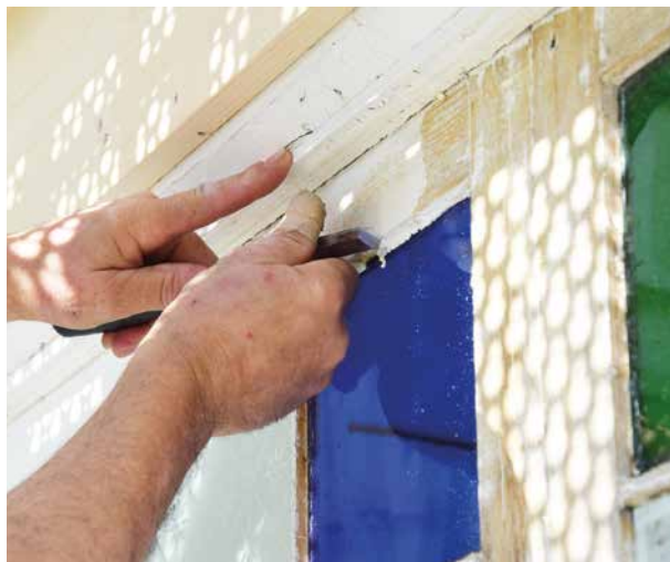
VARMELAMPE: Som Arve Øfstaas viser, må det gamle kittet varmes opp så det blir lettere å fjerne.
