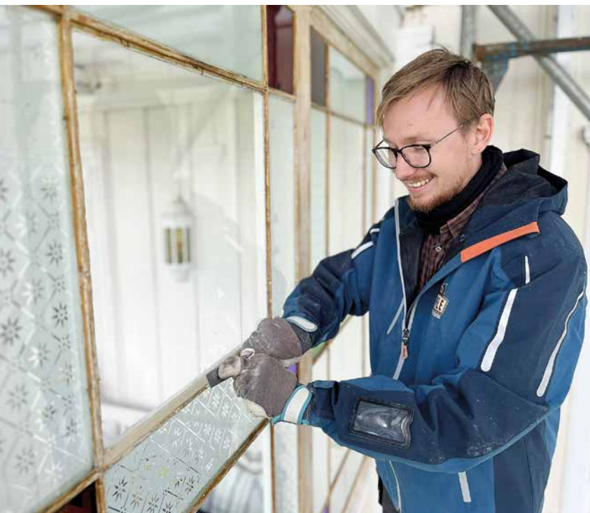
NYTT KITT: – Det gjelder å være nøye når nytt kitt legges på, forklarer Eirik Gimle. (Foto: Arve Øfstaas)
