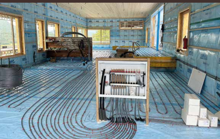
Her er det lagt rør for vannbåren varme – bergvarme.
