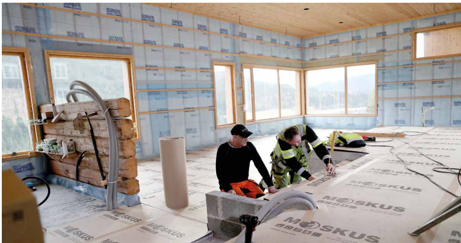
Her var det sauer, kyr og hester før i tiden. Nå er det moderne bolighus, med fire meter fra gulv til tak, og panoramautsikt ut mot naturen. Tømmer Stein Havdal (t.v.) og daglig leder og tømmer Magne Vidar Rise i LH Bygg Entreprenør måler opp trappetrinnene på et «repos» som er laget inne i huset for å gi arkitekturen en brytning.
