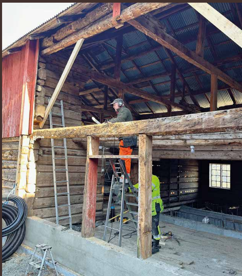
Her blir det hovedinngang. Her skal det settes opp limtretrager som bæring over første etasje i det nye huset.
