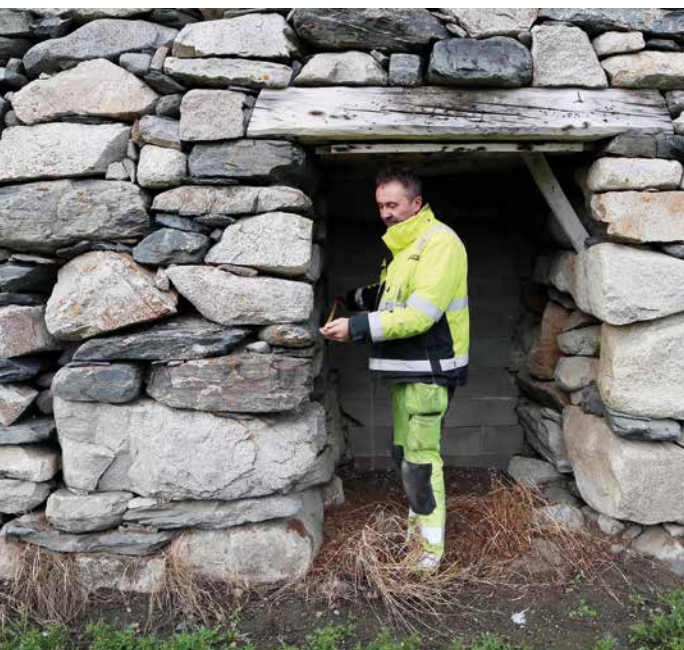
Naturstein grunnmuren til det gamle fjøset er opptil 1,5 meter bred. Her står Magne Vidar Rise og måler veggen.
