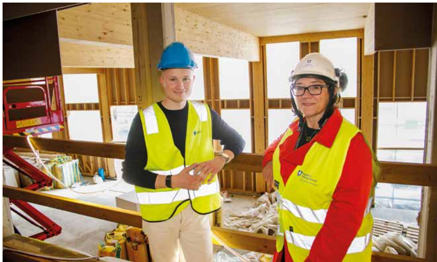
Både Mathias Grønnestad og Edeltraud Munding er fornøyd med at byggingen forløper uten problemer siden hele bygget var nesten ferdigprosjektert før byggestart.
