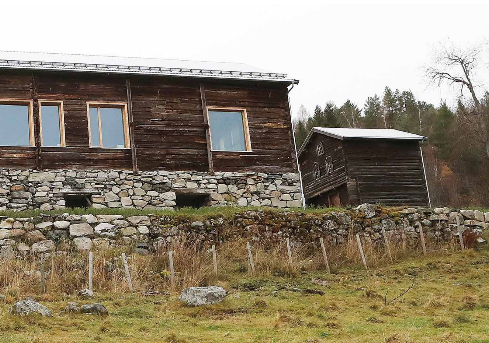
Naturstein grunnmuren til det gamle fjøset er opptil 1,5 meter bred. Her står Magne Vidar Rise og måler veggen.
