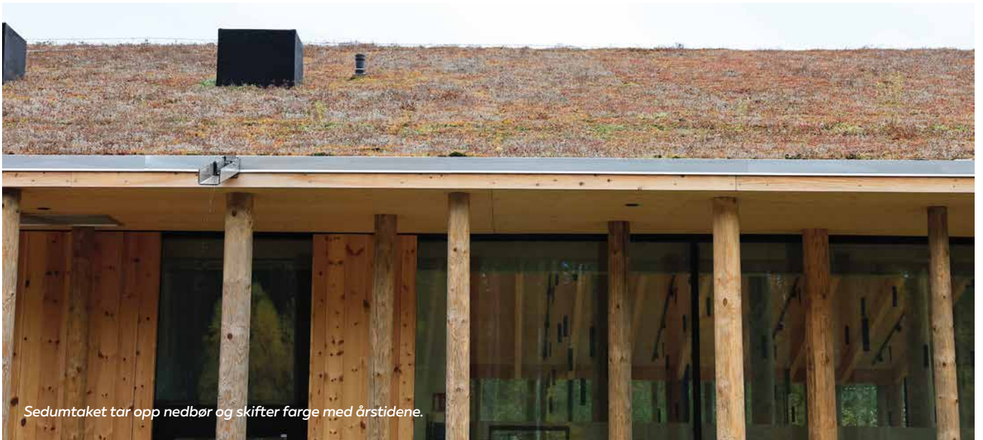
Det kompakte taket er isolert med Rockwool, skråner 17 grader og bæres av limtretragere som er inntil 18 meter lange.
