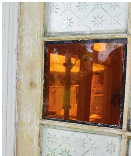
TETTE ÅRRINGER: Når gammel maling er skrappt av, kommer tette årringer til syne.
