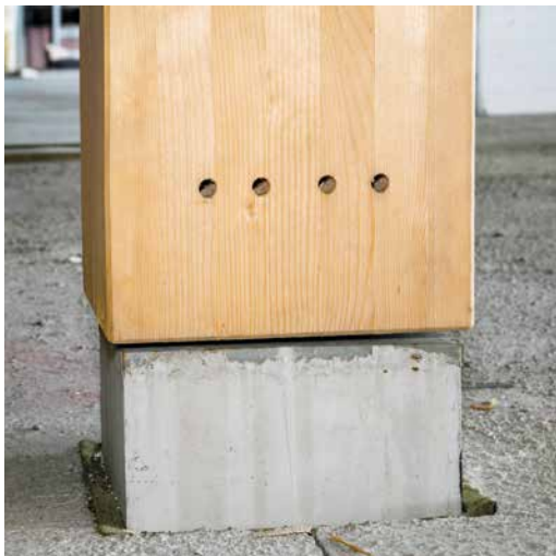
Bæresystem i massivtre er skrudd sammen med en såle av betong i bunnen av bygget.
