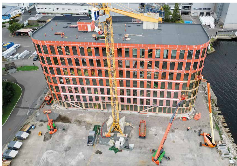
Veggelementene er ferdig montert på Lumber 5 i september. (Dronefoto: Veidekke)
