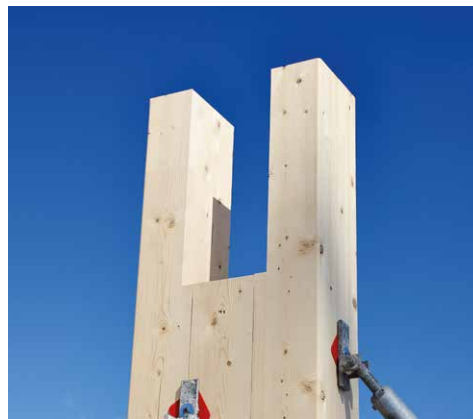
Tregaffelen som er designet av Oslotre er effektiv og reduserer materialbruk.
