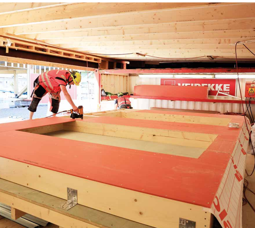
Tømrerne i Veidekke Bygg bygger veggelementene til Lumber 5.
