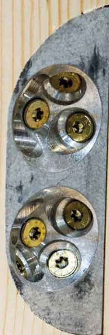
CLT-koblingen blir installert under prefabrikasjonen. [Foto: Motek]
