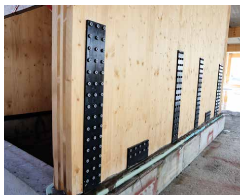
Forankring av heissjaktene ned mot fundament
