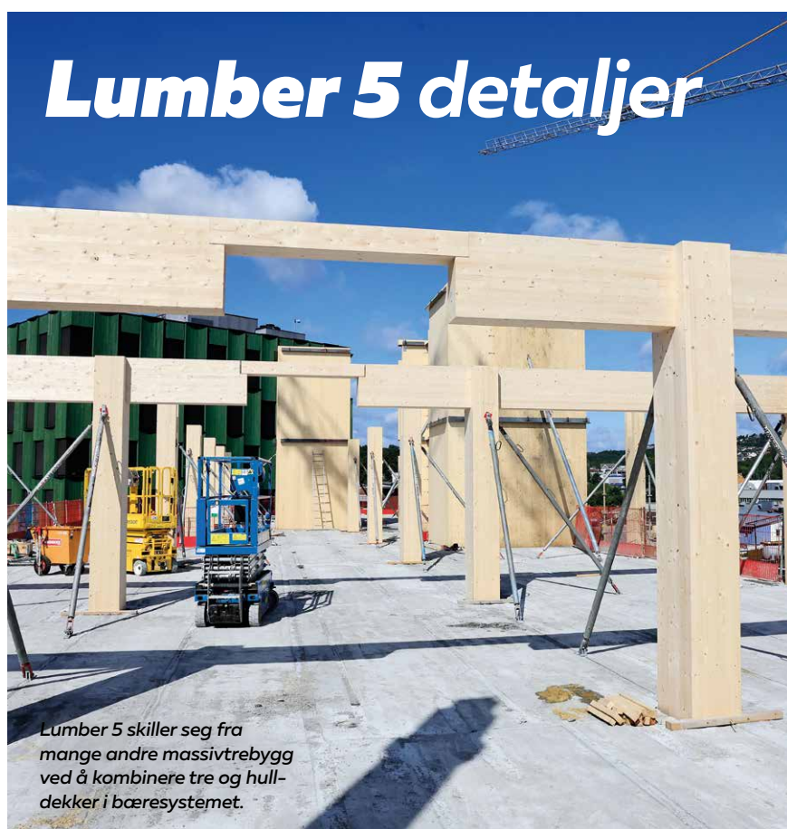
Komplekse og presise knutepunkter i tre leveres prefabrikkert til byggeplass.
