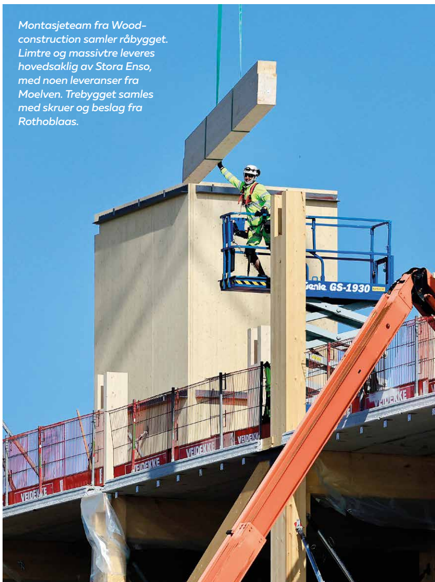
Veggelementer heises inn på Lumber 5 i Vågsbygd.
