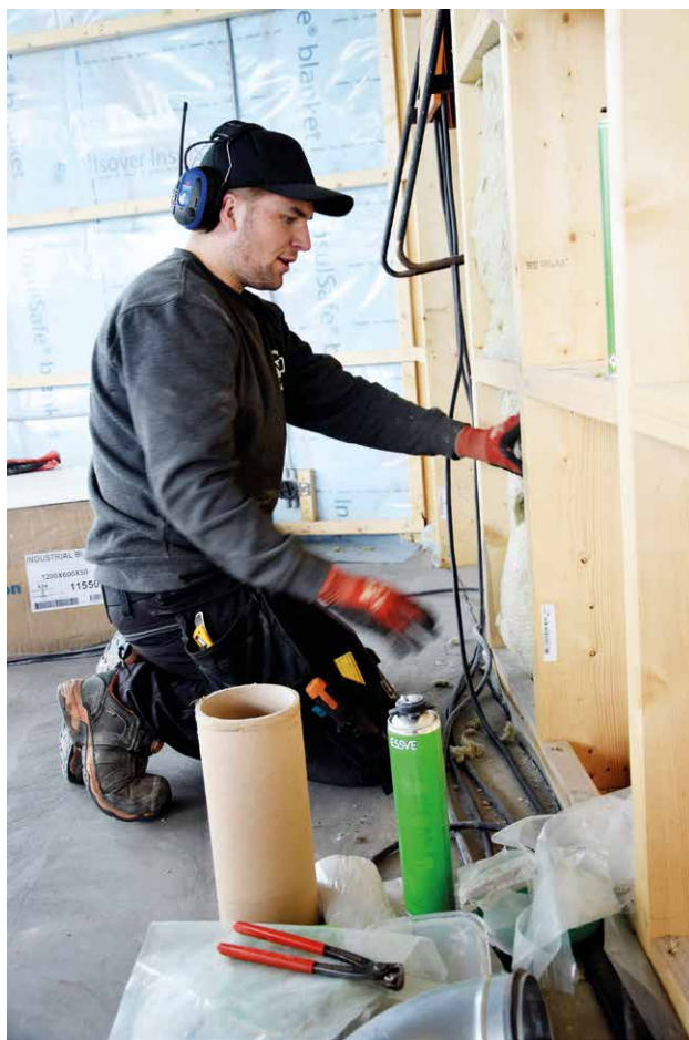
LYDDEMPING: Lærlingen Mikal Trønes Nygård sørger for isolasjon og lyddempende plater i en innvendig vegg.
