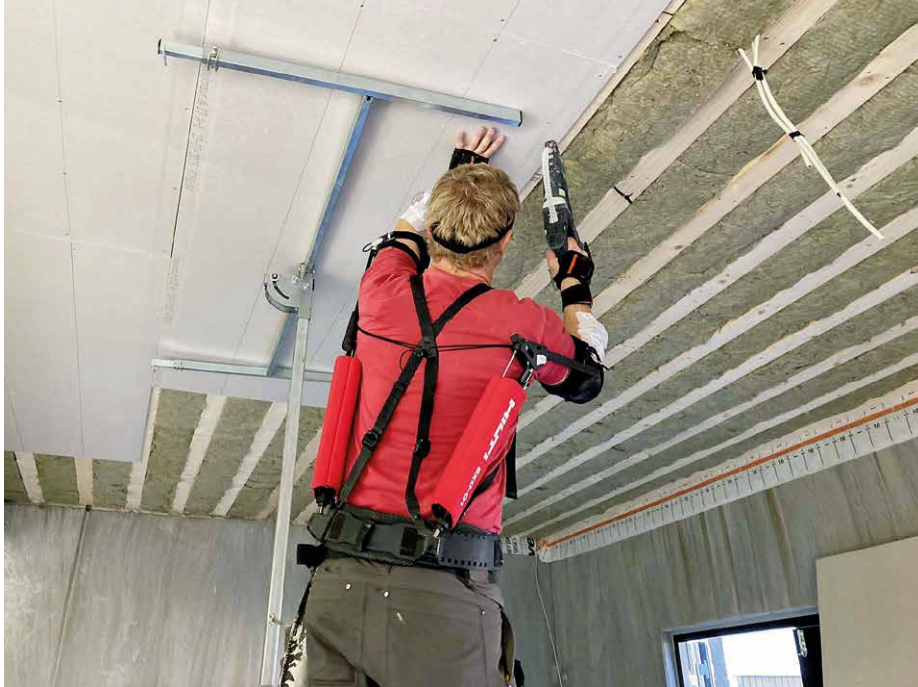
FORSKNING I FELT: Denne gangen er forskningen gjort ute på byggeplassen med tømrere som gjør akkurat den jobben de gjør til vanlig. (Foto: NFA)
