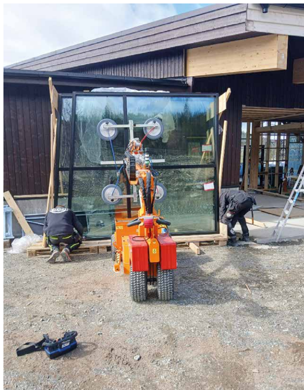
LØFTEHJELP: Et av de store og tunge vinduene gjøres klar til montering. (Foto fra byggeprosessen: Ole Henrik Ryttersveen)
