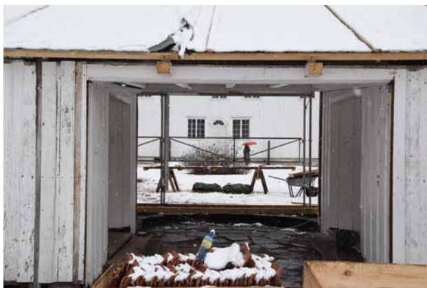
RETTET OPP: Åpningen i vestfløyen viser at oppjekkingen har vært virkningsfull.
