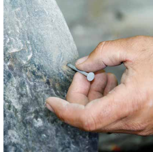
Skiferen festes til lektene med galvaniserte skiferspiker.
