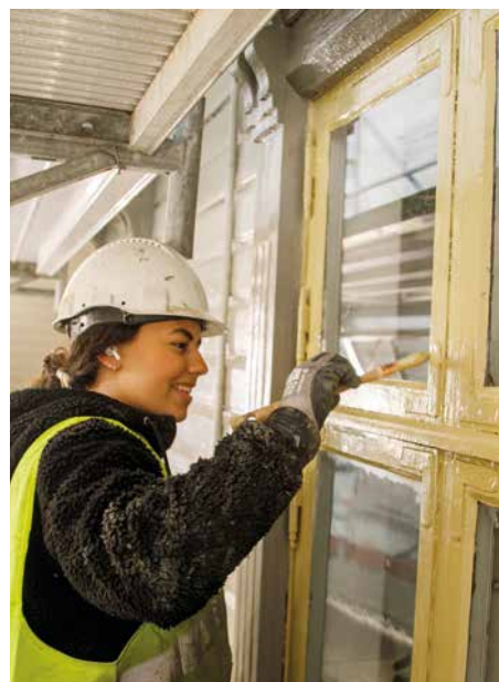
Lærling i H&M Malerservice, Elina Elamraoui, maler vinduslister med linoljemaling.
