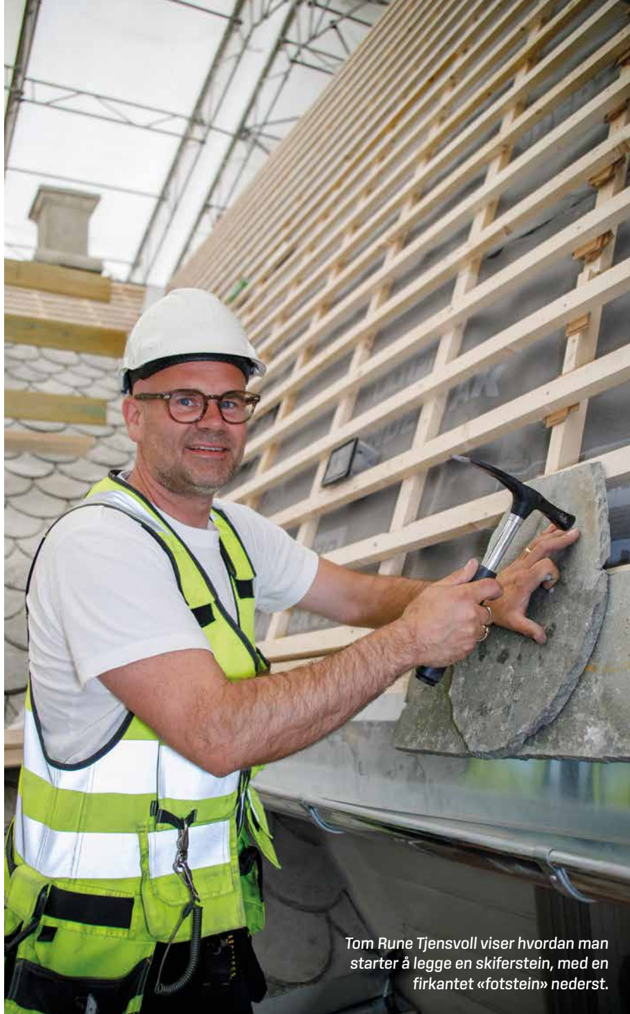
Skiferen festes til lektene med galvaniserte skiferspiker.
