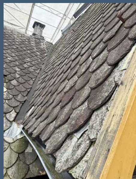
Slik så den gamle skiferen på taket til Nedre Lagårdsvei 2 ut, før den ble tatt ned. Den viste seg å være i for dårlig kvalitet til å kunne gjenbrukes. (Foto: Tom Rune Tjensvoll)
