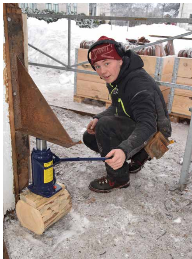
JEKKES FORSIKTIG: Bygget skal jekkes opp, noen steder helt opp til 15 cm, men det må gå gradvis så konstruksjonen skal gå seg til, forklarer Philip Brøvig.
