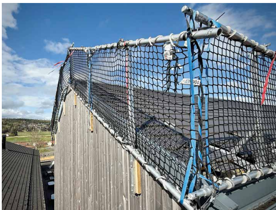
Roofbarrier er velegnet til bygg der stillas er lite hensiktsmessig, som krevende og høytliggende takflater. Sikringen er godkjent for flate tak og skråtak med opptil 60° helning og gavl.
