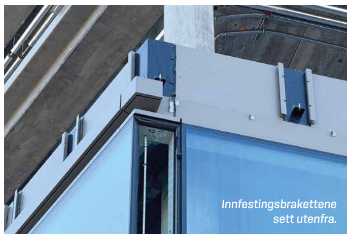
Innfesting er forberedt med braketter i bæresystemet, og betongbjelker er senket i forkant for å håndtere toleranser.
