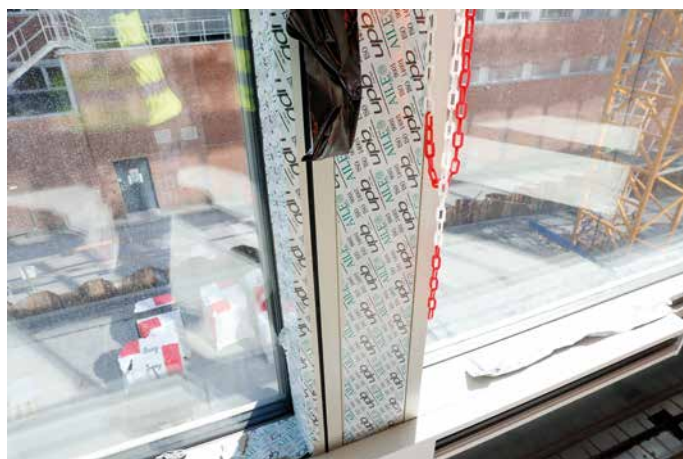
Hulrommet isoleres. Alt annet er ferdigprosjektet.
