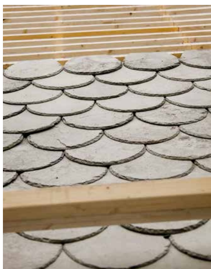
Her er man kommet halvveis med å legge det nye skifertaket.
