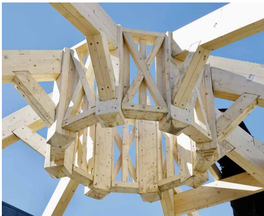
Elever og tømmerlærlinger har kappet og montert alle deler til møtepunktet i pergolaen. (Foto: Byggmesteren)
