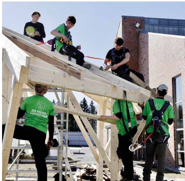
De franske elevene fra Sylva Campus lærer å sikre seg riktig når de jobber i lave høyder med pergolaen utenfor Tærudalen ungdomsskole. (Foto: Byggmesteren)
