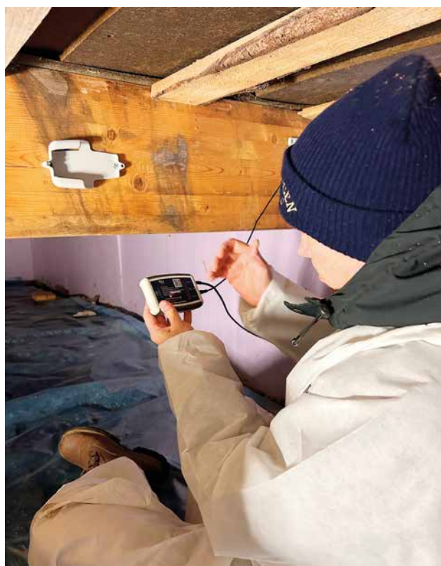
Sensoren og fuktproben monteres i krypkjellerens treverk. (Foto: Privat)
