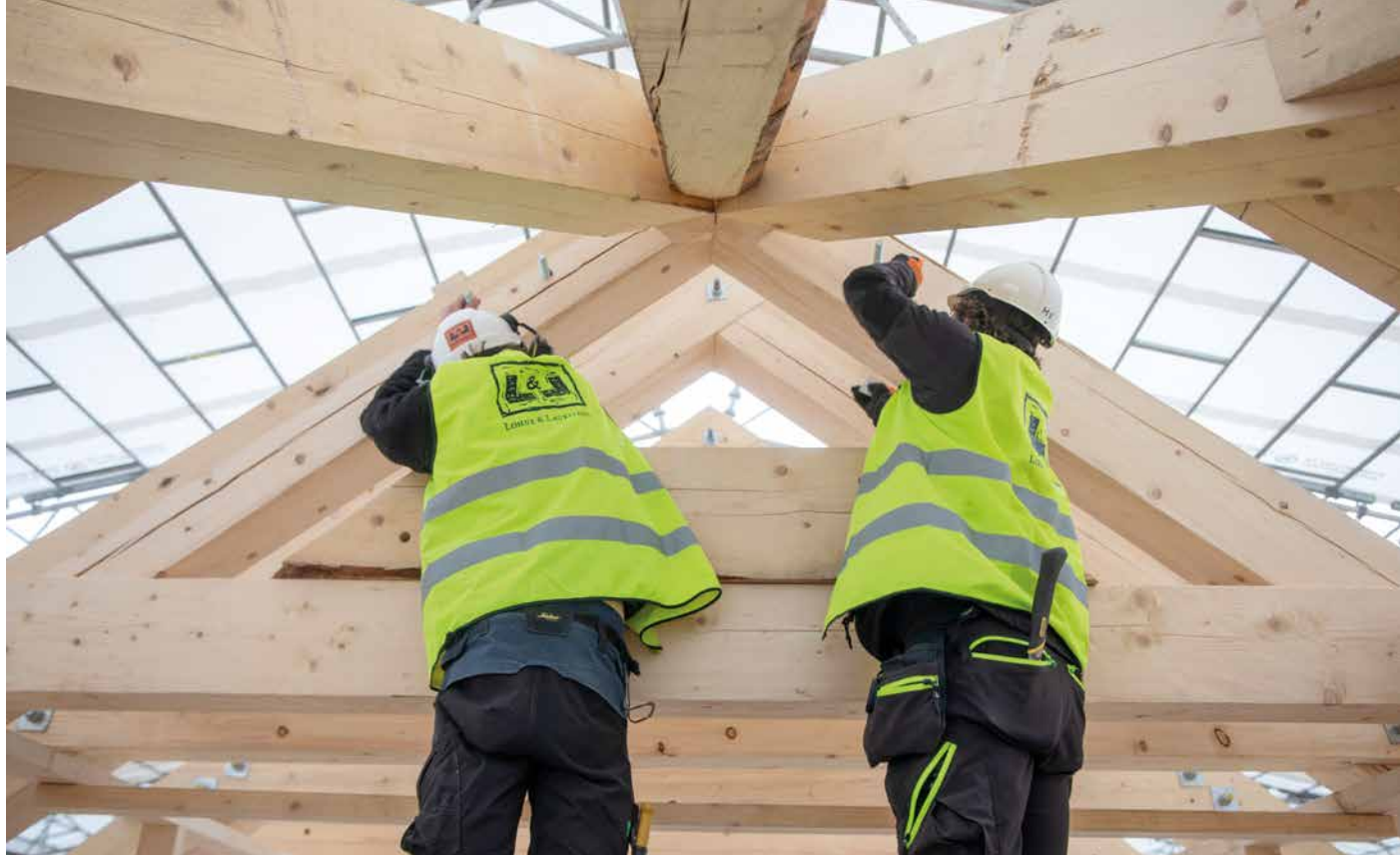
Tradisjonelle sammenføyninger i takkonstruksjonen på Festningsrestauranten i Oslo. (Foto: Sandra Olsen)
