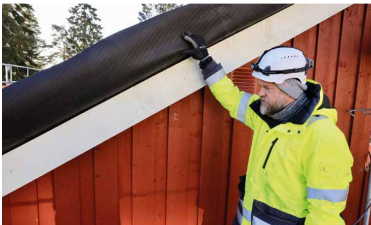
Fra 5 til 15 cm takutstikk: – Nå bygger vi ut takutstikkene slik at beboerne slipper å fjerne taket hvis de ønsker å oppgradere isolasjonen senere.
