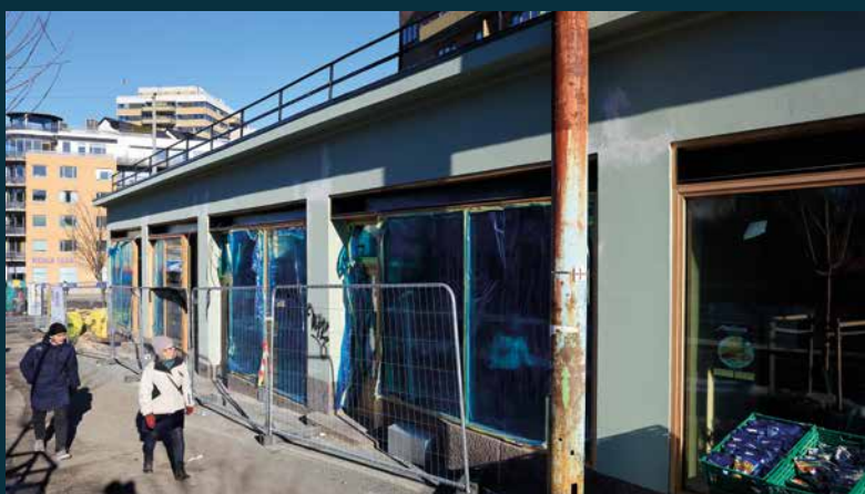
Prosjektmaster totalrehabiliterer næringslokalene på Galgeberg. Det vernede teglsteinsbygget innfrir alle moderne byggekrav, samtidig som materialene er tidstypiske fra byggeår.
