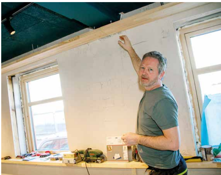
– Alt trearbeid er laget på byggeplass, inkludert flåten i ytterkant av rommet, sier Morten Aske.
