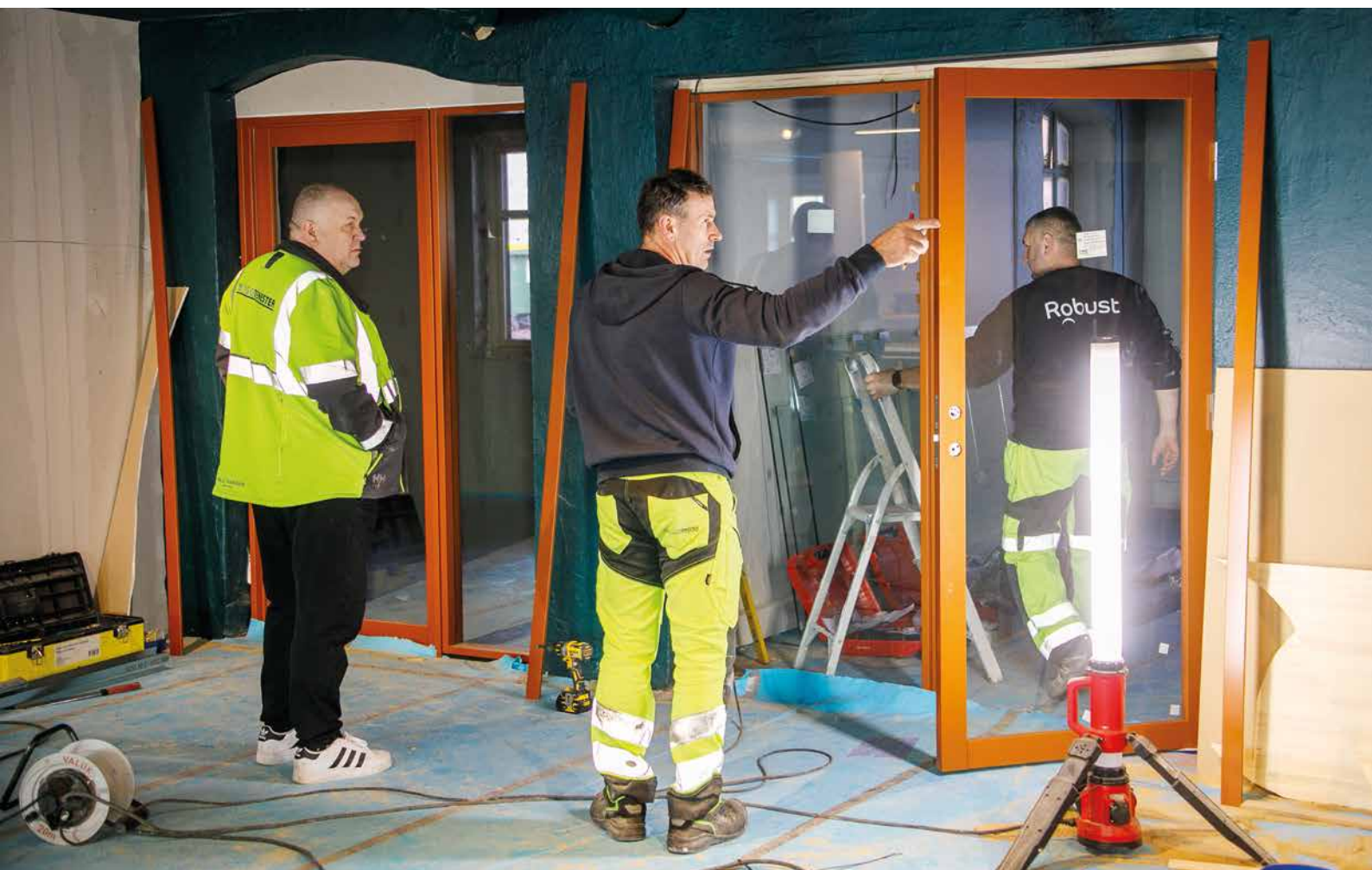
– Det er alltid spennende å rehabilitere gamle bygg, sier prosjektleder Frode Gudmestad (t.v.) fra TS Byggtjeneste som blant annet har satt inn nye innvendige glassdører. Her sammen med Janusz Pawlak og Zbigniew Kordaszewski (som er innleid).
