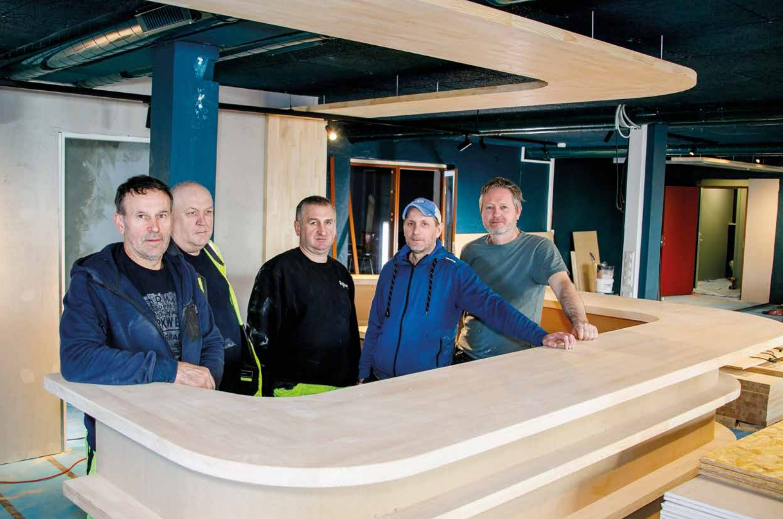
Snart kan Litteraturhuset i Stavanger ta i mot gjester med serving fra en stedsbygget bardisk. Fra venstre Janusz Pawlak og Frode Gudmestad fra TS Byggtjeneste, Zbigniew Kordaszewski innleid i TS Byggtjeneste, elektriker Roy Østreim og Morten Aske, snekker og driftstekniker hos byggeier.
