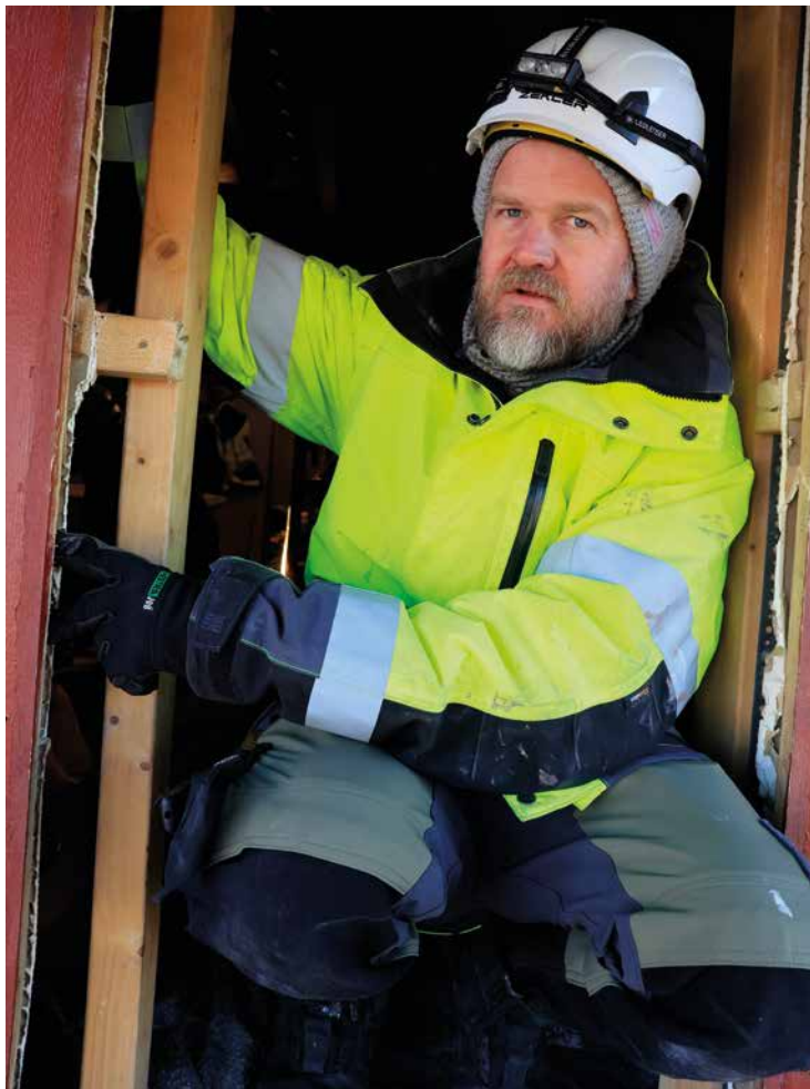
– Dette tilbygget manglet lufting bak kledningen, sier Ken Røstvik.
