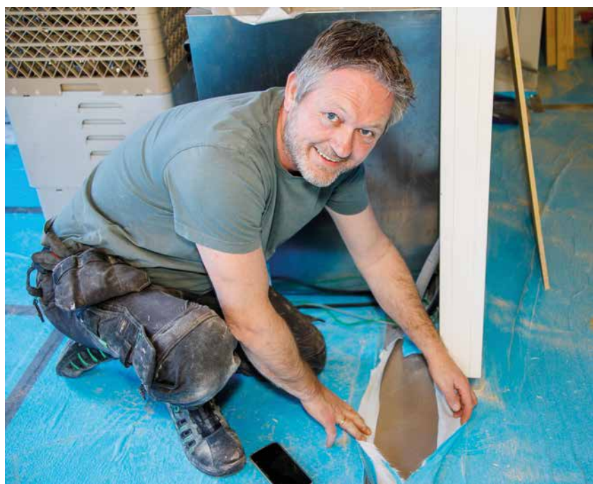
– Vi har rettet ut gulvet med flytbetong, sier Morten Aske.
