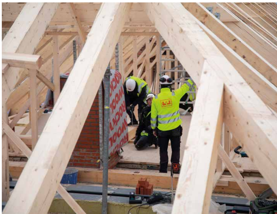
Tradisjonelle sammenføyninger i takkonstruksjonen på Festningsrestauranten i Oslo. (Foto: Sandra Olsen)
