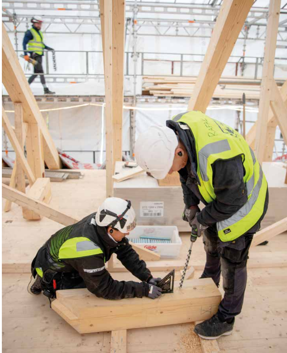
Presis boring for bolter av Ola Scheele Moe og Rafal K. Albinski. (Foto: Sandra Olsen)
