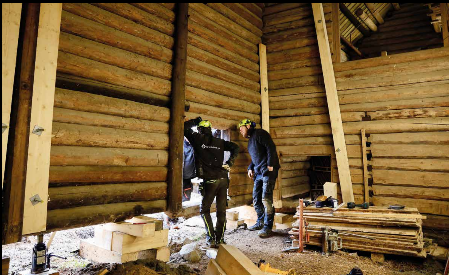
Tømrerne følger nøye med på konstruksjonen i kortveggen mens den heves.
