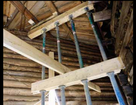
Støttebjelker avlaster og sikrer mot uønskede bevegelser i låven mens konstruksjonen stabiliseres.
