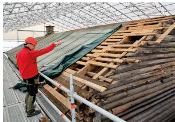
Taket på svalgangsbygget kan også bli læringsarena for tømrere og andre håndverkere.
