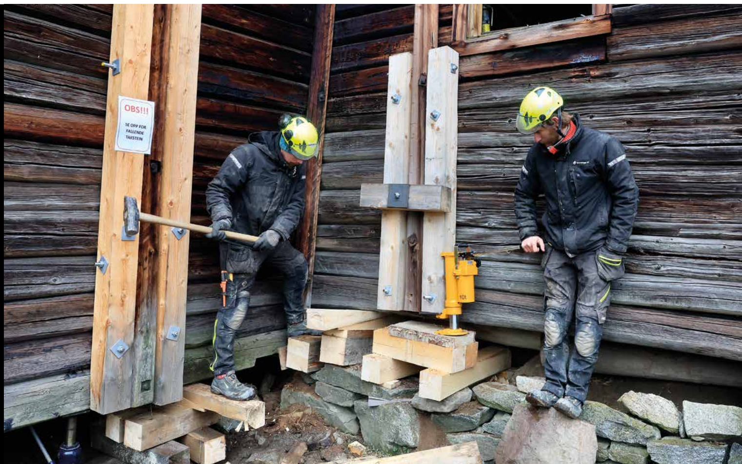
Tømrerne Martin Røsholm og Petter Egerberg fra Aabol Tradisjonsbygg Grendebygg AS banker inn sidestøtter til jekken på kortveggen av låven på Gamle Hvam Museum.
