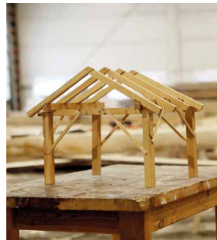
Dette er en modell av et grindbygg.
