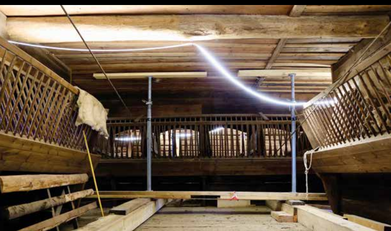
Stallinnredningen er fredet og en av årsakene til at låven stabiliseres. Innredningen preges av nydelige håndverksdetaljer.
