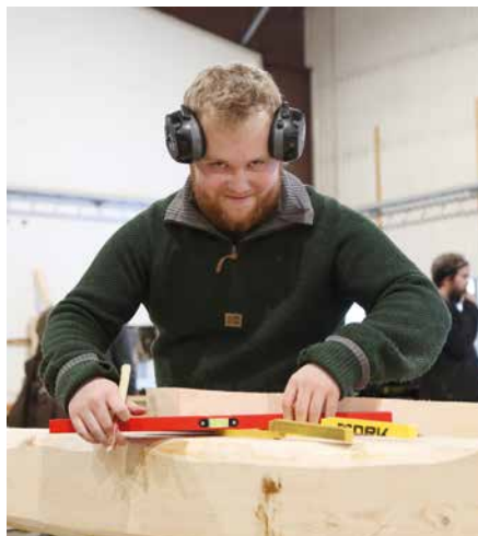
Elev Ola Kjersem Staurset skal felle inn et skråbånd - avstiver - på den ene grinda til grindbygget.
