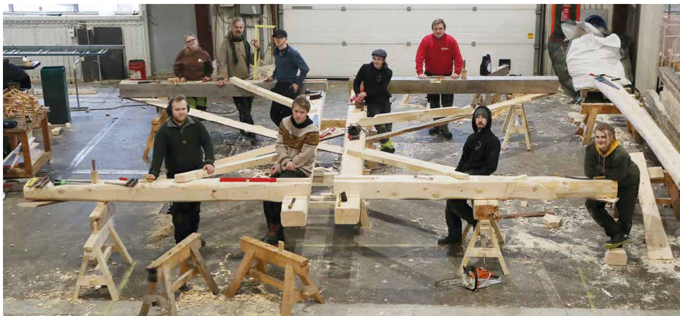
Her arbeider de åtte elevene i Vg 2 tømmer med et grindbygg på Hjerleid. De lager to grinder som skal settes i sammen til et grindbygg: Syver Alfred Linnerud, Svein Tynnøl, Torbjørn Torbo, Ola Kjersem Staurset, Thomas Kristoffer Aamo, Henriette Aiyana Ylva Kodvaag, Oscar Egede-Nissen, Jonas Tjeldflaat og gjestelærer Richard Andersen (bakerst nummer to fra venstre).
