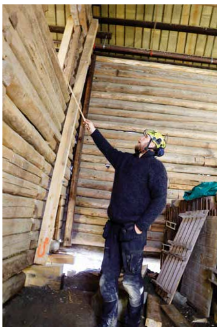
- Låven siger hele veien, men mest i langveggene og kortveggen inn mot tunet, forklarer tømrmester Håvar Aabol.
