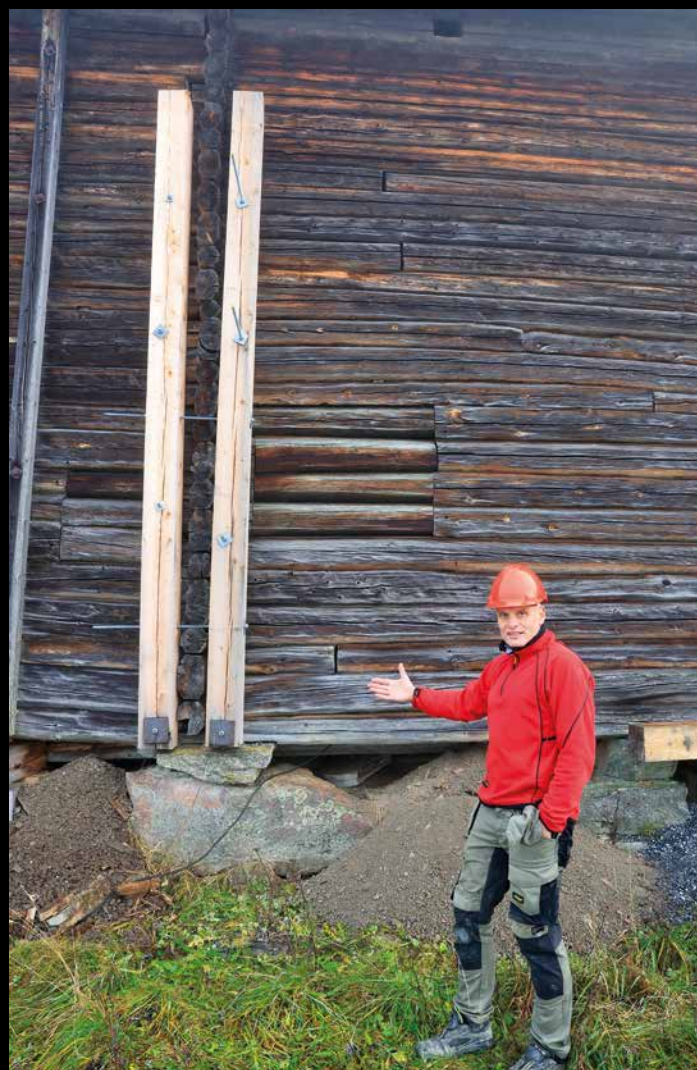
Vegard Røhme viser hvordan nedsiden av låveveggen rettes opp.
