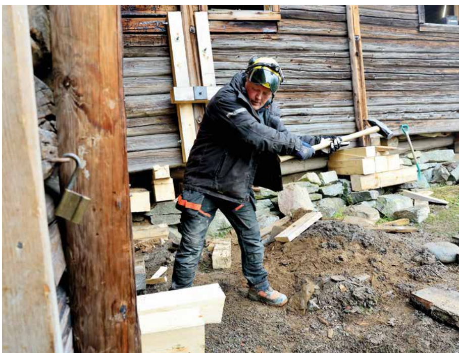
Tømrer Bjørn Engen fra Aabol Tradisjonsbygg AS banker inn ekstra støtte i langveggen mot tunet.
