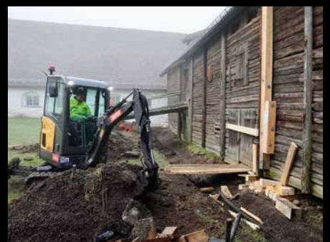
Aas & Nordal Entreprenørforretning er hovedentreprenør på prosjektet og sikrer grunnforholdene rundt låvebygningen.
