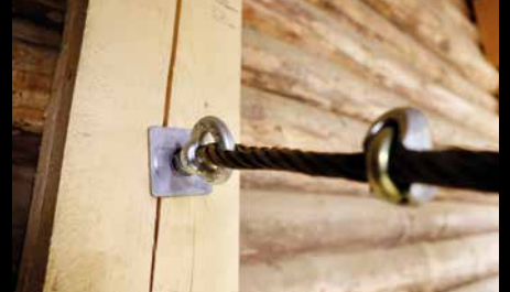
Alt henger sammen med alt: Bjelker, stålvaiere og støttebjelker er viktig for å stabilisere laftebygningen under jekkingen.
