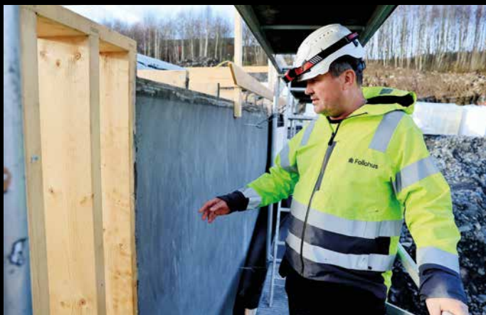
- Her er det litt jordtrykk, så sideveggene av sprøbetong er solide 25 cm i bunn og 15 cm i toppen, med bolter som forbinder trekonstruksjonen til betongen, forklarer byggeleder Eivind Halvorsen.
