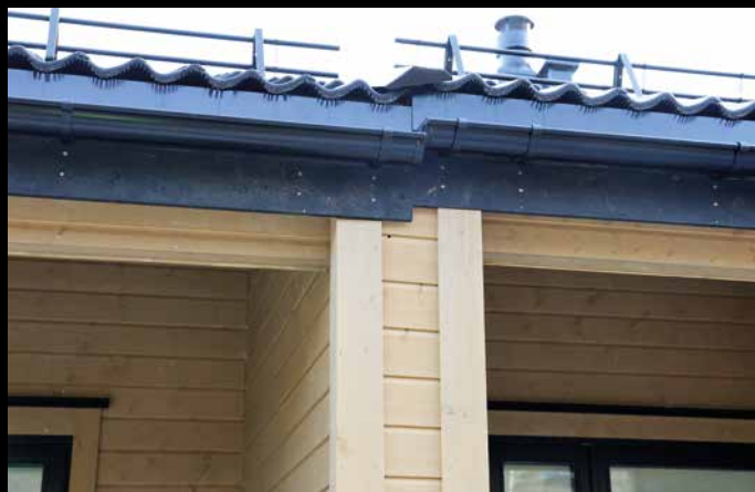
Selv med K-pakker er det høydeforskjeller mellom rekkehusene som må løses på plassen.
