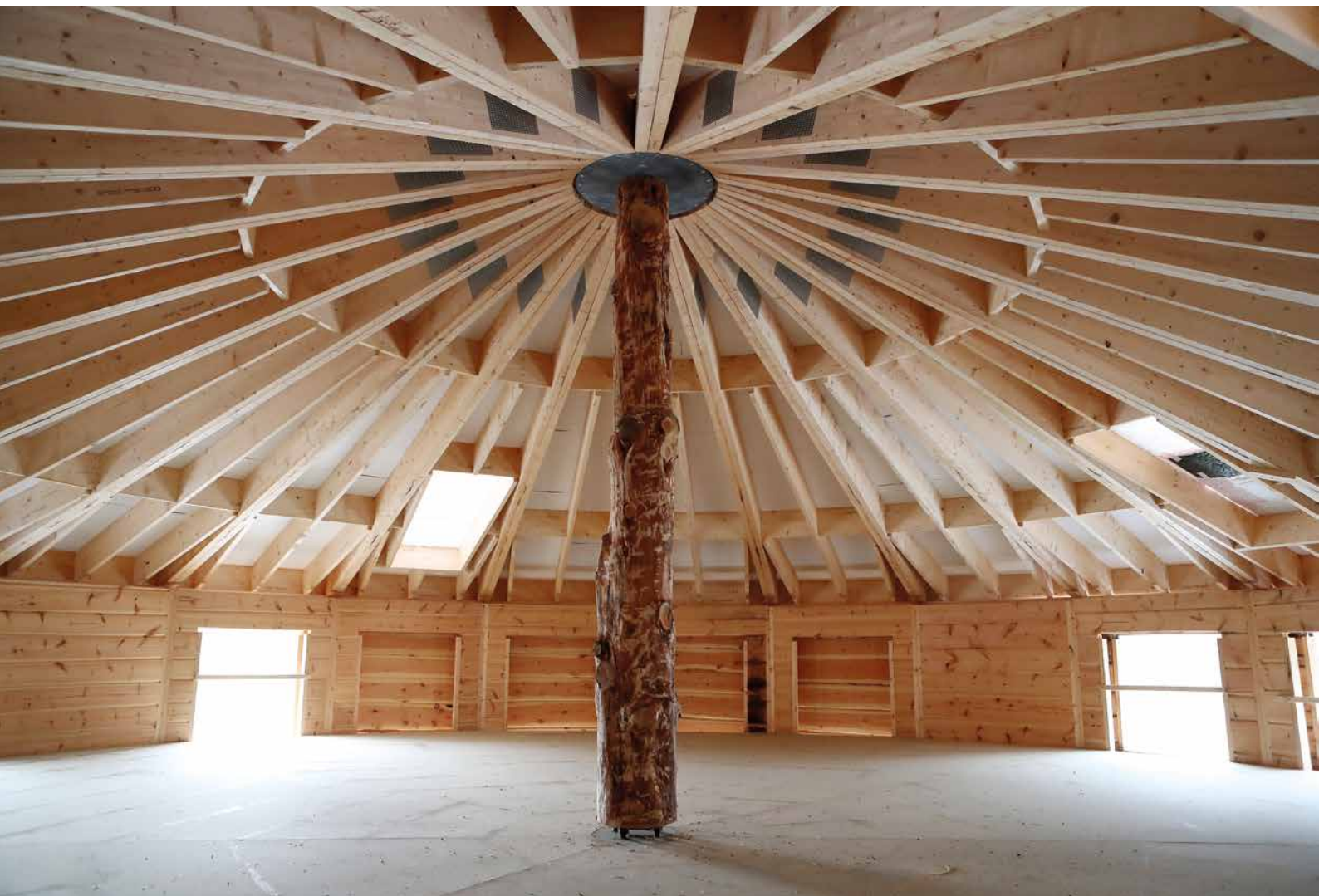
Her er den øverste etasjen med det spesielle taket. Dette skal være et stort, åpent rom. Både taket og veggene består av prefabrikkerte elementer. Stolpen i midten er fra et tre som ble hogd på eiendommen hvor huset er bygd.
