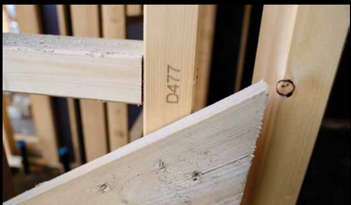
Alle komponenter er prosjektert med freste spor og merkede deler.
