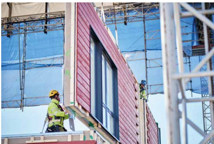
Den nye veggkonstruksjonen Kerto-Ripa muliggjør bygging av enda høyere trebygninger. [Foto: Metsä Wood]
