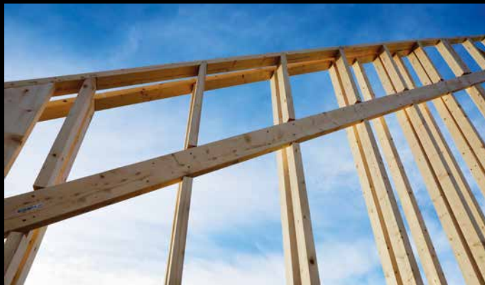
Klar for brannskillet: Stenderne til to ny rekkehus er klare med innfelt spikerslag vegg/himling fra Are.
