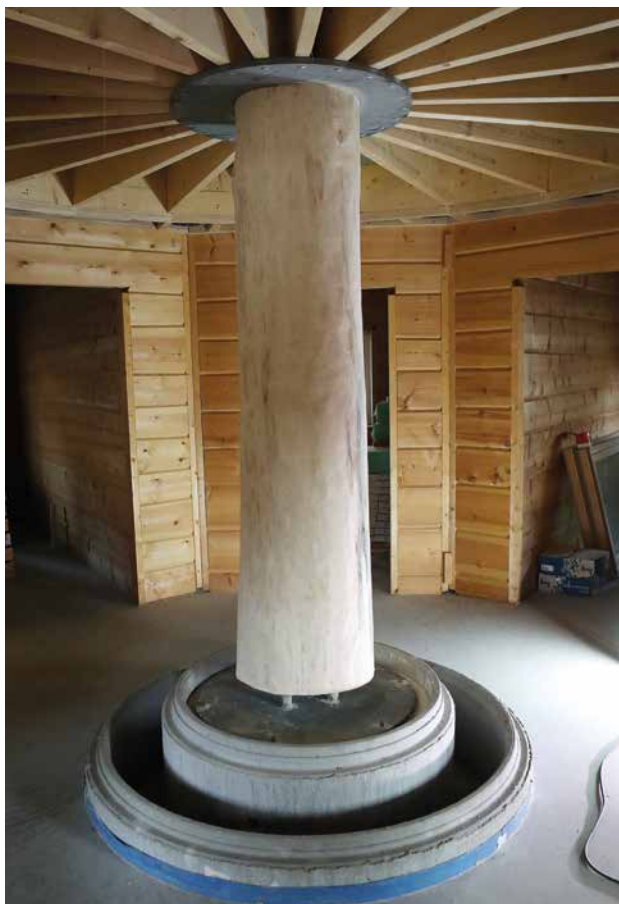
I den støpte plata er det festet en stålplate med gjengestål og fire mutrer. Gjengestålet er festet til søyla – tømmerstokken. Om veggene synker, kan denne stolpen skrus ned ved hjelp av mutrene på gjengestålet.
