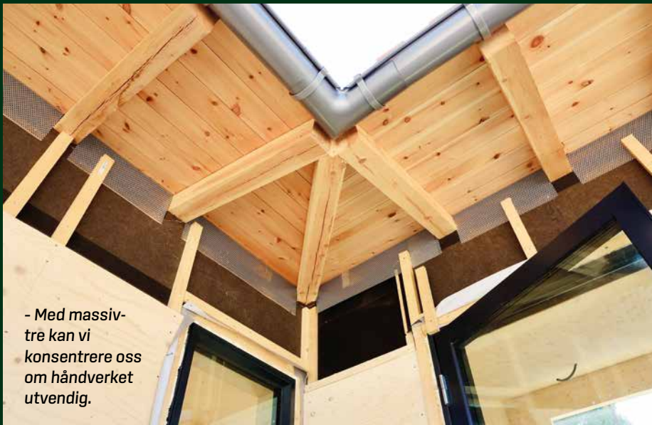
- Spilekledning er nøyaktig arbeid: Det går 19 furuspiler og 95 skruer på meteren.
