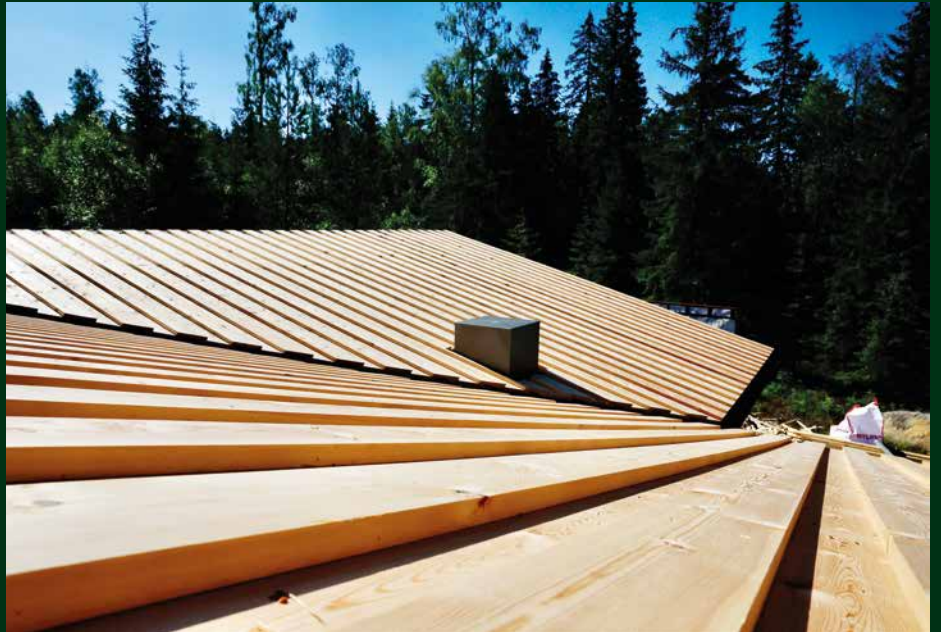
De seks meter lange takbordene av malmfuru er skrudd og ikke spikret: - Det gir bedre kontroll over festing og hindrer at taket vrir seg på grunn av vær og vind.
