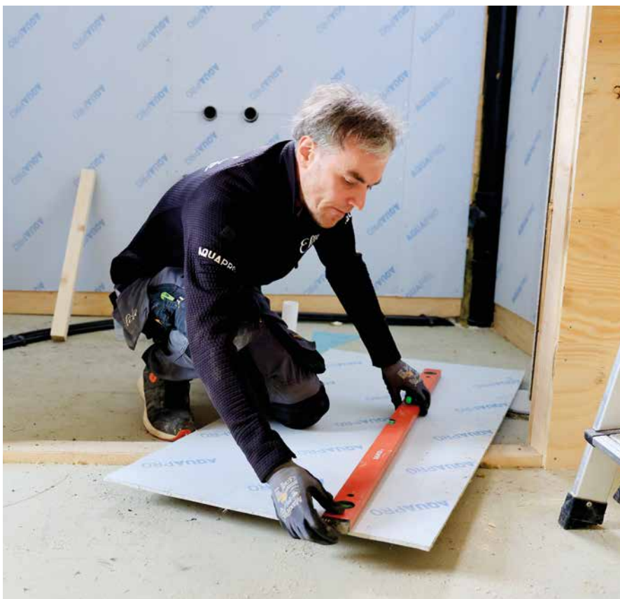
Tømrer Andrzej Glodowski skjærer til våtromsplater i dusjrommet.
