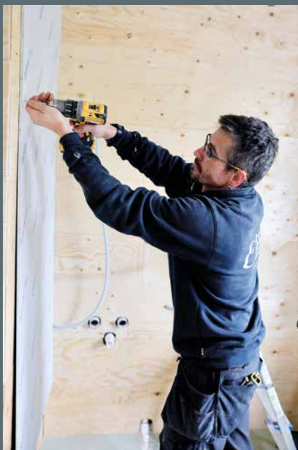
Tømrer Marcin Kaniuga skruer opp våtromsplatene – som også fungerer som membran – direkte på kryssfineren: – AquaPro membranplatene har spart oss mange timers arbeid! Den er lett, slagfast og mye lettere å jobbe med, sier Ficek.
