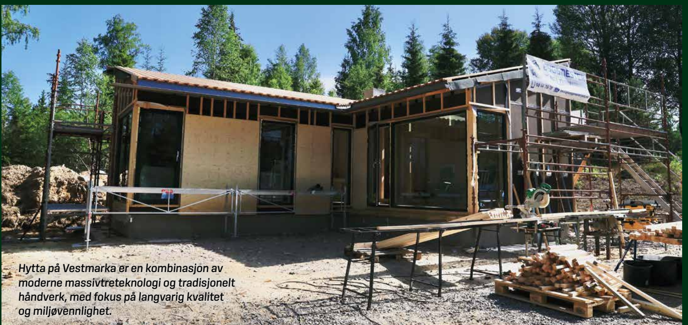
- Vi har 10 cm luftespalte for å ventilere under taket. Det hindrer at fukt og kondens kan samle seg, sier Marius Fjeld.
