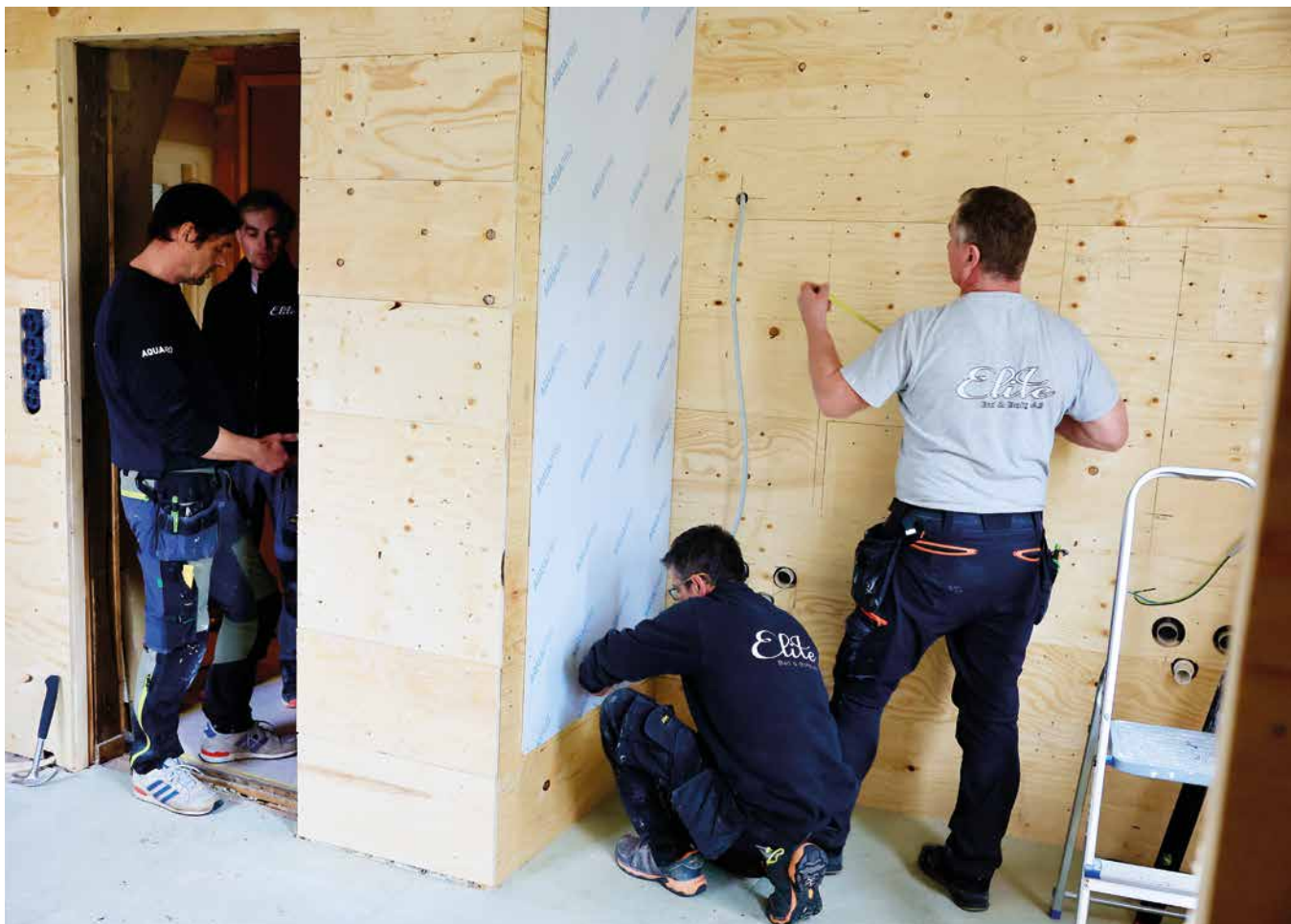
Tømrerne i Elite Bad og Bolig bygger og rehabiliterer 40-50 våtrom i året.
