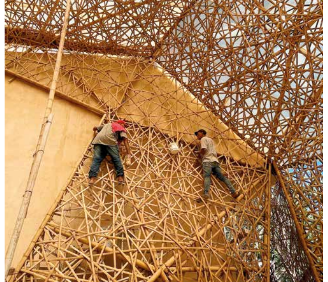
Det bygges et stadig tettere nettverk av bambus, som et spindelvev. Og bambus behandles til slutt med vannbasert relakk. (Foto: Federico López)
