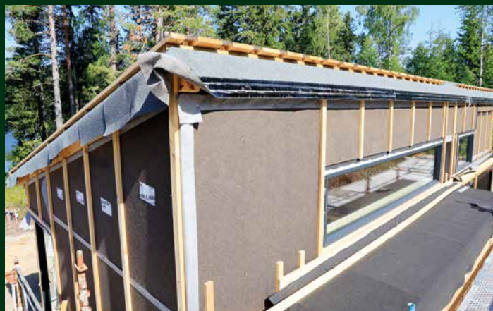
Klar for liggende kledning.
