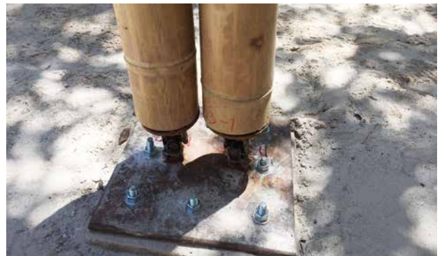
Bambus-stengene ble festet til metallkoblinger som kunne roteres 360 grader. Dette gjorde at de kunne kobles sammen i ulike vinkler. (Foto: Federico López)
