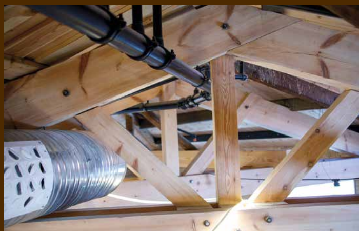
Takstolene støtter de eldre konstruksjonene og ble bygget på stedet.
