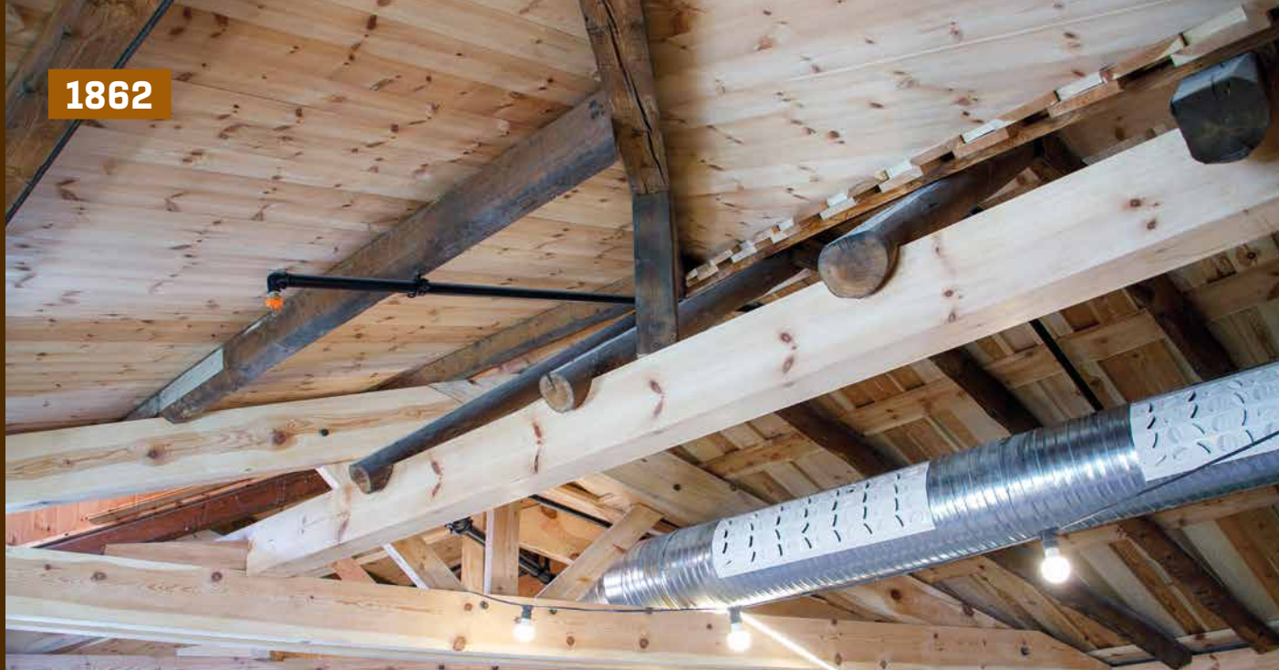
Det er brukt både originale (mørke) og nye materialer til dragere og taksperrer i taket i fjerde etasje. Dette skal ikke kles inn, men vise byggets flere lag med historie.
