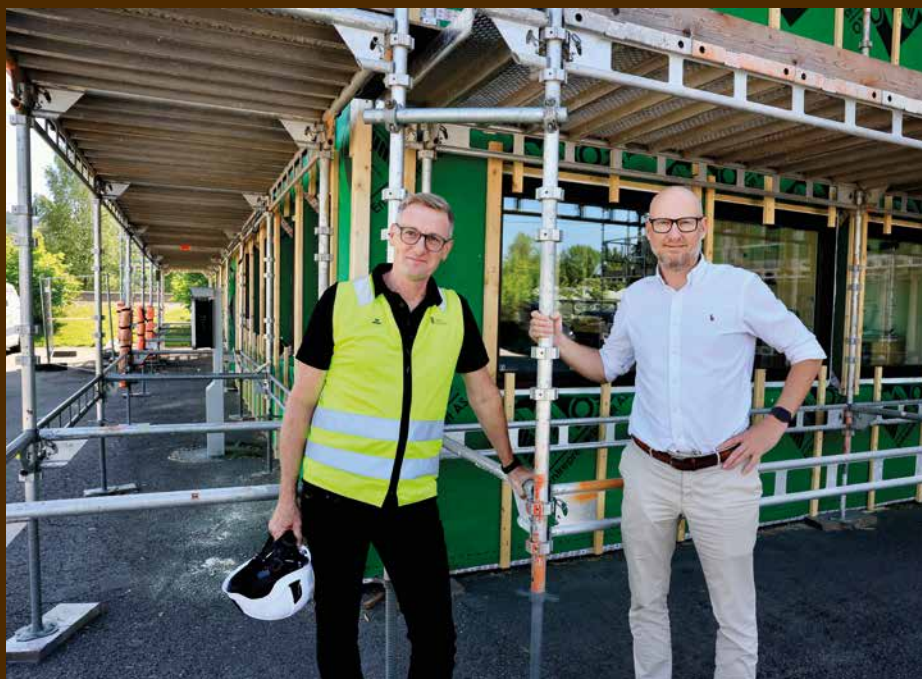
- Jeg syns dette er veldig fagmessig og håndverksmessig godt utført, sier byggherre Øyvind Rønningen i eiendomskonsernet Inference AS til byggmester Thomas Jacobsen.
