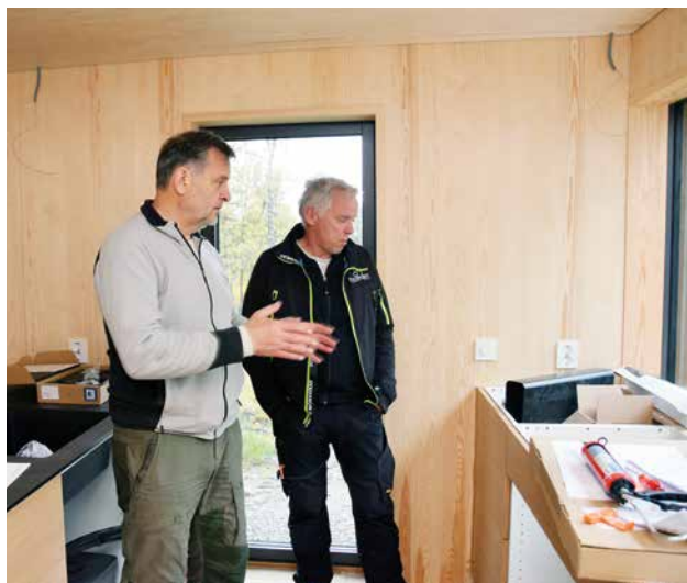
Byggmester Tor Haugstad og byggherren, Kjetil Storaas Hansen, diskuterer en detalj i kjøkkenmonteringen.
