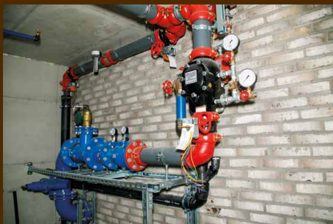
Kjelleren trengte grundig oppgradering for å sikre godt fundament. Nye teglsteinsmurer ble murt opp. Her med nytt sprinkleranlegg.
