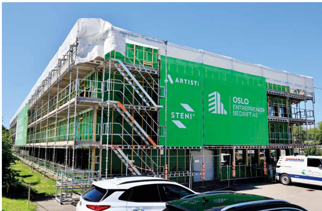
Det 60 meter lange næringsbygget i Strømsveien energirehabiliteres og får ny fasade.
