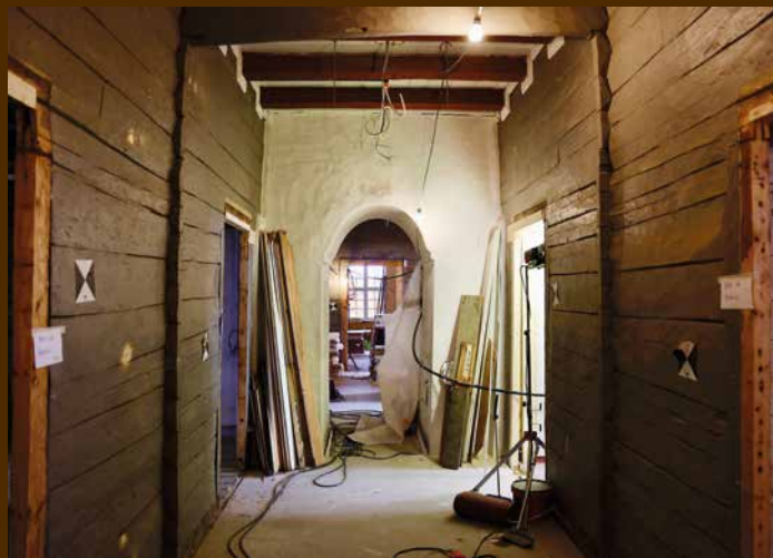
Laftveggene i Danckert Krohn er bevart og etterisolert.
