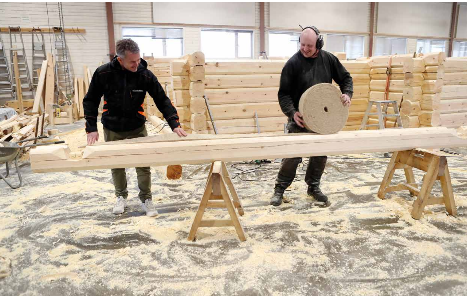
Daglig leder Ole-Petter Sætre (t.v.) og lafter Nils Bakken demonstrerer hvordan de legger naturmaterialet lin mellom stakkene. – Jeg anbefaler alle å prøve lafting. Jeg stortrives i jobben, sier Bakken.
