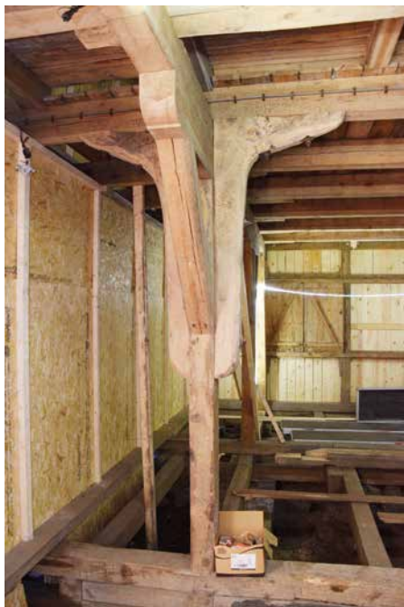
Kraftige bjelker med rotkne/snedband holder det overliggende gulvet oppe.
