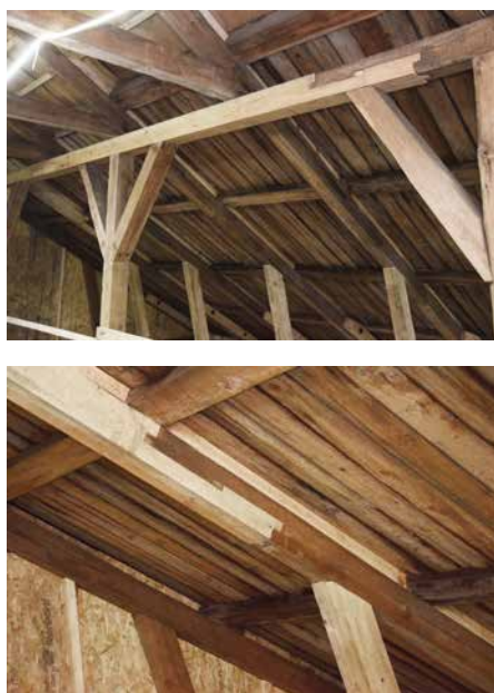
Bare skadde bjelker er byttet ut, og overgangen mellom nytt og gammelt er godt synlig.
