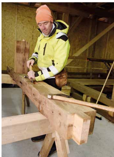
- Det er overraskende bra kvalitet på det meste av konstruksjonsvirket her, konstaterer Arvid Sollie.
