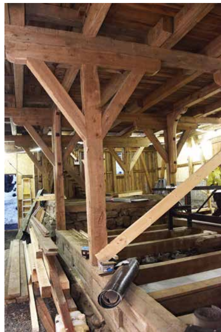
Kraftige bjelker med rotkne/snedband holder det overliggende gulvet oppe.
