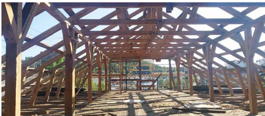
Det meste av takkonstruksjonene og bindingsverket var fortsatt i god stand da gammel takteking og undertak var tatt av. (Foto: Sollie Bygg)
