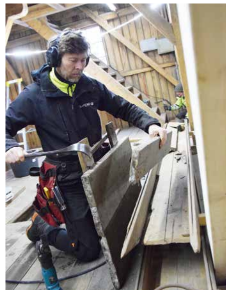
Lars Nikolai Løvdal reparerer ei av gulvplukene.
