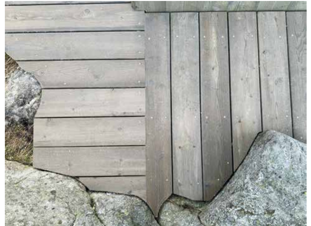
Terrassebordene er skåret til for å passe inn i berget rundt. (Foto: Ida K. Vollum)
