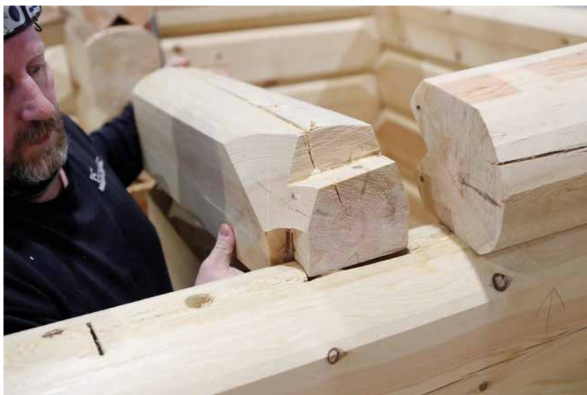
Asgeir Oddlien skjøter stokker i knuter med laftet Svalehale. Vanlige lafteknuter utføres i tapplaft.
