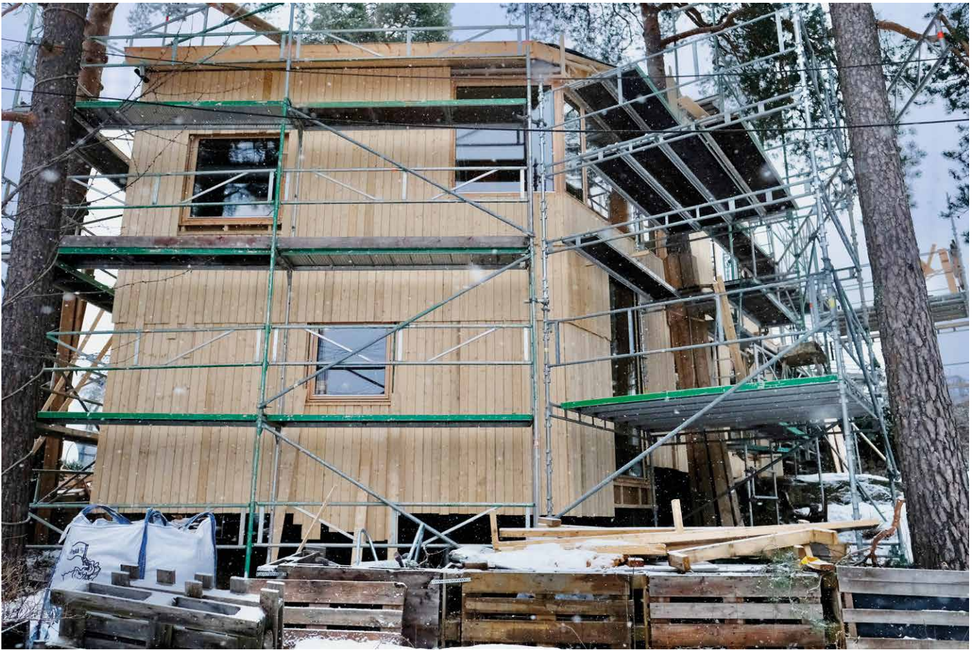
Den lille byggetomta på 550 m 2 skulle egentlig sprenges ut og planeres. I stedet står trehuset på påler i grunnfjellet mellom 12 bevarte trær.
