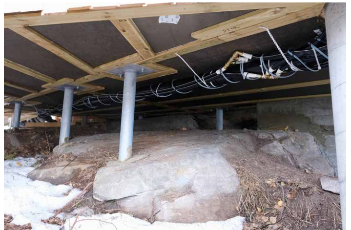
Den lille byggetomta på 550 m 2 skulle egentlig sprenges ut og planeres. I stedet står trehuset på påler i grunnfjellet mellom 12 bevarte trær.
