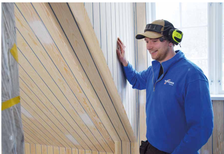
Tømrer Per Olav Olimstad har hatt jobben med å legge på den nye panelen.
