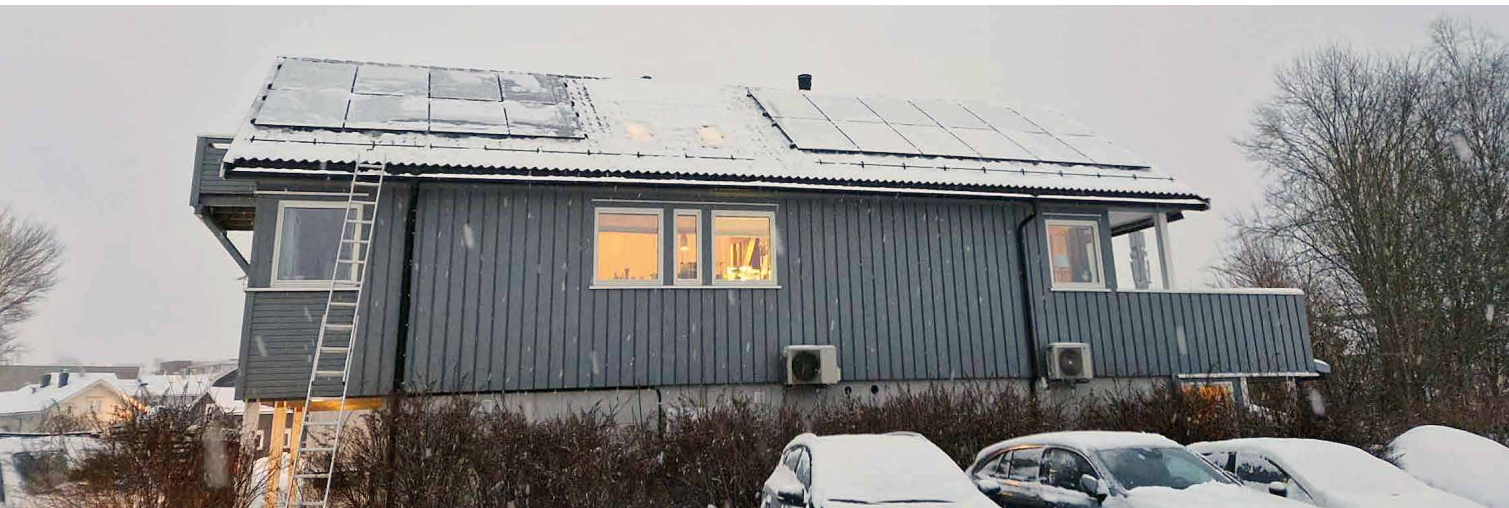
Panelene er ferdig montert på eneboligen i Skien. Mestertaket monterer fra fem paneler på et garasjetak opp til flere hundre paneler på næringsbygg. (Foto: Mestertaket)
