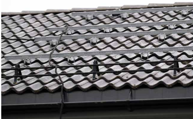
Skinnene til solcellepanelene er montert. Plasseringen er nøye prosjektert og tilpasset akkurat dette taket.
