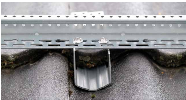
Festesystem til solcellepanel tilpasset dobbelkrummet takstein.
