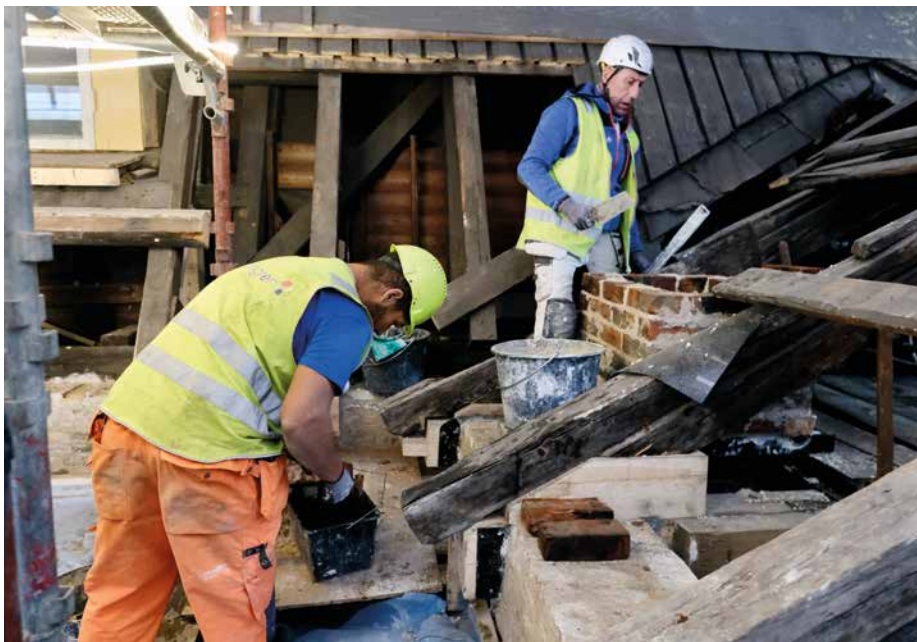
Murerne Jonathan Arntzen og Sylwester Orzechowski fra Wettergren Fasade AS som er Oslos eldste spesialist på fasaderehabilitering og gamle kalkteknikker.
