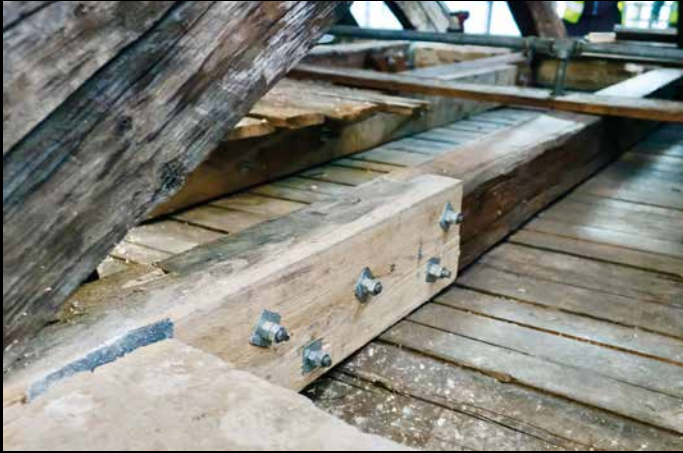
Sammenføyninger er gjort med innfelte hakeblad og strammet opp med bulldags og muttere på begge sider av gjengestaget
