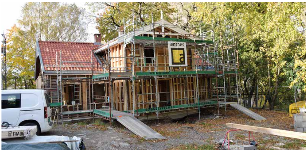
Det laftede huset gjennomgår en fullstendig rehabilitering og et tilbygg, En vanlig type oppdrag for Ansnes Entreprenør AS. Oslo kommune er oppdragsgiver.
