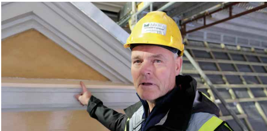
- Her ville Riksantikvaren at vi skulle sette inn tidstypiske beslag over vinduene av linoljetbehandlet trevirke, sier Dybvig.
