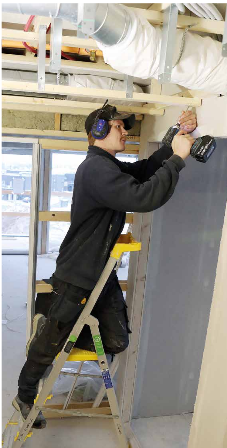
Tømrer Jørgen Brækkan Valby jobber med å senke ned himlingen, før det skal monteres to lag med gipsplater.
