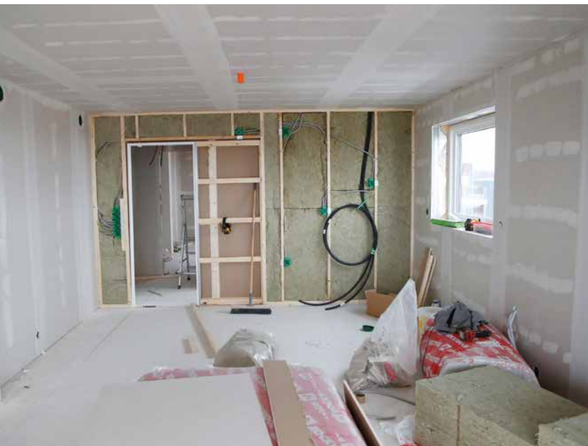
Det er lagt flere lag med gipsplater både i himlingen og på noen av veggene. Over gipsplatene på gulvet skal det legges parkettgulv.
