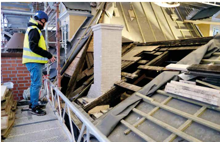
En stor del av vanninnsiget skyltes nedrenning langs pipeløp. Nå som pipa er flyttet og murt opp igjen unngår taket en rekke falser og loddeskjøter som er utsatt for vann over tid.
