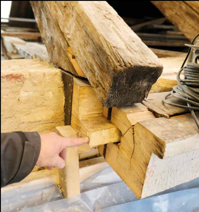
Sperrelund løftes opp ved montering av gesimsstokken i dimensjon 28cm x28 cm.
