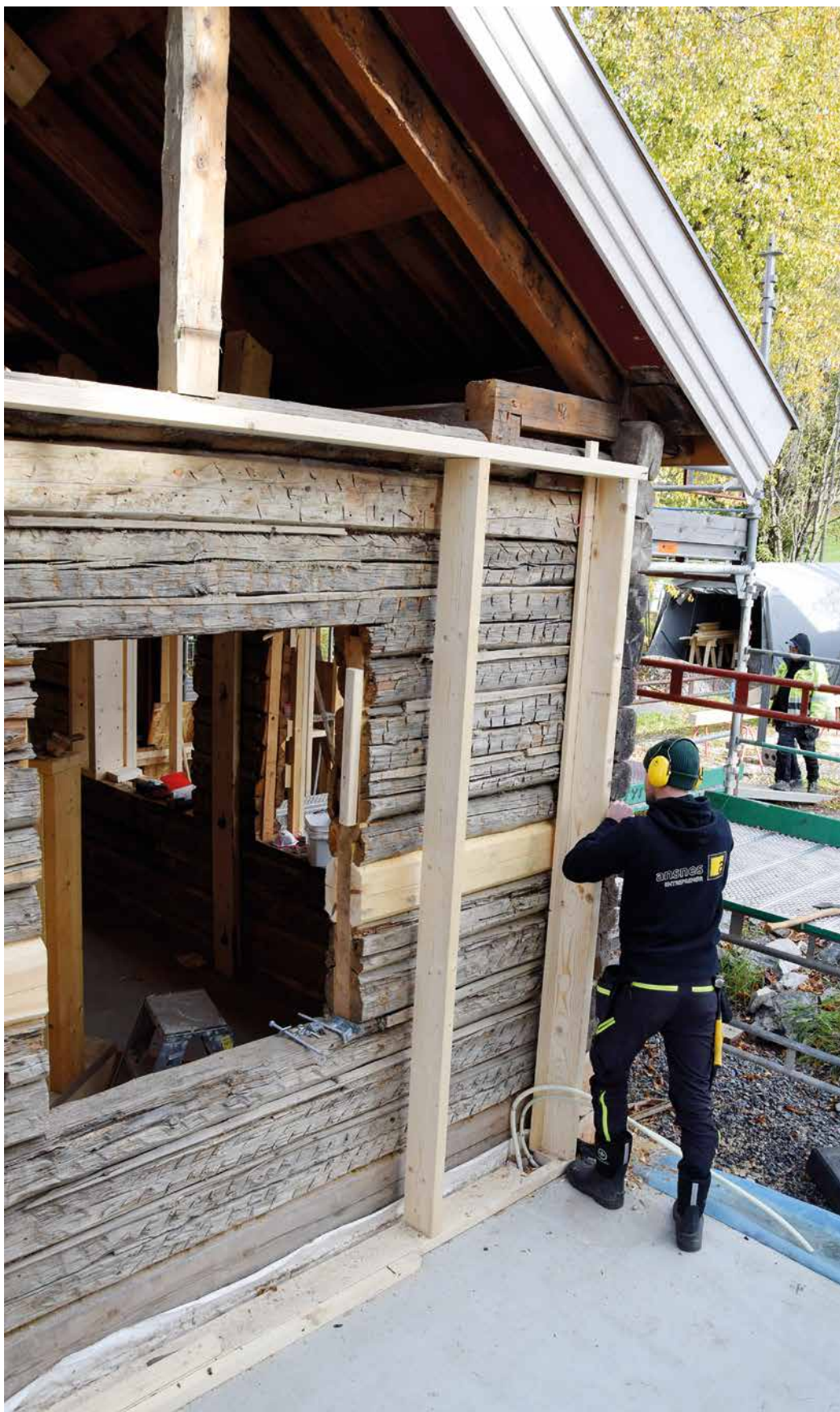
Fredrik Hummelvold Hillestad i gang med bindingsverket til påbygg med en vinterhage.
