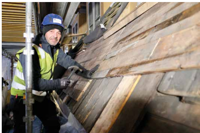
Tømrer Jacek Gondek lukker undertaket med så mye av det originale rupanelet som mulig.
