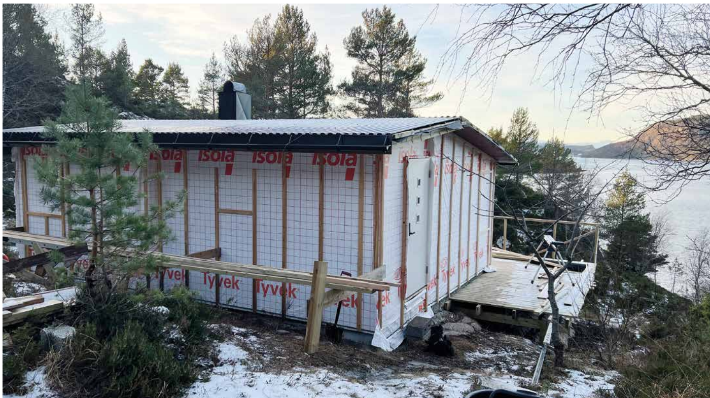
I løpet av høsten har hytta fått nytt tak og vindtetting, så nå kan vinteren bare komme. (Foto: Rikke Løvik)
