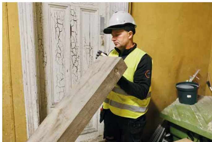
Tømrer Gitrus fra Byggmester Nerli sjekker stokker av malmfuru fra Tinnoset Sag i Øst-Telemark
