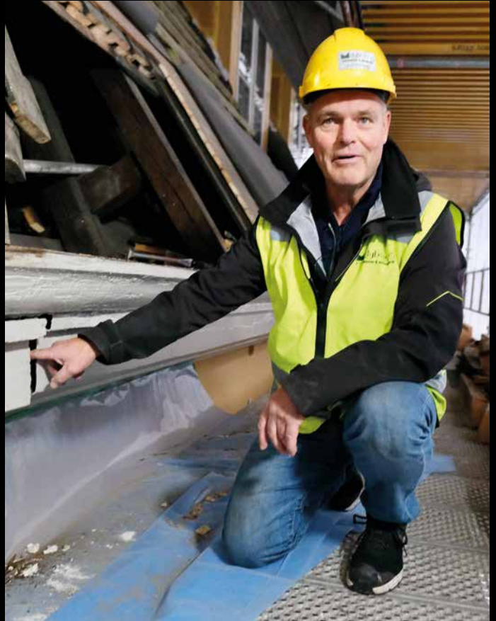
- Gesimsstokkene har avstand i skjøtene da sidefløyene ble bygget på hovedpalet ca 1680 og de har beveget seg i forskjellige retninger gjennom årenes løp, derfor har vi lagt inn mulighet for bevegelse/dilatasjon mellom byggene for fremtiden også, sier Morten Dybvig.
