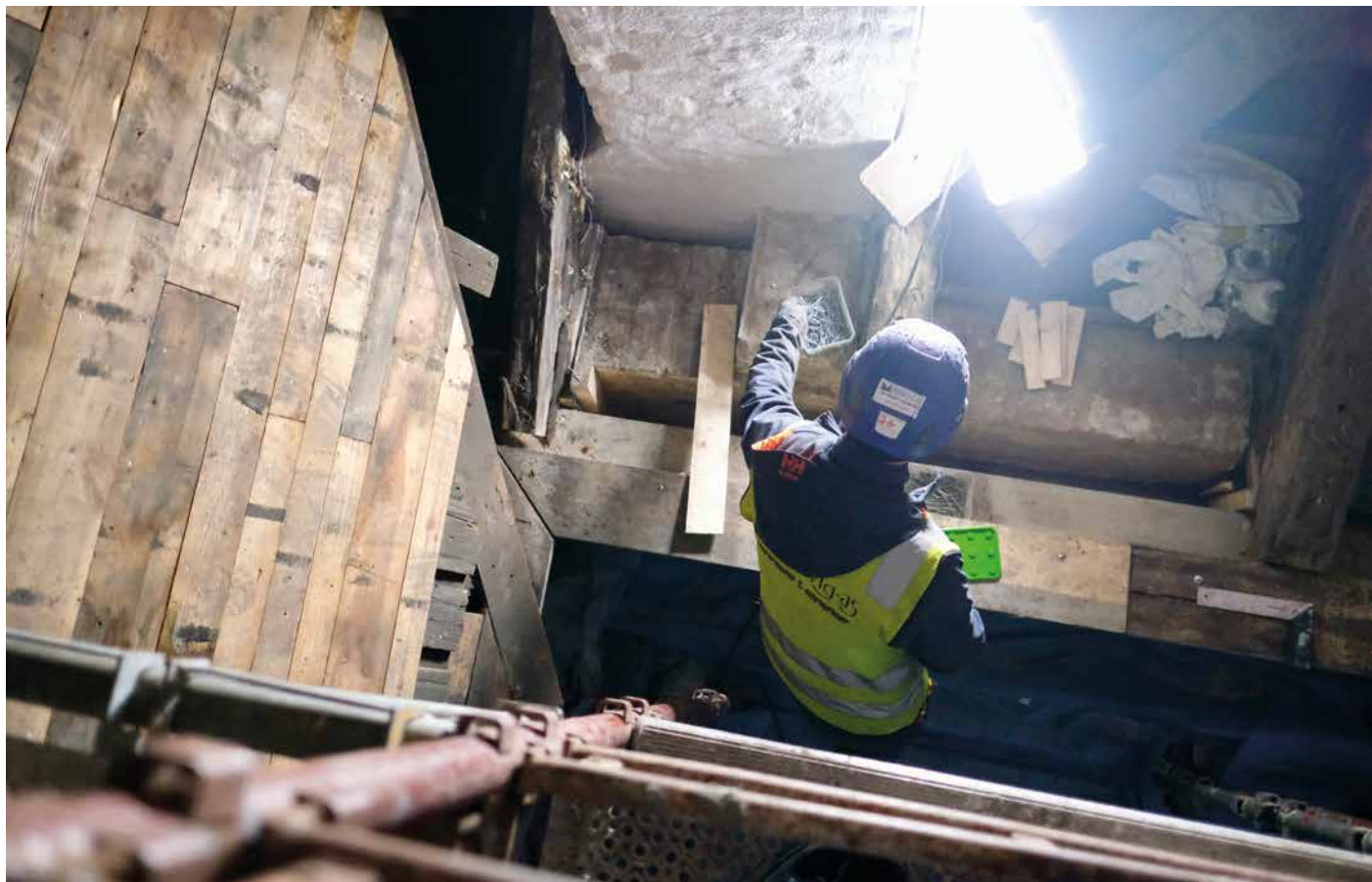
Håndspikring: Det er litt av et puslespill å spikre opp det originale rupanelet igjen.
