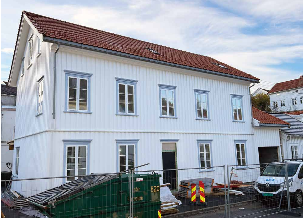
I november er det meste ferdig utvendig, og i januar blir det innflytting. (Foto: Ronni Lykke Jensen)
