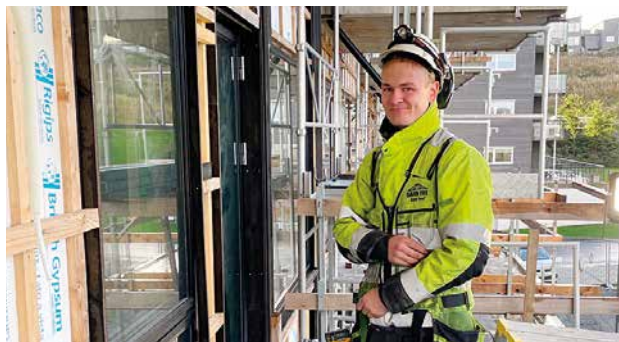
Nå er Erik Eikeland i gang med å legge kledning på et nytt leilighetsbygg. (foto: Marius Hegelstad)
