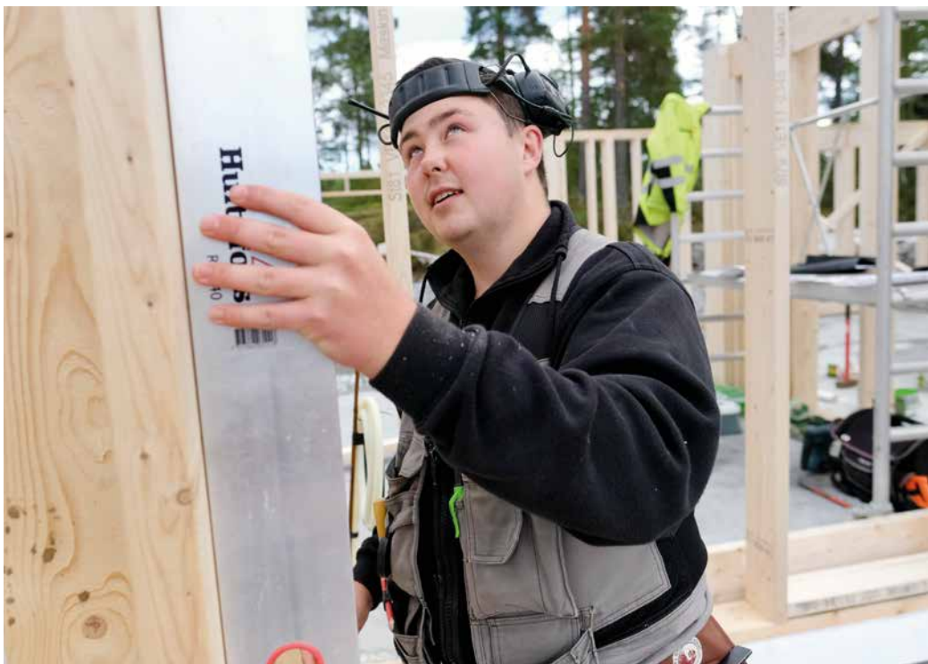
Ludvig Andreas Glosli er sikret hel skolering og bedre læretid med e-læringskurs.
