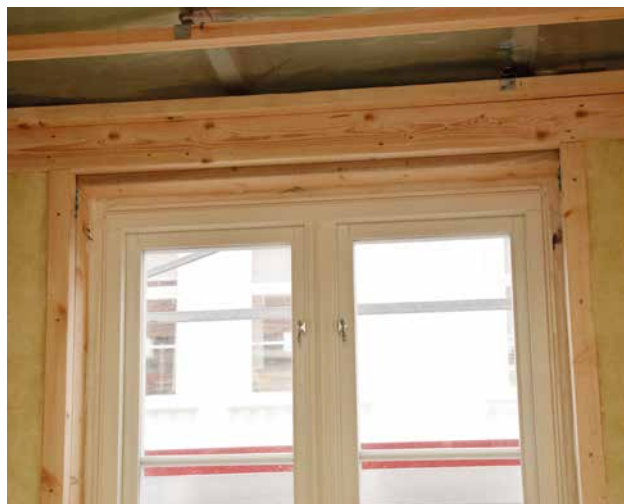
Løsninger inne må tilpasses utvendige mål. Derfor kommer nedføret lydhimling nesten i flukt med overkant vindu.
