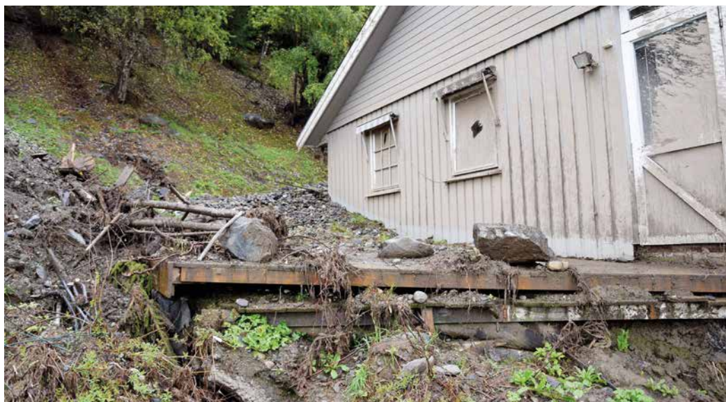
Om bygg gjentatte ganger blir herjet av flom og skred, bør gjenoppbygging på samme sted vurderes.
