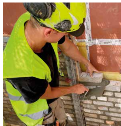
Ombruk av tegl på Eikeli videregående skole i Bærum, murt opp av Mjøndalen Mur og Puss. (Foto: Høine)
