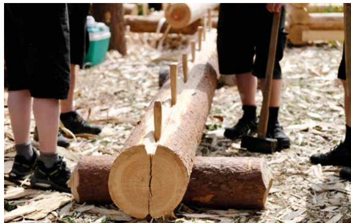
Kløyving av tømmer til gulvbord på Nordre Haverstad.
