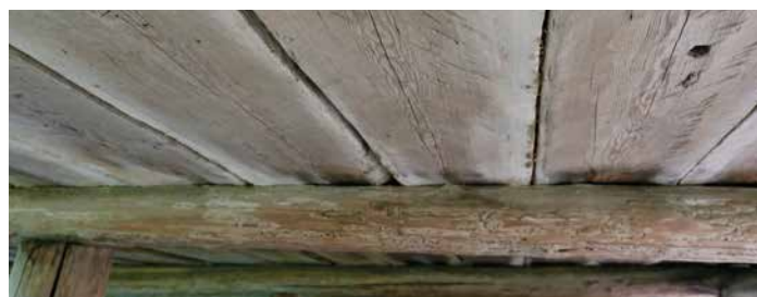
God tilstand under kornbingen: Undersiden av Haverstadloftet har klart seg godt gjennom 800 års bruk. Kornet måtte ligge tørt og trygt, så noen ganger satte man steiner mellom kornkisten og gulvet, sånn at ingen skulle bore opp med en navar og tappe ut korn.
