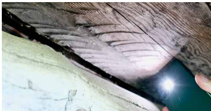
– Med slepelyset ser du sporene etter ulike verktøy opp gjennom århundrer. Dette handler om å lese og forstå livshistorien til bygningen sammen med andre håndverkere, sier professor Terje Planke.
