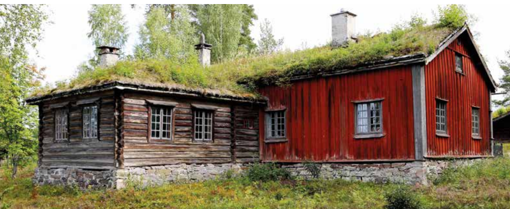
Slik sto Petershagen før tilbygget ble demontert. (Foto: Emir Curt, Anno Glomdalsmuseet)
