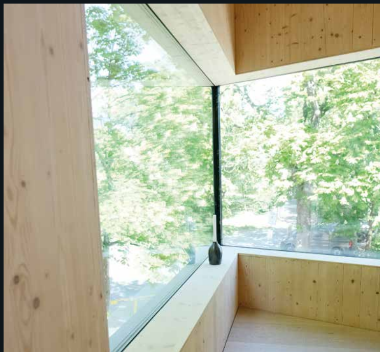
Mørkt utvendig – lyst og grønt innvendig: Vinduene med 4-lags isolerglass stilner all gatestøy som på et luksushotell.
