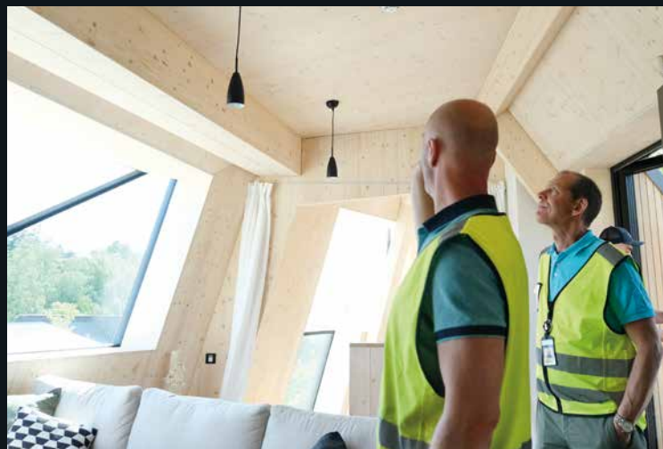
Hoveddragerne i taket ble endret for å få lengre spenn i taket på massivtre-skivene. Her er sprinkling og tekniske installasjoner frest ut i treverket
