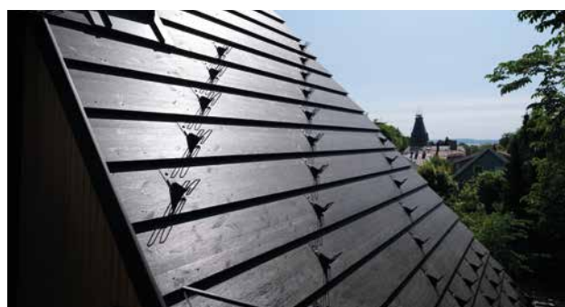
Taket var planlagt med båndtekkning og standard snefangere, men dette ble avslått av kommunen. De ønsket et rent trebygg, og valget ble massivtrepanel med snøfangere fra NOMO.
