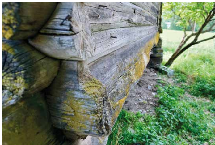
Loftet på Haverstad i Gudbrandsdalen er et av nokså få bevarte loft fra middelalderen i Gudbrandsdalen. Loftet er endret opp gjennom tidene, men har mye originale materialer som de fantastiske sylstokkene.
