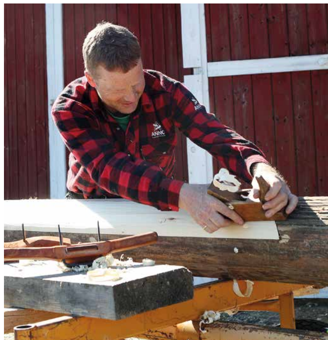
Antikvarisk håndverker Bjørn Steffen Sagmoen, som er innleid til museet i dette prosjektet, høvler utenfor laftehallen. Foran ham ligger pjålen som museet selv laget.
