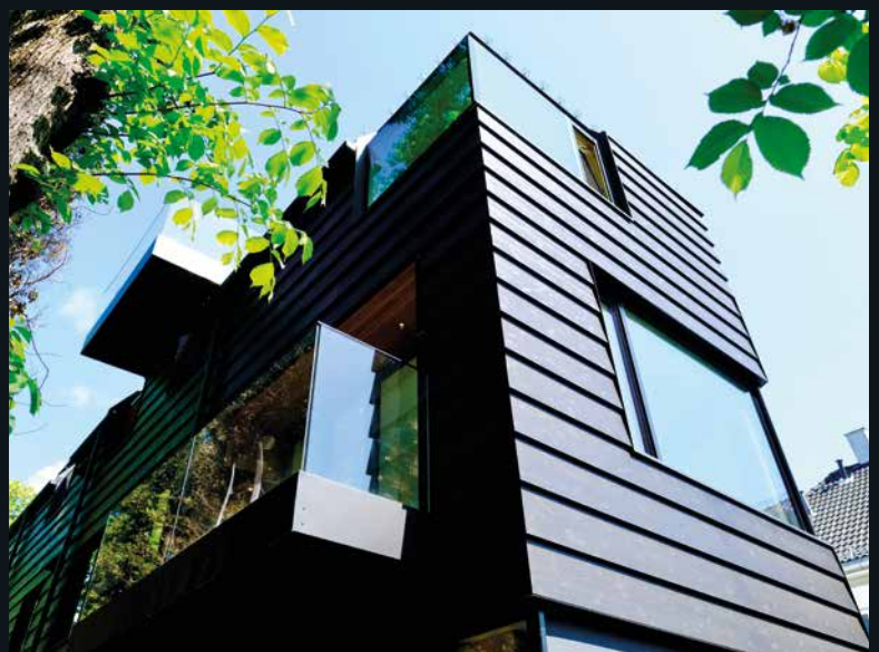
Bygget er kledd med liggende trepanel i målene 30 x 337 millimeter som er lagt på millimeteren. Her har tømmerne virkelig hatt en krevende jobb.
