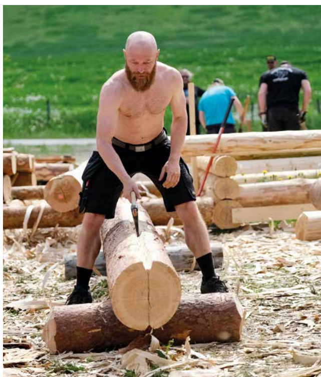
Ved å studere verktøybruken på loftet har flere smeder produsert kopier av økser og pjåler som nå brukes til å hogge og bearbeide kopier av bygningsdelene på loftet til Nordre Haverstad.
