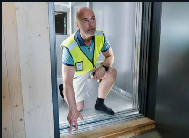
Heiskrav: Den nye heismodellen fra Otis går fra kjelleren til tredje etasje og drives av et belte på siden (vaierløs heis) slik at den ikke trenger eget heisrom. – Men vi måtte søke flere ganger før Heiskomiteen i Plan- og bygningsetaten godkjente denne modellen, forteller Vidar Strømdahl.
