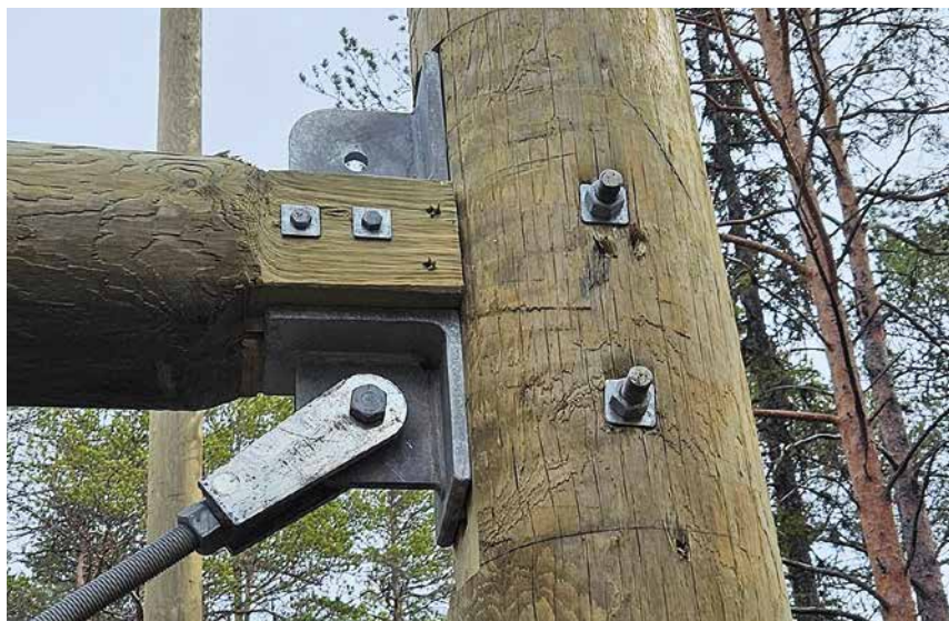
Oppå hvert stolpepunkt er det montert en stålbrakett som er designet for bruk i dette området. Braketten holder både søyle og strekkstag som kobles diagonalt til søylemakkeren. Oppe er det en ny brakett som tar imot strekkstaget og holder en tverrbjelke på plass.
