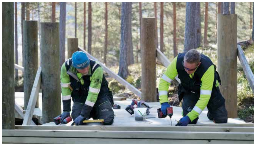
– Det har ikke vært mye plankekjøring! På noen få partier er det enkelt, men ellers blir det å bygge opp stillaser mellom hvert stolpepar og det er tidkrevende. Og alle avstander og lengder skal være så nøyaktig som mulig, sier tømrerne Stian Aasbakk og Stian Hansen.
