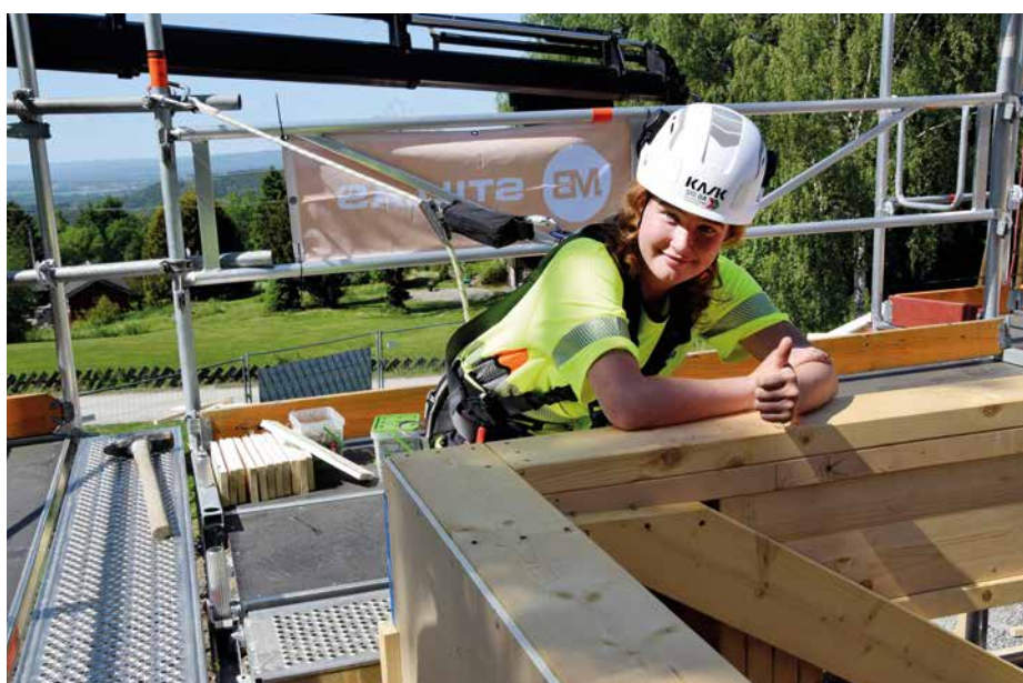
Sikring i takstolmontering handler om å forhindre fall innover i bygget, demonstrerer Klara Bjørn-Hansen som til vanlig er lærling i Tømrmestrene Øye og Knutsen AS i Oslo. ➔
