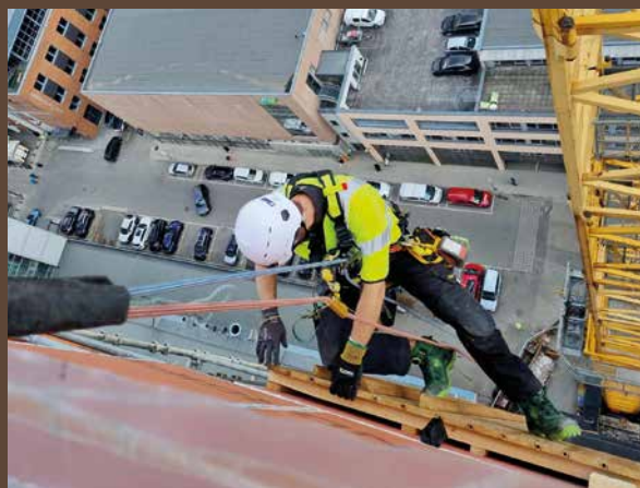
Tilkomsteknikerne bruker to tau, et arbeidstau og et til backup. (Foto: Kai Roger Berget, RVT)
