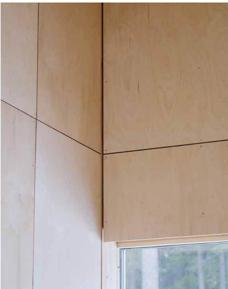
Finerplatene er ferdig montert i soverommene.
