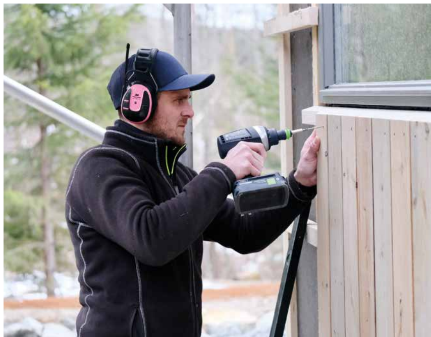
Tømmerbas Lars Petter Lund skrur kledningen som er behandlet med jernvitriol.
