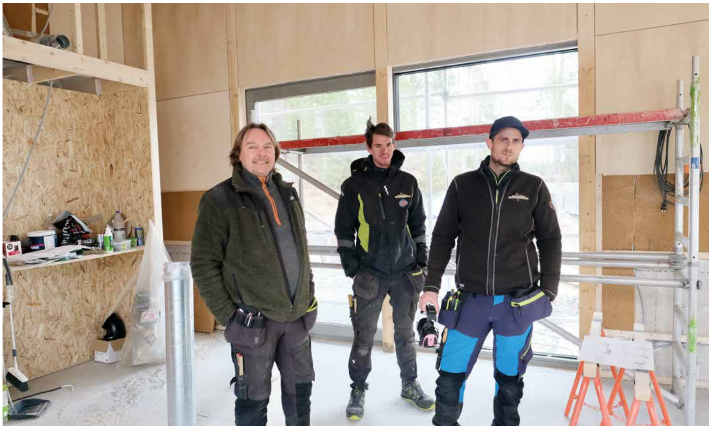
– Hele bærekonstruksjonen er i limtre og da blir det alltid presisjonsarbeid, sier Rino Delås, Lars Petter Lund og Marius Svendsen i stuedelen.
