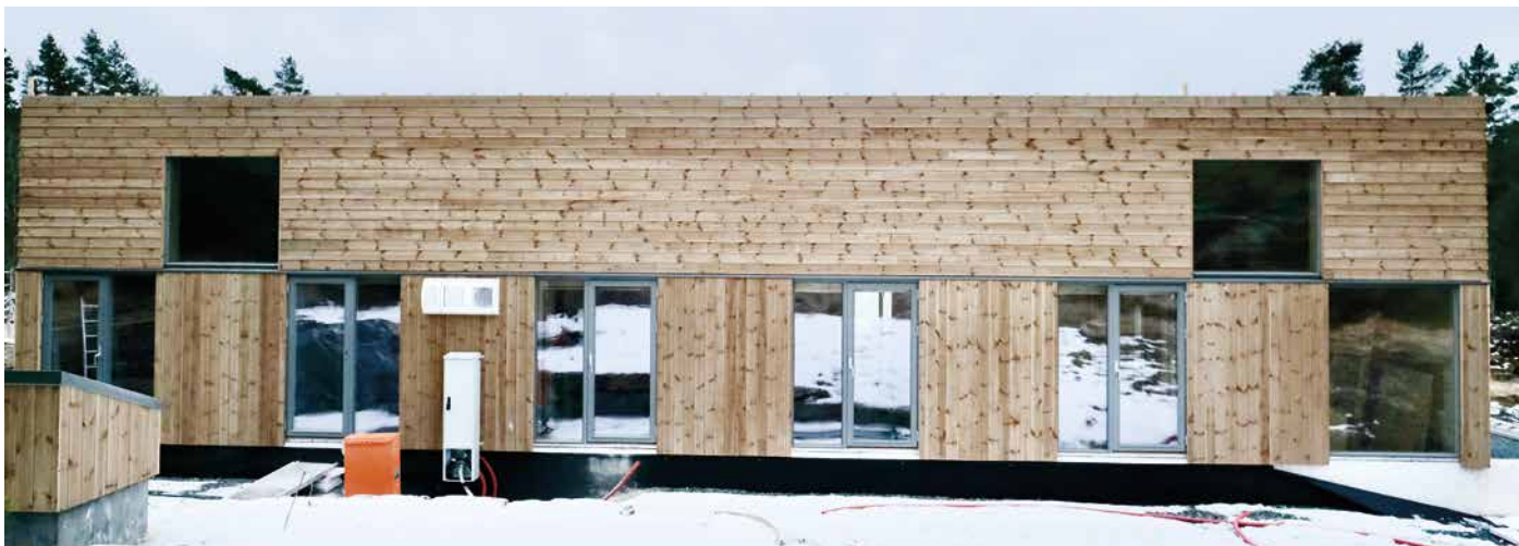
– En spesiell detalj er at vi også monterte musebånd under beltet (mønet). Beltet går helt innpå ASA-plata, slik at vi slipper å ha lister oppunder vinduene – her vil de ha rene linjer og lite staffasje, sier Delås.
