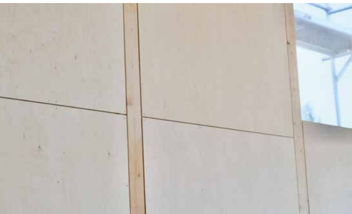
Finerplatene er ferdig montert innvendig i hele huset.
