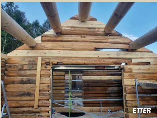
Den forfalne vegg før demontering og etter gjenoppbygging.
