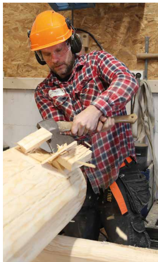
I egen laftehall hogger Vegard Mikkelsen til en av takåsene til ei hytte.
