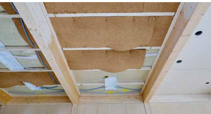
I bindingsverket mellom limtresøylene isoleres huset med trefiberplater.
