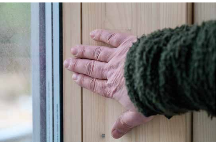
– Inne er det også mye å ta hensyn til, blant annet har ikke vinduskarmene foringer.
