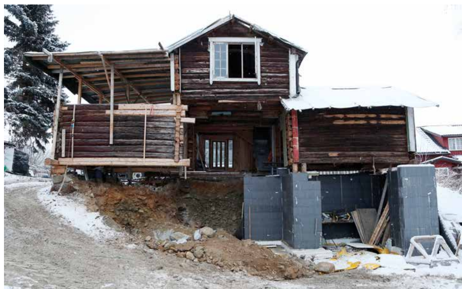
Gildestova får moderne kjeller. Første og andre etasje skal gjenskapes, som den var opprinnelig, med materialer som Utstumo og Svarstad Wiig har hogd i egne skoger.
