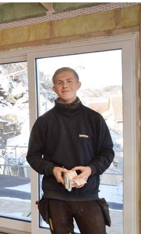
Leveranser og rigging blir krevende når tomte er så trang som til denne store eneboligen på Flekkerøya.
