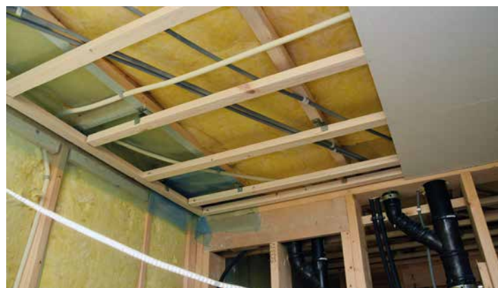
Utførelsen er avgjørende for å oppfylle lydkravene. I underkant legges ett lag fibergips før laget med vanlig gips.
