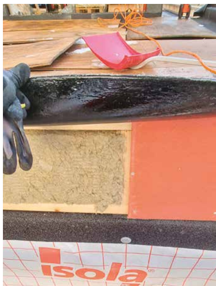
Parapeten er etablert med takpapp som dampsperra som er brettet ned og sveiset til vindsperra, isolasjon og taktekingen (som her er brettet opp for å dokumentere løsningen). (Foto: Morten Homme)
