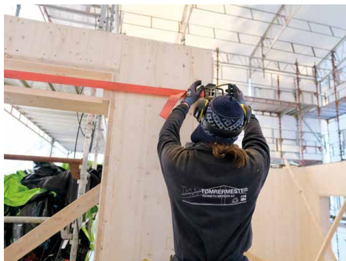
Elementveggen samles med spennbånd og jekkestrapper før tømmerne skrur fast elementene i styringsskinnene og toppsvillene.
