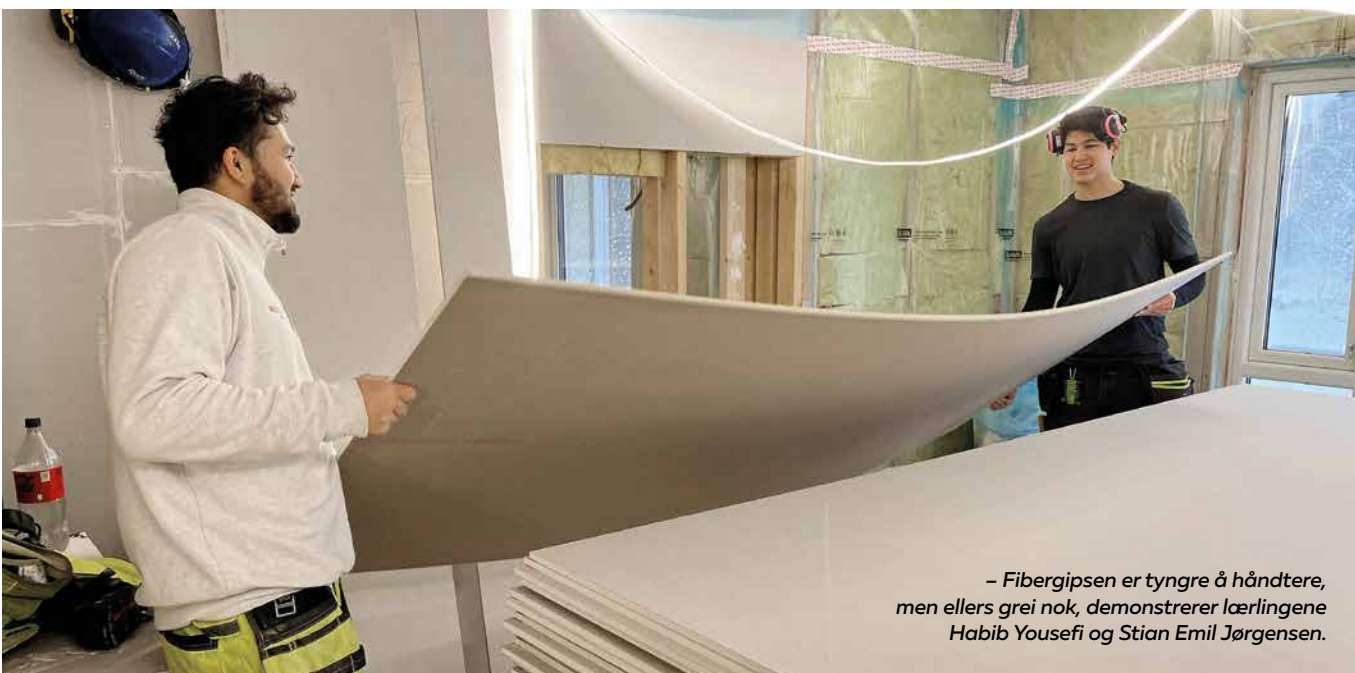
Utførelsen er avgjørende for å oppfylle lydkravene. I underkant legges ett lag fibergips før laget med vanlig gips.
