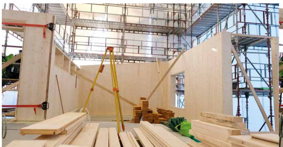
– Elementbygging er en rasjonell byggemåte som vi gjerne gjentar, sier tømrmester Kenneth Werner.
