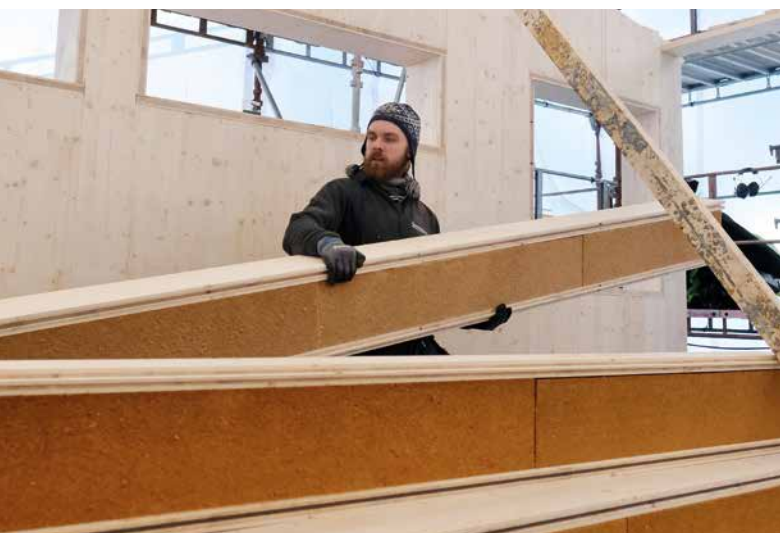
Voksenlærling Sigurd Telle viser at kantelementene fra TEWO lett bæres inn i byggeteltet.
