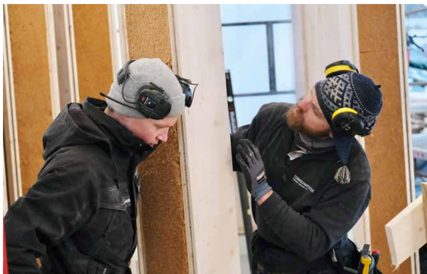
Tørrer Henrik Valby og voksenlærling Sigurd Telle monterer veggelementer under telt.
