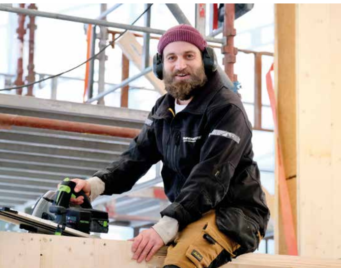
Tømrer Eirik Iversen får effektive arbeidstimer inne i byggeteltet.
