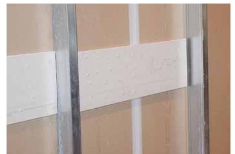
Gipskapp brukes som remse til å feste platene som skjøtes.
