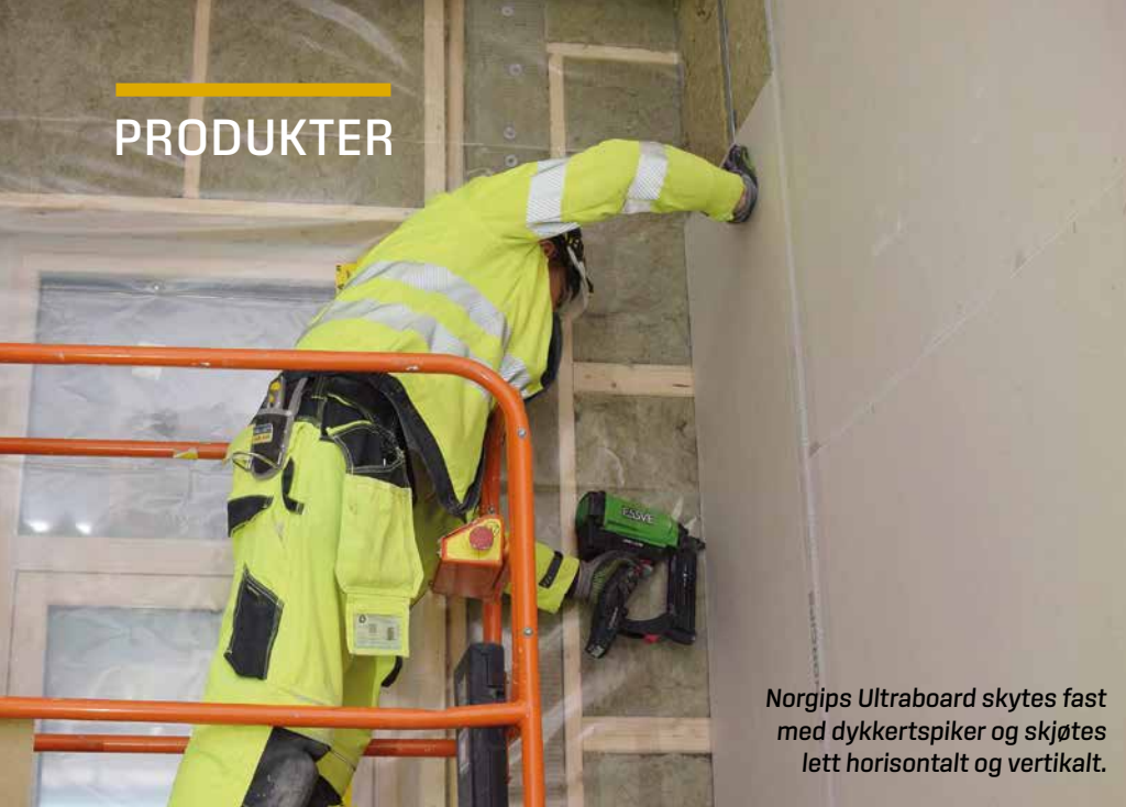
Dykkertspiker gir mindre hull og dermed mindre behov for sparkling. I den vertikale skjøten er det lagt en «bondfiller» som også reduserer behovet for sparkel.
