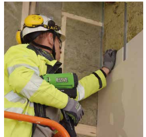
Ei gipsremse festes bak plateskjøten.
