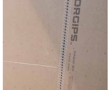
Dykkertspiker gir mindre hull og dermed mindre behov for sparkling. I den vertikale skjøten er det lagt en «bondfiller» som også reduserer behovet for sparkel.
