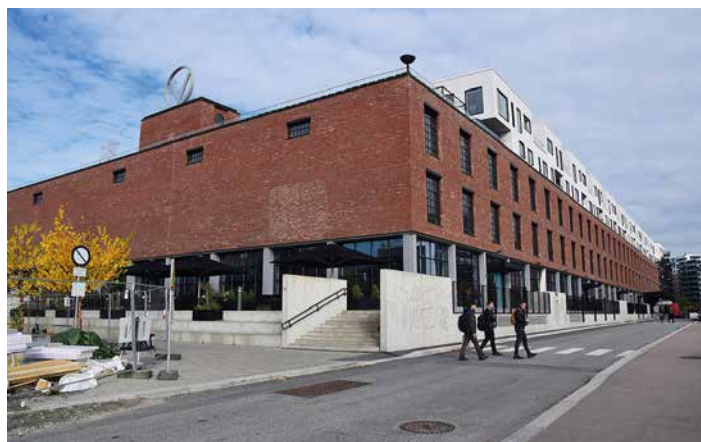
Teglsteinsvegger og store vinduer med ruter trekker linjer til Vinmonopolets tapperi slik det ble bygd en gang på 1930-tallet. I andre etasje og to og tre etasjer oppå bygget er det bygd til sammen 220 leiligheter.
