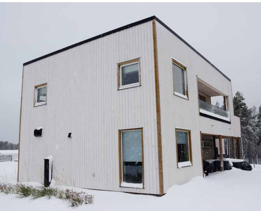
På utsatte steder som hjørner og vindusomramminger står trykkimpregnert best mot fukt og råte.
