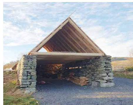
Idet taksperrene er satt opp og undertaket lagt, er naustet nesten ferdig.
