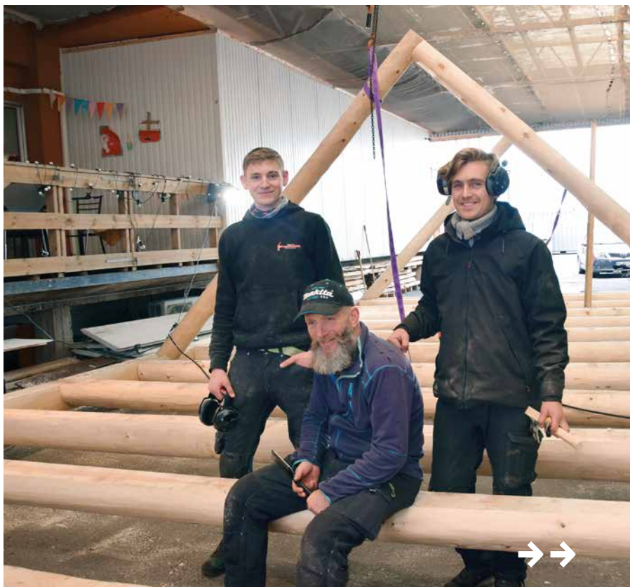
– Vi har kommet overraskende langt på mindre enn to uker, fastslår Magnus Sønsterud [t.h.] som er bas på dette bygget med lærling Øystein Pedersen og tømmer Bjørn Kåre Espevik på laget.
