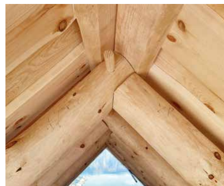
Bjelker (undergurter) og taksperrene er nøyaktig felt inn i stavlæggene (toppsvillene).
