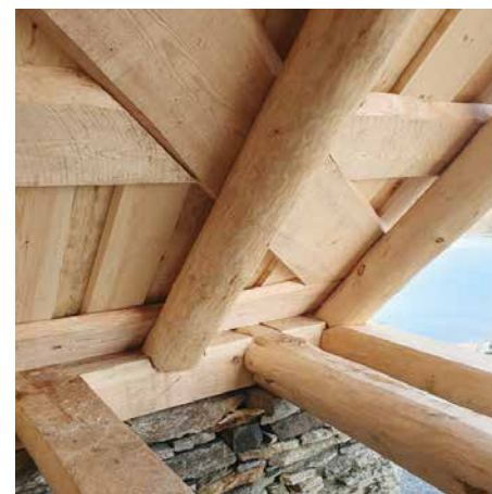
Bjelker (undergurter) og taksperrene er nøyaktig felt inn i stavlæggene (toppsvillene).
