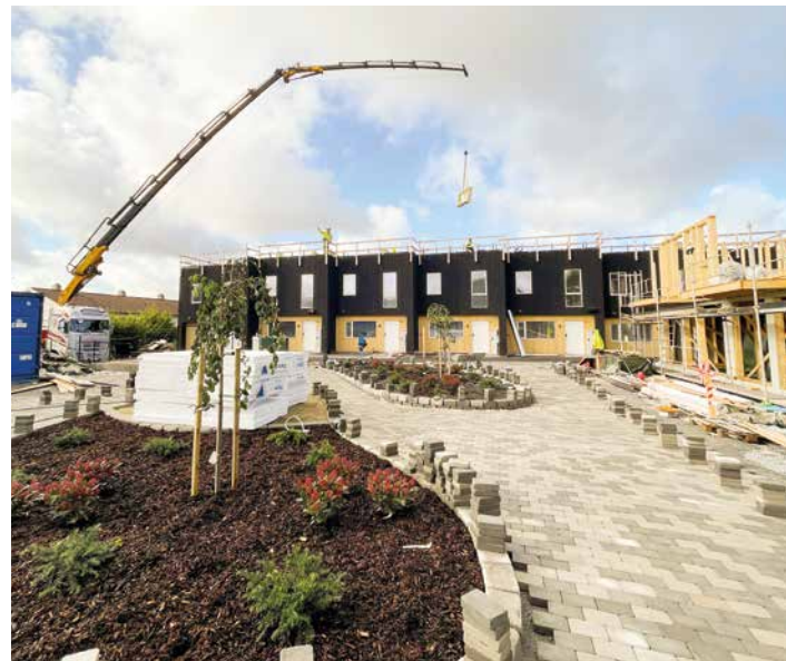
Materialer måtte løftes inn med stor kranbil fordi uteområdet boligene bygges rundt ligger oppå en parkeringskjeller.
