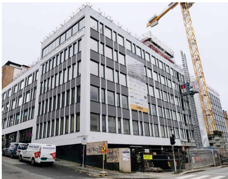
Universitet i Bergen ombruker mest mulig av byggematerialene for å redusere avfall og utslipp når Nygårdsgaten 5 ombygges.
