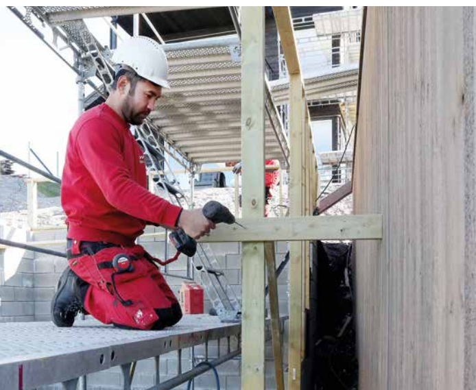
Aref Nazari er i gang med bindingsverket til et nytt naust.
