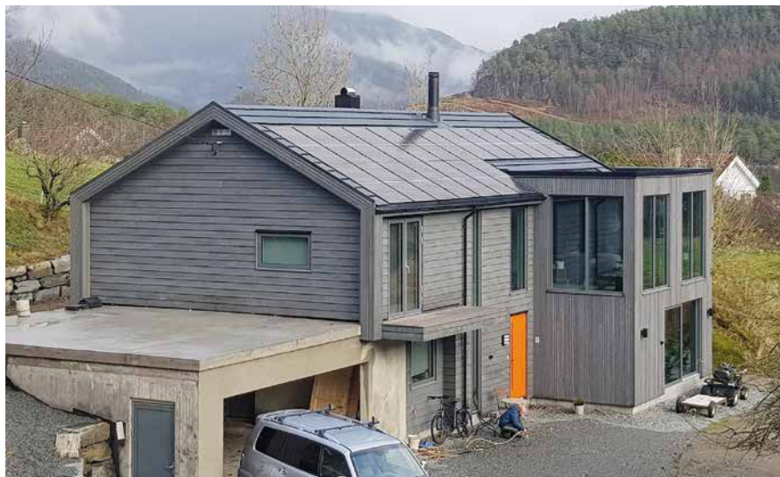
Pilotprosjekt med integrerte solcellepaneler på et hus av Norgeshus KV Bygg Suldal. (Foto: Greenstat)
