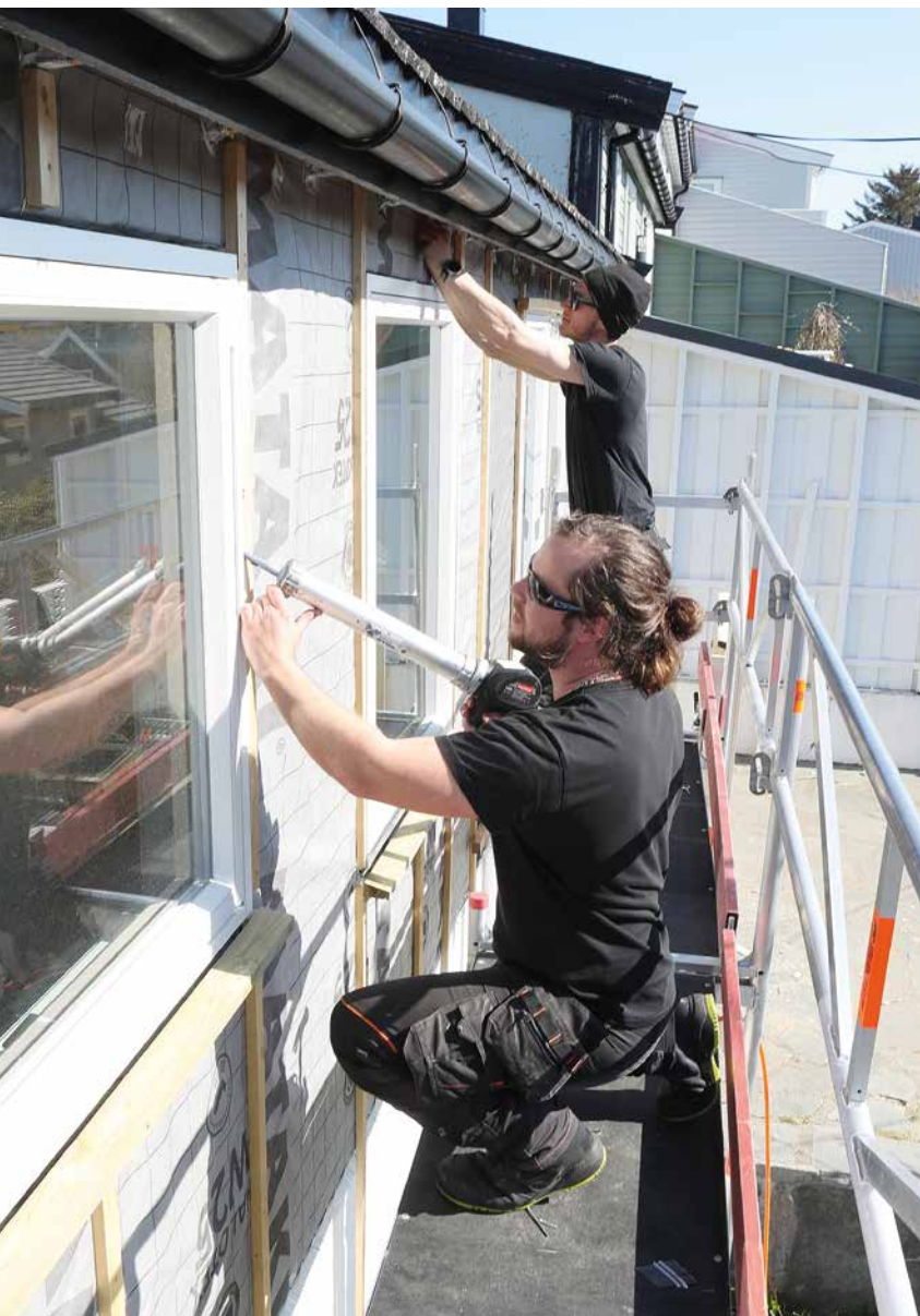
Lærling Odd Bjørnar Sørøy Træthaug fuger vindu, mens byggmester Sjur Bruseth jobber med tetting av veggen.
