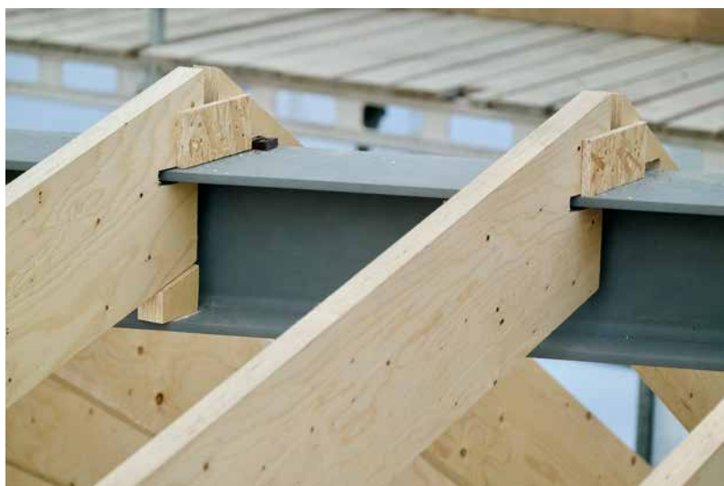
– Understeget på noen av ståldragene er kilet opp med klosser, for å ta kreftene i tverrsnittet på toppene.
