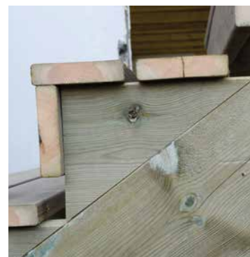
Vangeklossene er skjært til av 48 x 198 mm med 55 graders vinkel.
