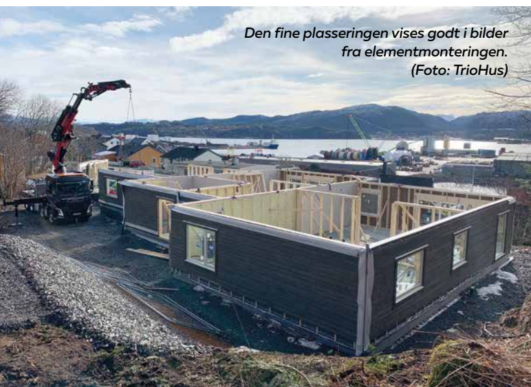
Slik er åttemannsboligen sett fra oversiden.
