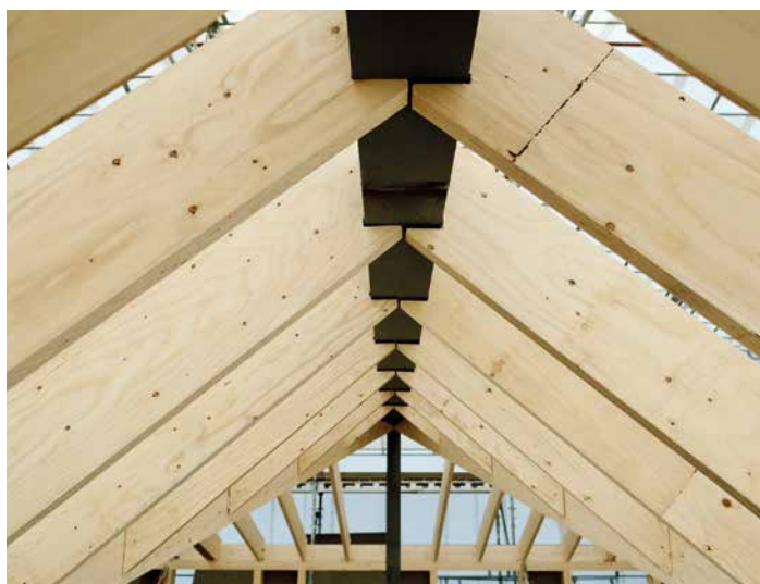
Hver Kertobjelke er skåret til og tilpasset på stedet.
