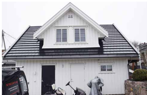
Også på annekset/garasjen er det lagt solcelletakstein på den sørvendte delen av taket.
