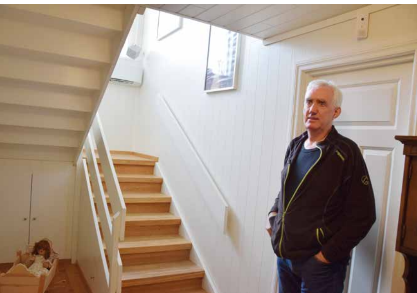
NØYAKTIG RESULTAT: Løvteit står i gangen der veggene er panelt om, dørene og omrammingen er skiftet og ny parkett er lagt på gulvet og i trappa.
