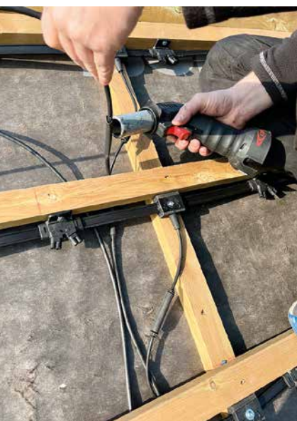
Elektrikeren sørger for å legge ledninger til kobling av taksteinen.
