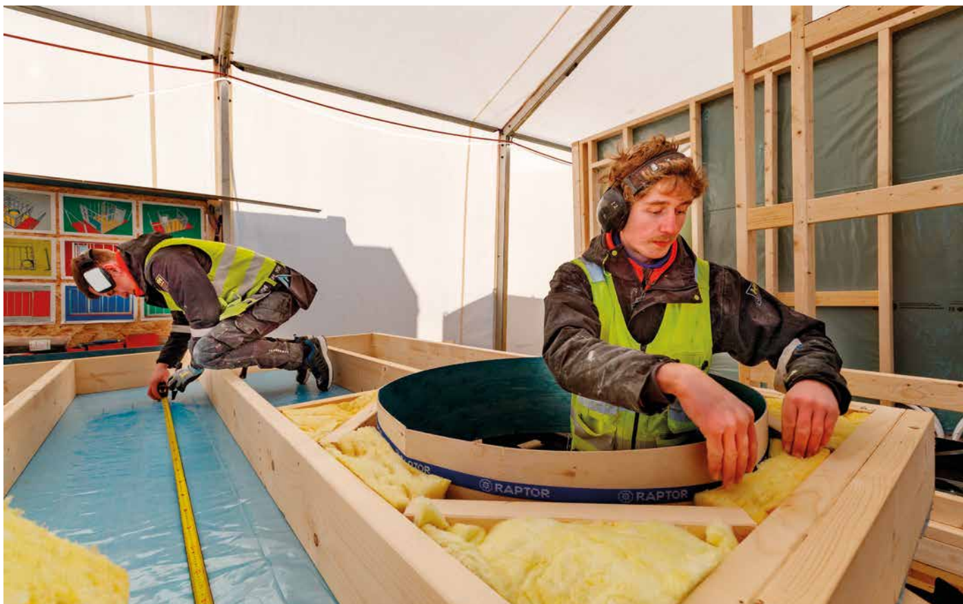
TELT LIV: I et stort telt er det laget en produksjonslinje som sørger for effektiv bygging av 120 minihytter til Juliusskogen i Dyreparken. Her er tømrerne Lars Magne Eiklid (foran) og Kristian Bjerland er godt i gang med isoleringen inne i produksjonsteltet.
