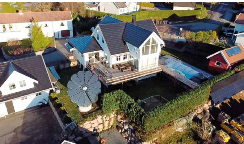
Eneboligen, annekset/garasje og uthus er belagt med solcelletakstein eller solfangere. (Alle bilder på denne siden: Bjarne Tveit)
