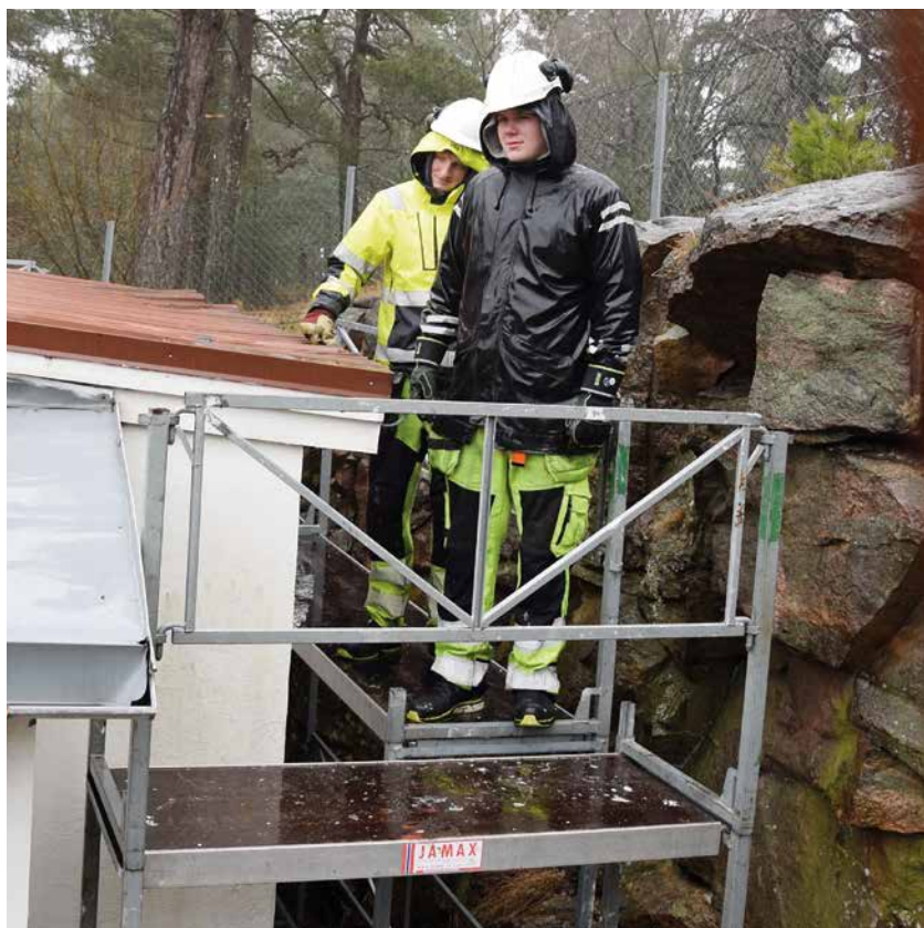
Petter Sørby Nygaard og Jens Mathias Lian bygger stillas ved tilbygget før taket skal rives.
