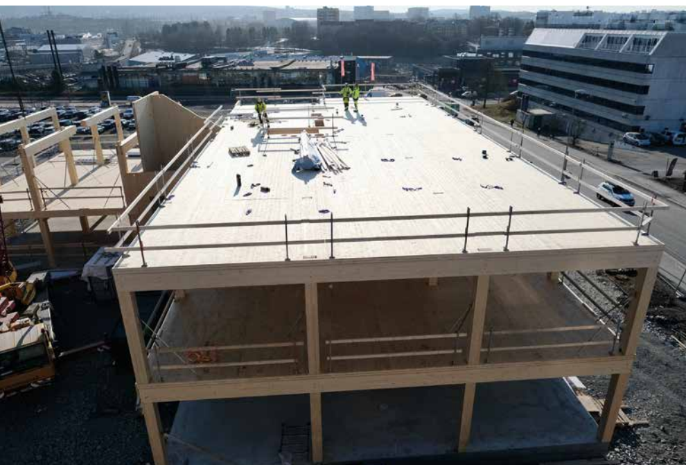
– Vi bruker toveis spenn i dekket. Slik kan vi spenne i begge retninger og muliggjøre et åpent rom for tekniske føringer i midten av bygget, sier Jørgen Tycho i Oslostre.
