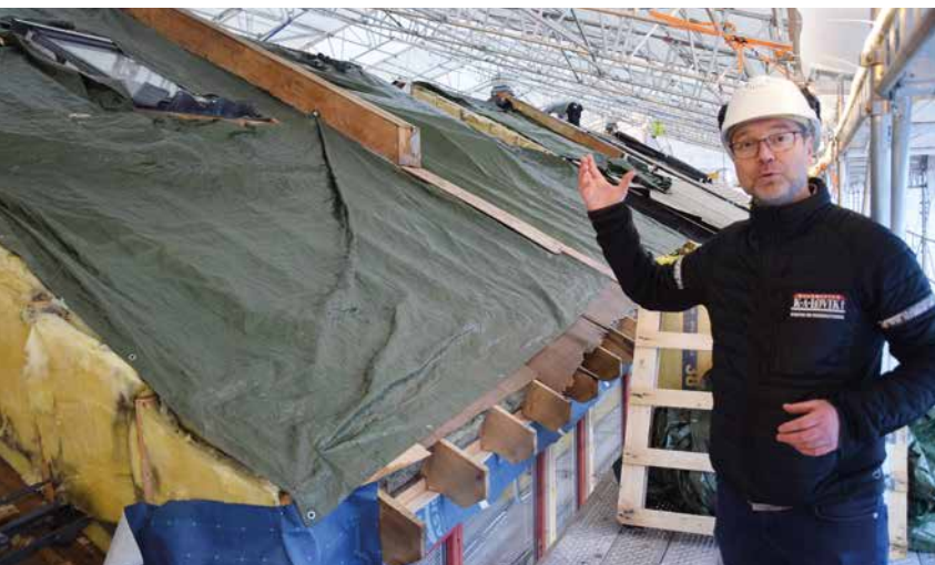
Selv med tak over tak, må isolasjonen dekkes til. – Det danner seg kondens på det kalde presenningtaket blant annet på grunn av varme fra avtrekksviftene, forklarer prosjektleder Cato Hagen.
