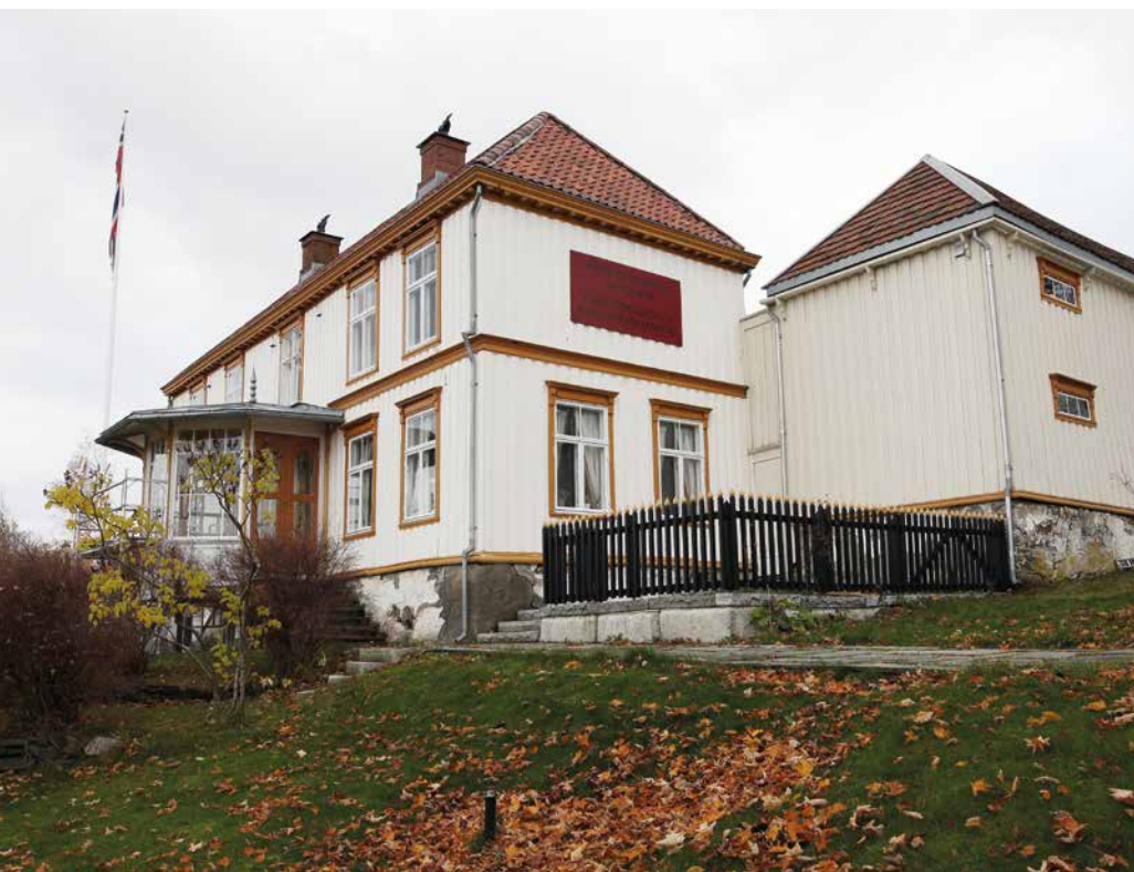
Saxenborgs hovedbygning til venstre og vognskjulet til høyre, med tak og fasader som er reparert, restaurert og malt på nytt.
