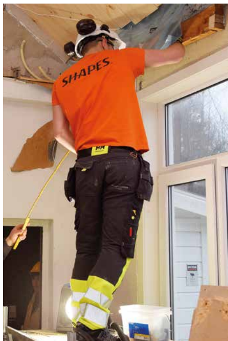
Siste rest av den gamle veggen plukkes ned.
