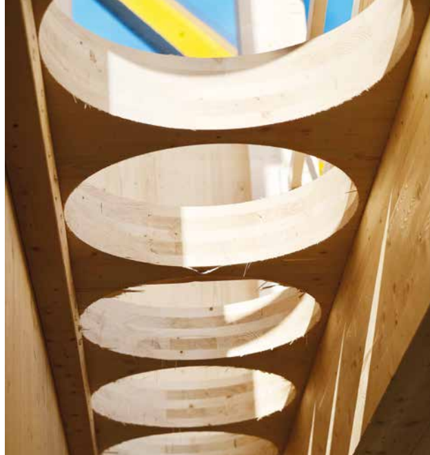
Gjennomføringene for tekniske anlegg er klare og venter på fagene.
