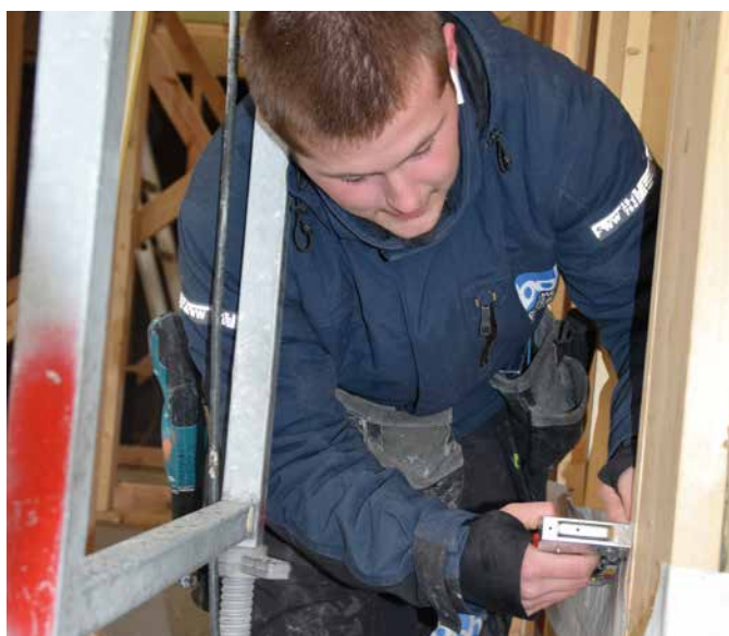
Tømrer Joakim Andersen Hauge fester vindspærreduken.
