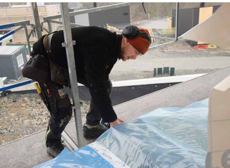
Lærling Henrik Heffermehl sørger for å feste dekkeplasten før regnet setter inn.
