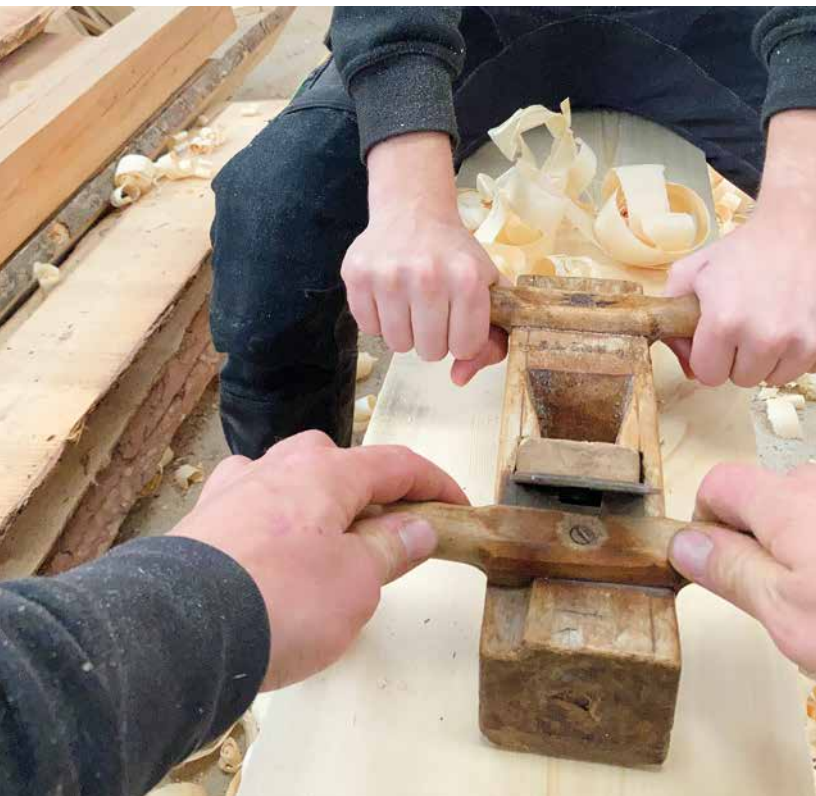
Tømrerne måtte bruke okshovel til overflatene på kledningsbordene. (Foto: HSW Bygg)
