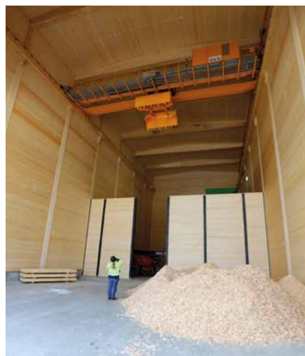
En traverskran på 11 tonn holdes oppe av treskruer på Eidsiva bioenergi avdeling Kongsvinger. Kranen er gjort fast med 12 stk. 13x700 mm helgjenge treskruer i hver søyle fordelt på kranbjelke og underliggende konsoll. Disse er forboret med 8 mm og skrudd inn med en kraftig batterimaskin.
