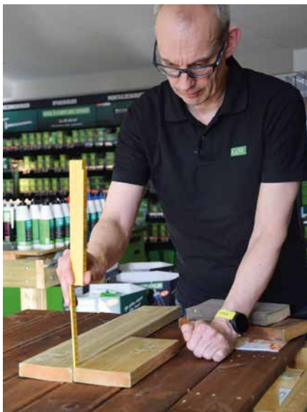
En arm av tommestokken gir 2,5 – 3 mm avstand mellom terrasseborda.
