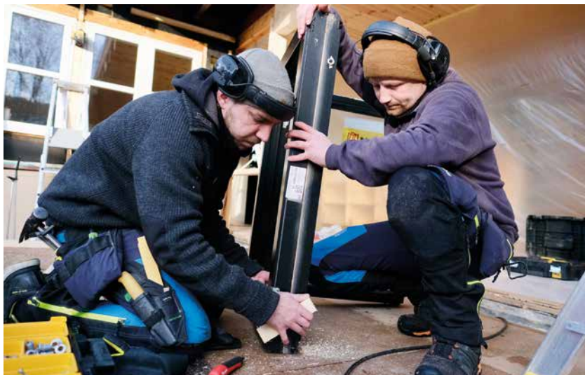
Fredrik Mæhlum og Stian Slettebakken gjør vinduet klart for montering.
