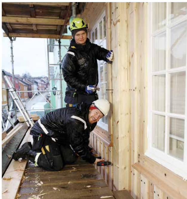
HSWs tømrere Knut Simensen og Magnus Presthagen i arbeid på fasaden til Bergmannsgata 19.
