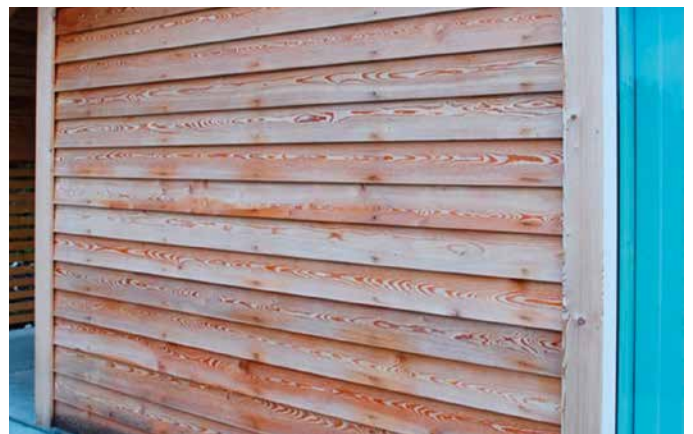
Etter vask av hver eneste skrue, ser veggens sånn ut. Det ble akseptert av hytteeieren. (Alle foto: Bjarne Nordvik)
