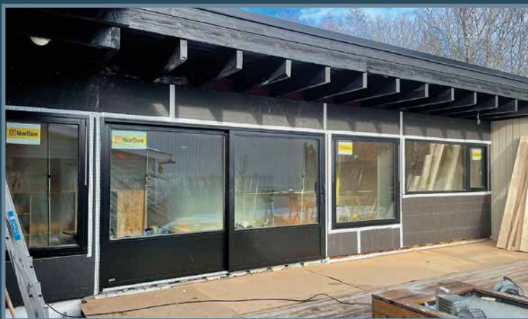
Ny skyvedør og vinduer er ferdig justert i atriumhuset på Ammerud. (Foto: Bygg 3 AS)
