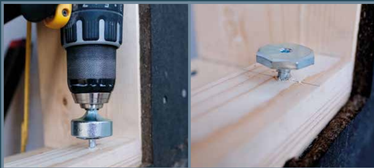
Vaterskruen kan justeres fra 5 til 35 mm i høyden.
