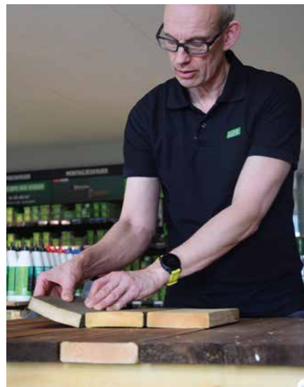
Om tørr trelast er lagt for tett, vil fuktighet få den til å svelle så borda presses mot hverandre og opp slik at skruer kan knekke.
