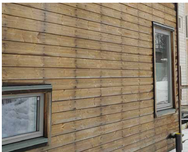
2014: Huset var knapt ett år gammelt da den galvaniserte spikeren ble så godt synlig.
