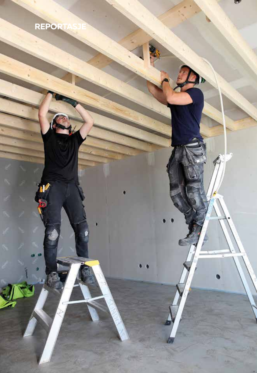
Tømrer Tim Ove Sundli og Martin Holtan Jenssen (t.v.) monterer bjelkelag.
