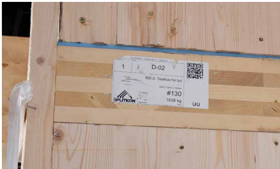
Skillet mellom enhetene består av fem lag og er 16 cm tjukt. Her testes effekten av en polyuretanmatte.
