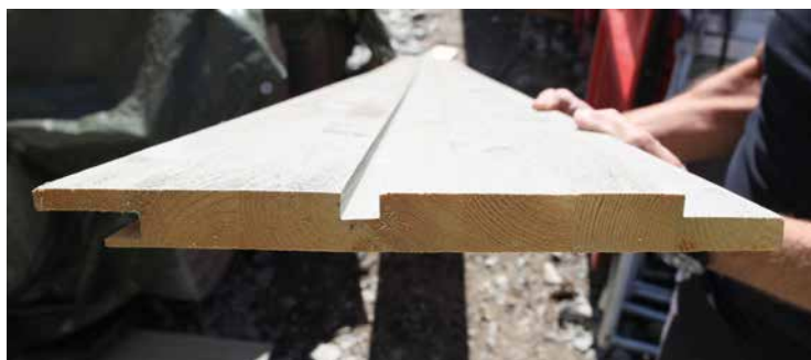
Her er et bredt limtrebord med spor. Alle yttervegger kles med slike.
