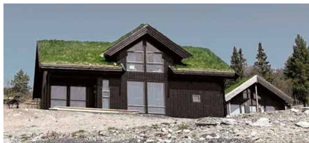
Dette er den ene av to visningshytter firmaet har bygd på Fjellsteggen i Vinje kommune (Foto: Saltdalshytta BVT)
