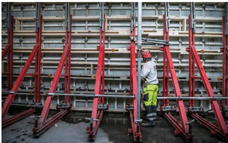
Det var ensidig støp så forskalingen måtte støttes med kraftige bukker.
