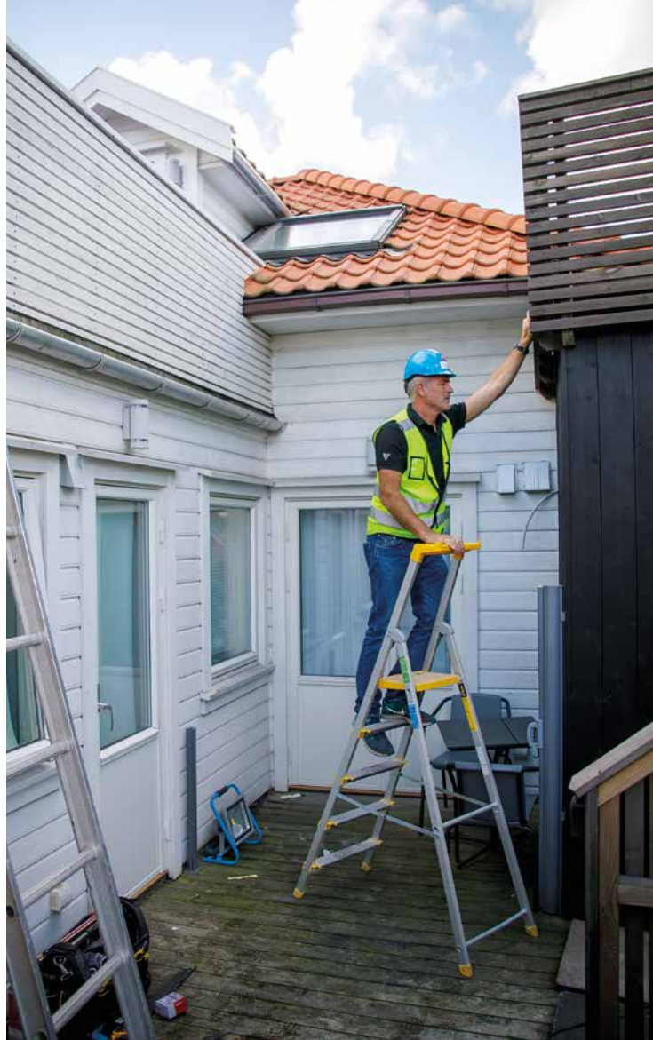
– Vi må ta hensyn til naboen med inngangsdør bak meg, sier Roy Henriksen mens han inspiserer kledningen til et av de nye infillhusene.
