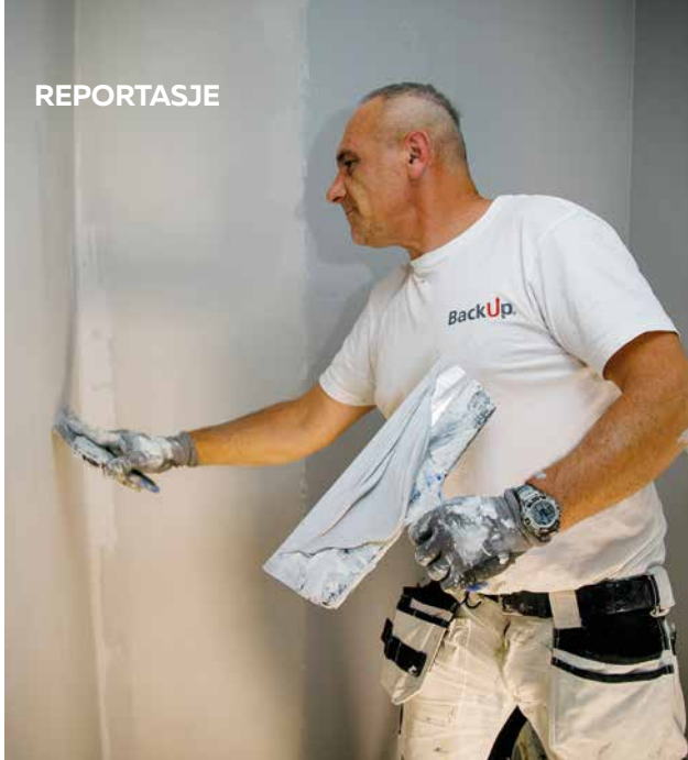
Andrzej Franaszczak sparkler nytt bad i et av de nye infillhusene.
