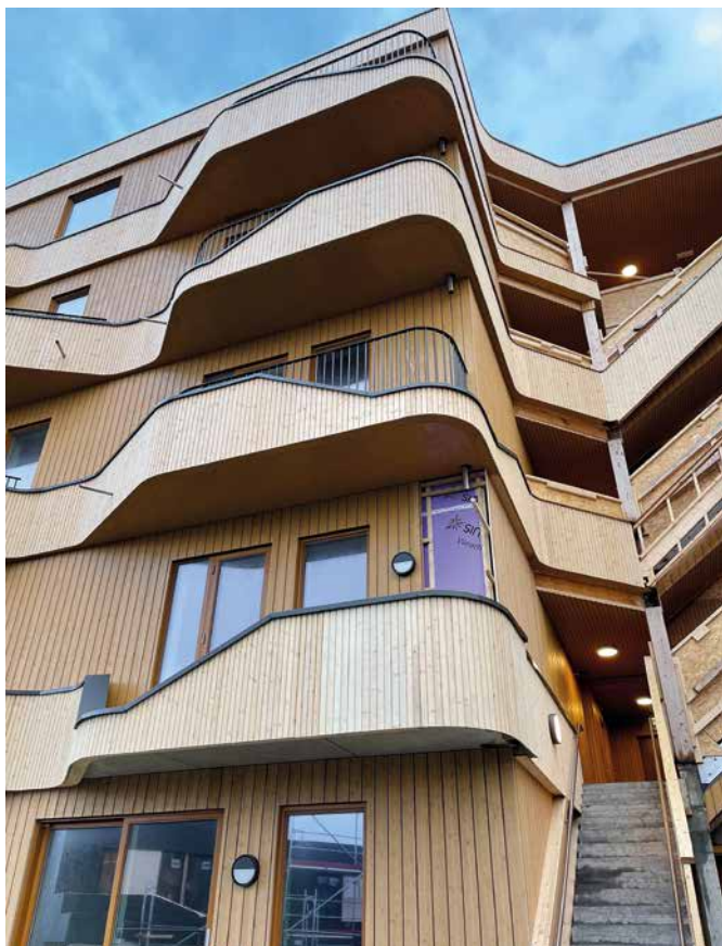
Sola Bygg AS har bygd boligblokkene i Eplestien på Tasta i Stavanger med massivtre i konstruksjonen.
