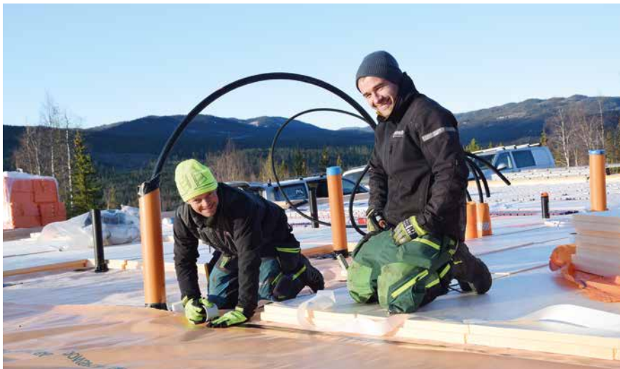
Snart skal plata støpes. Roger Kjensrud og Jonas Strandbråten teiper sammen folie på isolasjonen.
