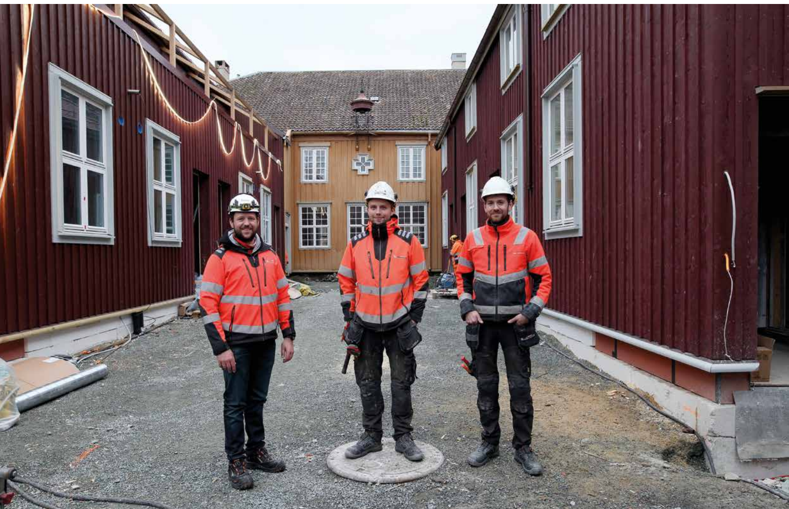
Inne på tunet er anleggsleder Robert Lunde (t.v.) tømrer Tormod Bjølverud og bas Robert Bordal omkranset av de nye røde byggene og et av de gamle gule. De nye husene er tegnet av Diana Espinosa i Arkitekturfabrikken.
