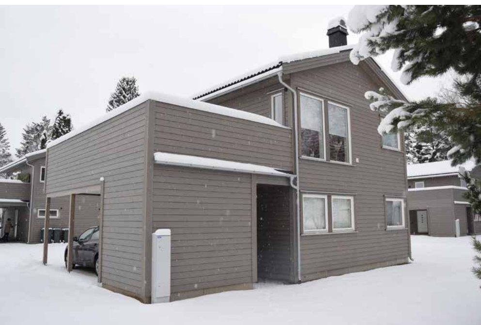
Bygningskroppen er enkel og egnet seg godt til elementer.
