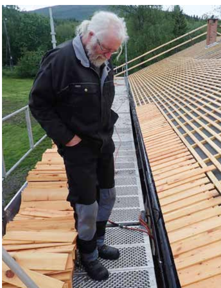
Tradisjonshåndverker Karl Prytz ser an starten på tekkingen. [Foto: Ulf Magne Ulriksen NFK]
