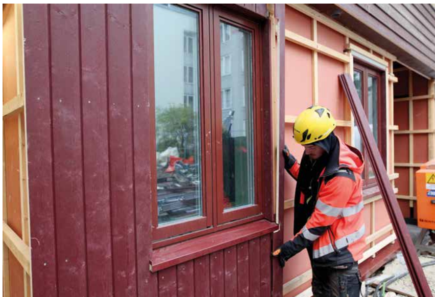
Tømrer Espen Botten monterer ytterkledning.
