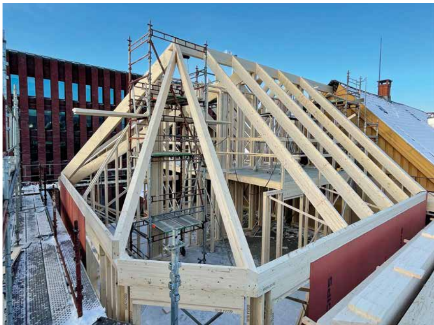
For å forhindre problemer med bevegelse i det gamle huset, festes ikke limtre-drageren i det gamle. (Foto: Tømrmester Arnstein Sørgård)
