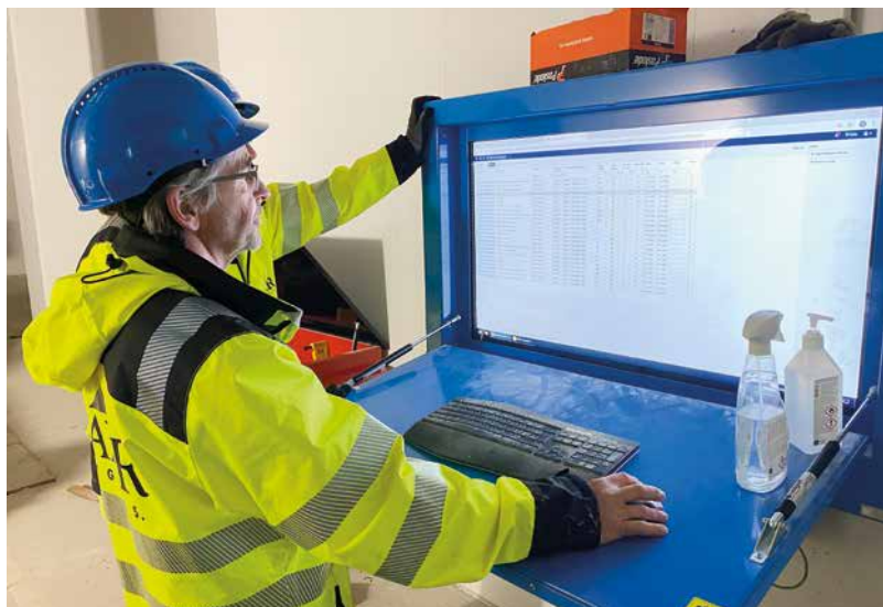
– Systemene for kontroll og avsjekk på Nye SUS er omfattende. I prinsippet har vi 10 000 punkter som vi skal gjennom i uka! sier Bent Gabrielsen foran BIM-kiosken.
