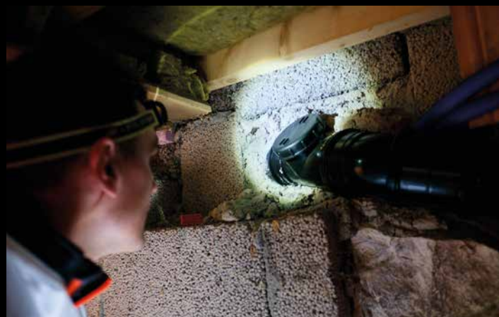
– I kjellere ser jeg etter fukt- og råteskader. Løse ledninger, drypplekkasjer og om rørene ligger greit i forhold til frost o.l. Stakeluker og tilgangen til stoppekrana vil jeg også se, sier Simen Hveem.
