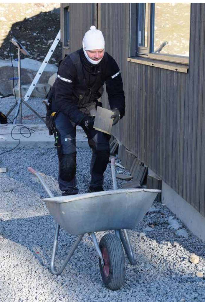
På fritida hjelper Bjørn-Terje Jacobsen til med rydding og som håndlanger på byggeplassen.
