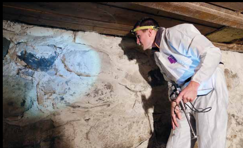
Hveem tar flere fukt-målinger med hammer-elektrode i krypkjelleren, også under våtrommet og ved gjennomføringene til vann og avløp.
