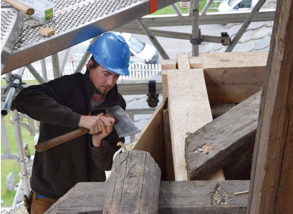
Bart Gevers skrår toppen av det nye kledningsbordet for at vann skal renne av, ikke sige inn.
