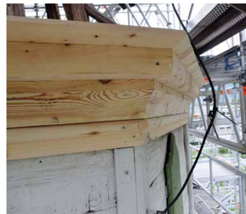
Gesimsen i overgangen mellom vegg og tårnet måtte byttes ut, med ny i samme utseende.
