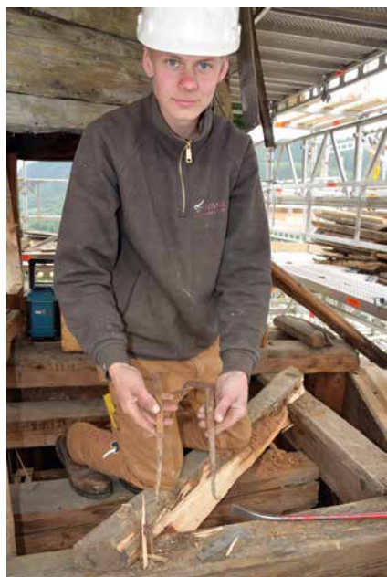
Spikrene som var brukt opprinnelig, var håndsmidde med mothaker, demonstrerer Anton Rudi.
