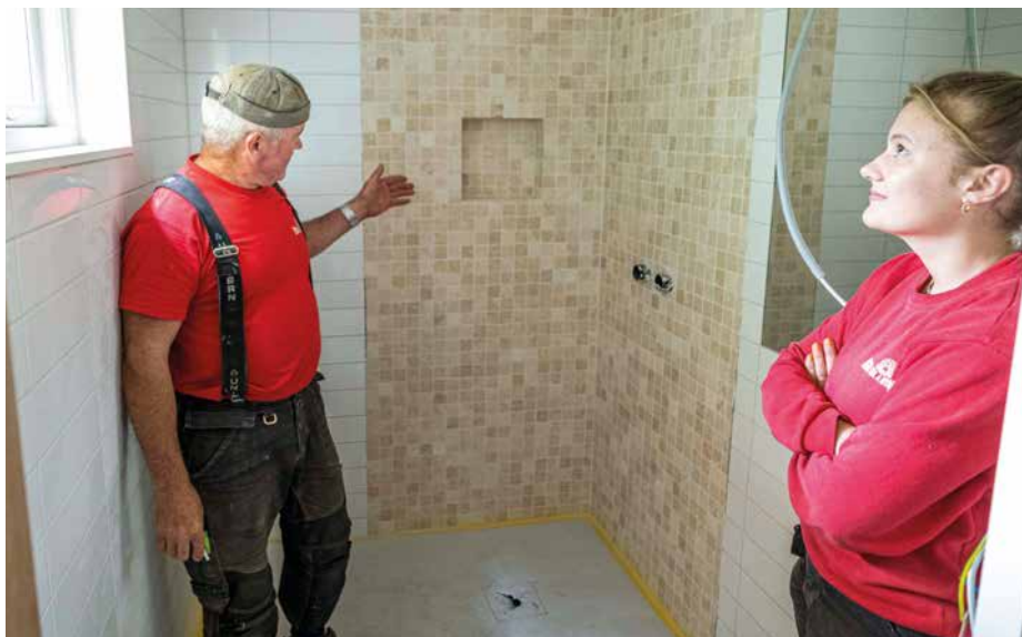
FLOTT GJORT: En erfaren flislegger kunne ikke gjort det bedre, mener byggmester Egil A. Myrstrand om hvordan hans unge kollega Andrea Marie Bjordam har flislagt sitt første bad alene.
