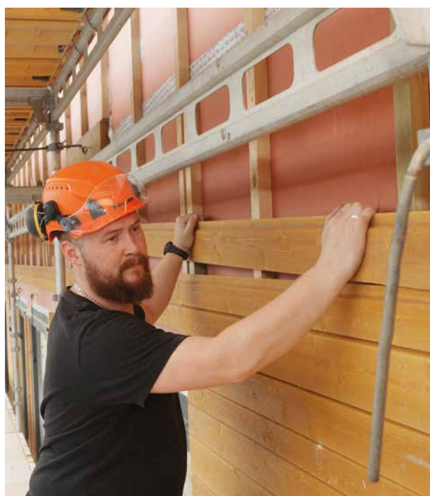
– Et supert prosjekt som gir meg mye trening i å legge kledning, sier tømrerlærling Rino Andre Holst.
