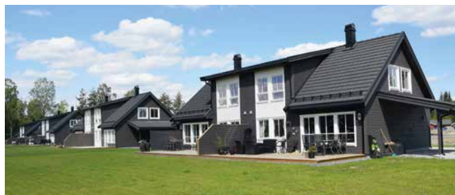
Tomannsboliger med romslige hager danner boligfeltets fasade mot en boligvei. Bak dem bygges det frittliggende eneboliger.
