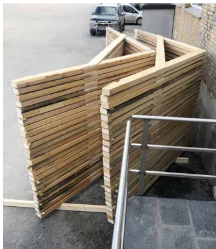
Etter vel ei uke i verkstedet sto stabler av sperrebind ferdig. (Foto: Jens Martin Holme)
