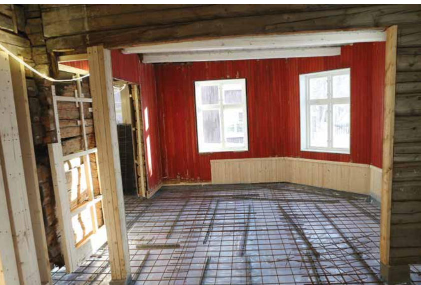
Inne i et av rommene i huset i Svenskveien på Røros, har Røros Entreprenør tatt vare på den gamle panelen på veggene og deler av det gamle tømmeret. Det aller meste blir nytt i dette huset.
