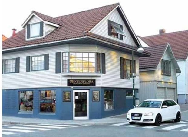
Huset fra 1970-tallet ble revet for å bygge en replika av huset fra 1890-årene. (Foto: Privat)
