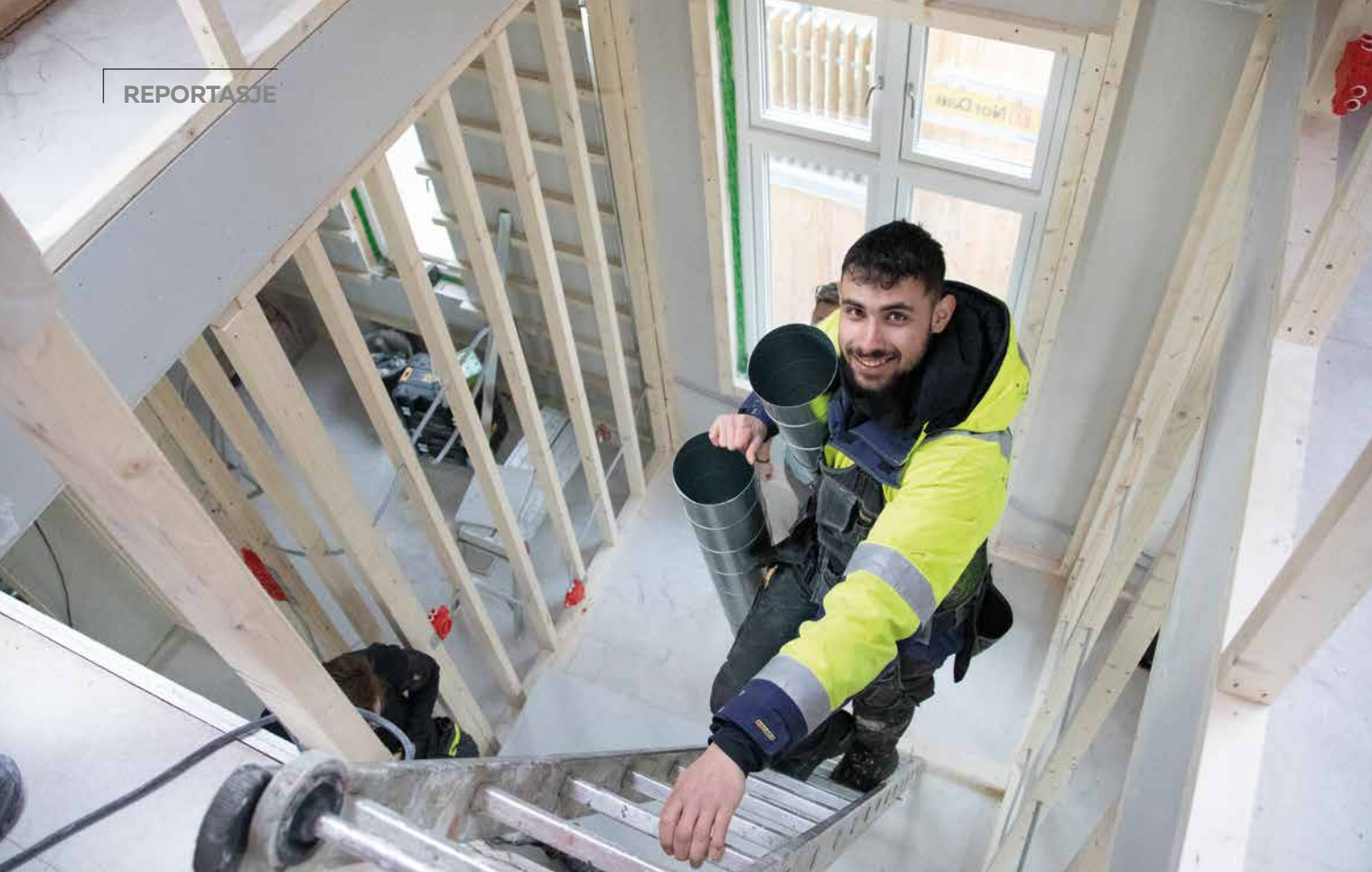
Lærling Ouday Almousa får mye trening i å klatre i stige, når ventilasjonsrør skal fraktes fra en etasje til den neste. (Alle foto: Alf Bergin)
