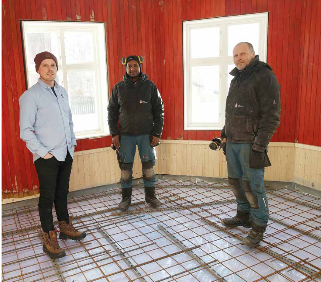
Samson Emmanuel Hailaeb med veileder Rune Buraas (t.h.) og daglig leder Steinar Tamnes i en bolig som totalrenoveres i Svenskeien på Røros.
