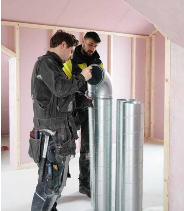
Byggmester Kristoffer A. Bryne (t.v.) og lærling Ouday Almousa monterer ventilasjonsrør.
