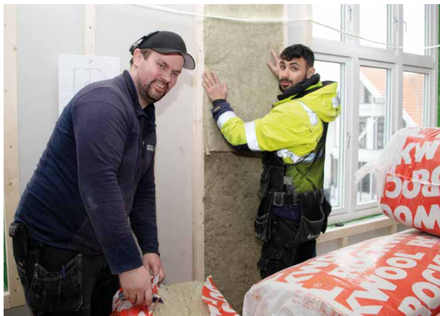
Prosjektleder Ole Kristian Gjil og lærling Ouday Almousa isolerer ytterveggene.
