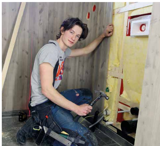
Tømrer Hans Iver Almås er med på totalrenovering av ei hytte på Glåmos nord for Røros.
