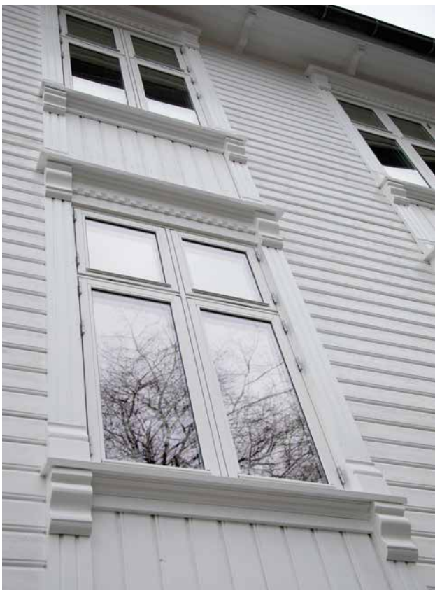
Vindusknektene er skåret ut for hånd med innleid båndsg.
