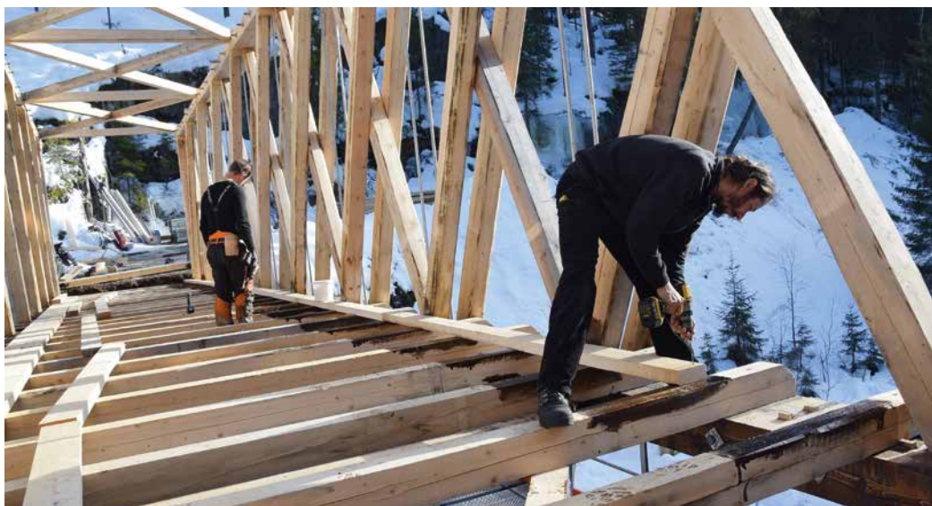
SKRUR FAST: Jan Guttenberg er i gang med å feste første bordlengde i dekket.
