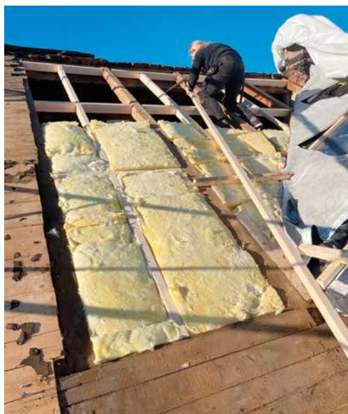
Godt i gang med etterisoleringen og montering av nødvendige spikerslag til nytt overtak.
