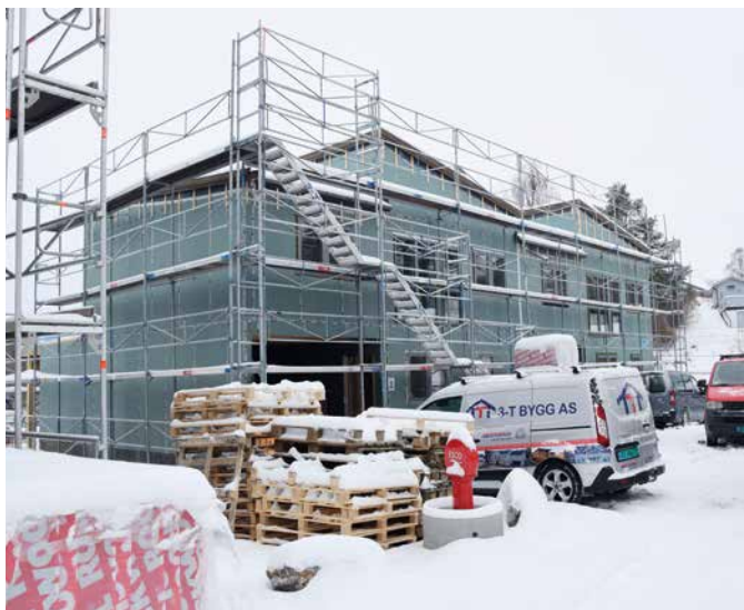
Her skal det snart legges på kledning. Den blir beiset, ikke royal-behandlet som planlagt på grunn av usikkerhet omkring brannklassifiseringen.
