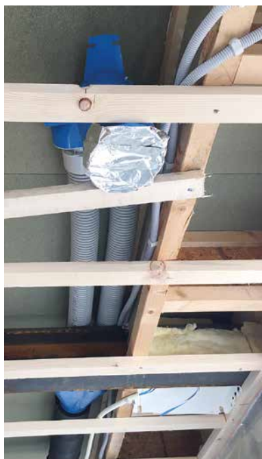
Rørene har en diameter på 75 mm og er derfor lettere å plassere inne i konstruksjonen.
