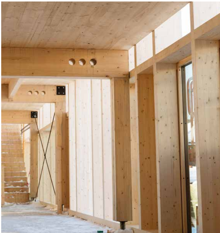
Massivtre i himlingen og limtre i vindusomrammingene vil bidra til et moderne preg.
