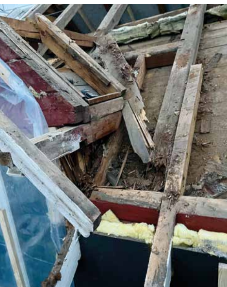
Store råteskader møtte tømmerne da de åpnet takkonstruksjonen.
