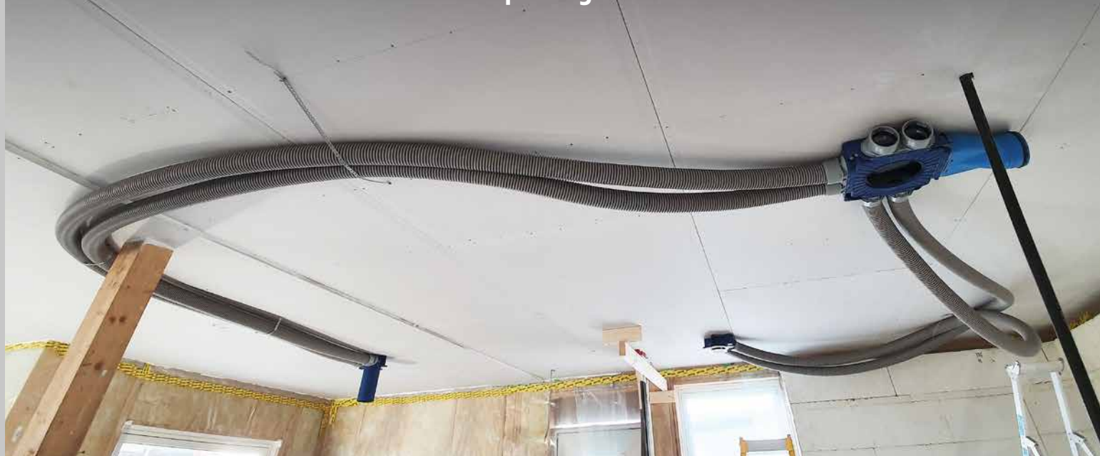
De fleksible rørene kan bøyes og strekkes på helt annen måte enn spirorørene. (Foto: Systemair)
