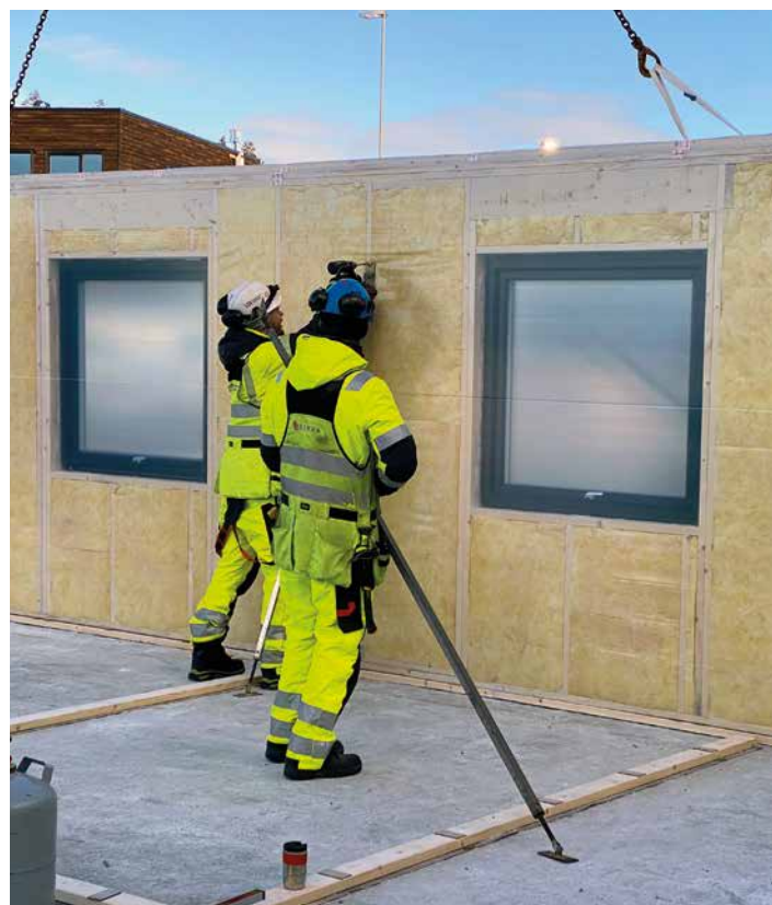
Forankring av ytterveggen på svillen.
