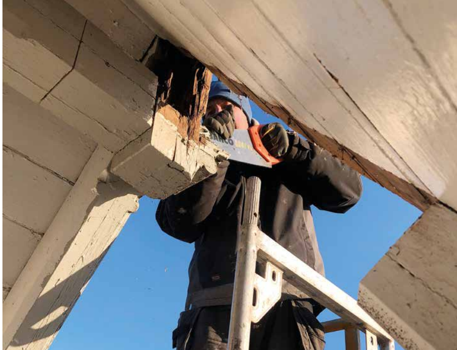
Mantas Pocius skjærer ut råteskadde deler som skal skiftes ut. (Foto: S. Dahlin, Egil Norli AS)
