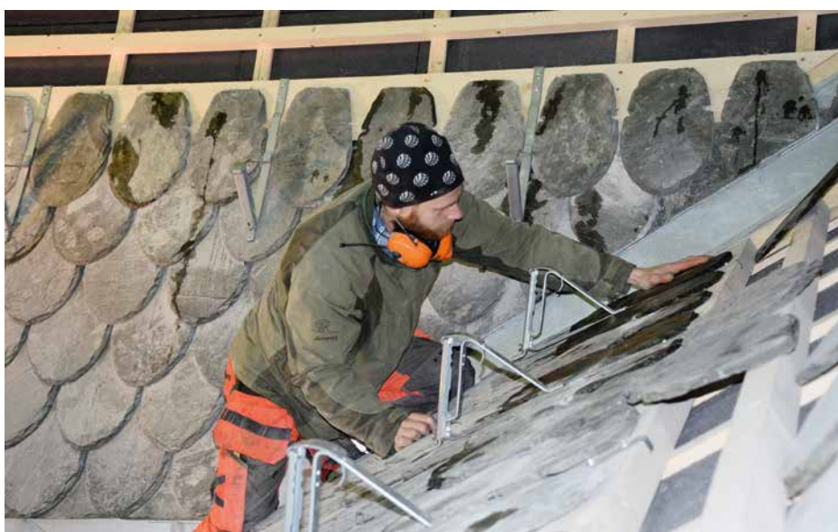
Ola Wehie sjekker at skifersteinen passer til steinene rundt og til snøfangerfestet.
