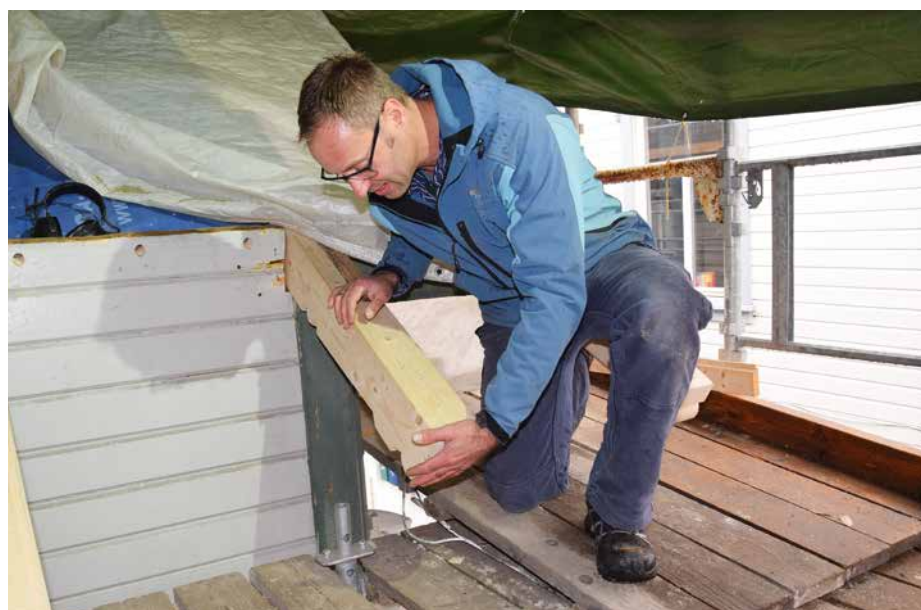
Marius Kaltheth viser hvordan enden på sperrene er erstattet med nytt trevirke. Med samme profil som før, selvsagt.
