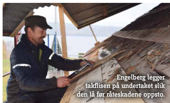
Råteskadd undertak og deler av taksperrer er erstattet med nye bord og nytt trevirke som er felt inn.
