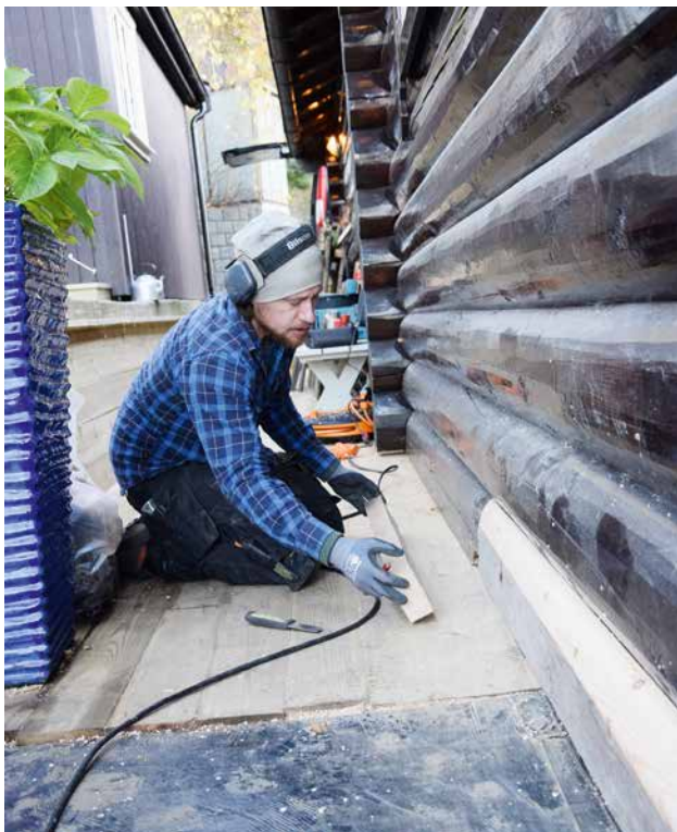
– Jeg liker best kortvarige jobber, forteller Daniel Haug Haagensen. Han har bygd et terrassegulv før han måtte i gang med å bytte ut deler av en stokk i lafteveggen.
