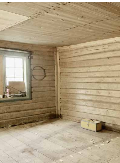
Flere av rommene har fått nye tømmervegger, gulv og tak.
