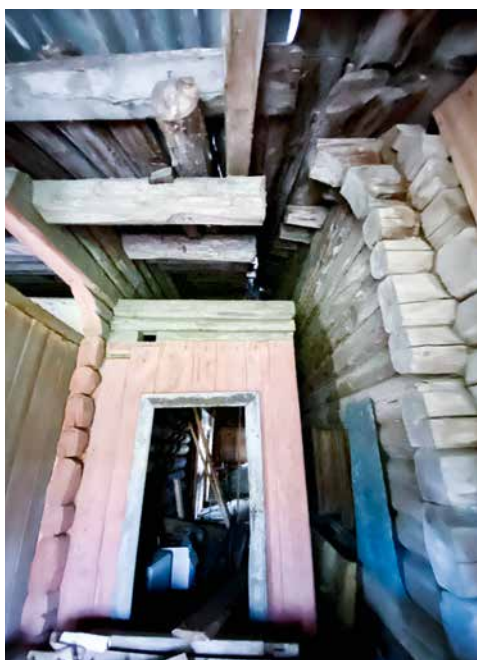
Overgangen mellom de to tømmerkassene i andre etasje.
