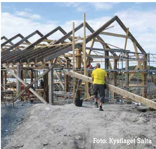
Grindverkskonstruksjonen ble reist i sommer. (Foto: Kystlaget Salta)
