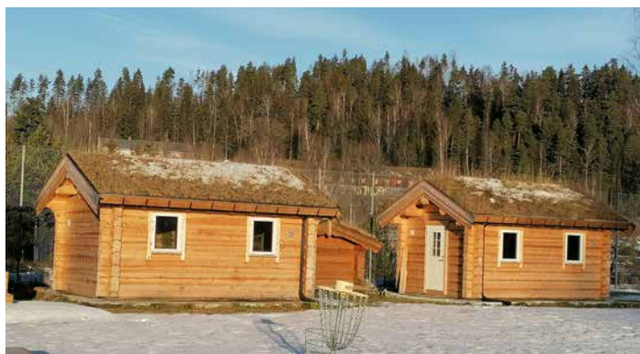
Laftehusene på NTNU Campus i Gjøvik. Håndlaft til venstre og maskinlaft til høyre. (Foto: Treteknisk)
