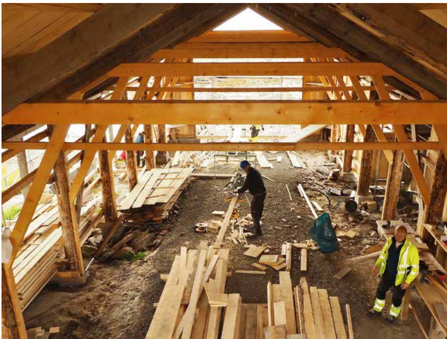
Grindverkskonstruksjonen ble reist i sommer. (Foto: Kystlaget Salta)
