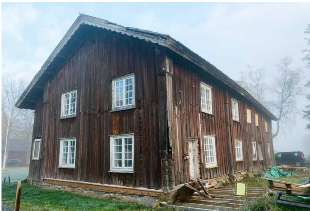
Svalgangsbygningen var en herskabelig bolig for fest og fintfolk. Laftekassa som ble satt opp i 1725 (nærmest) har gjenbrukte stokker som kan være enda eldre.
