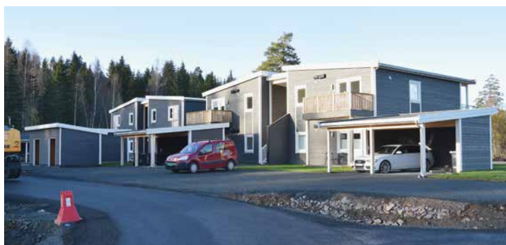
Rekkehus, leiligheter og eneboliger som disse på Raufoss, er boligtyper firmaet bygger flest av.
