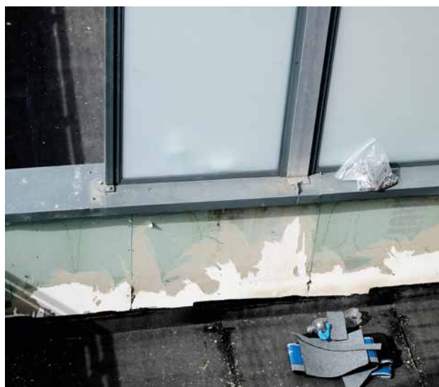
Skadeutbedringene viste flere tidligere løsninger som forundret håndverkerne. (Illustrasjonsfoto: C. Kunøe)
