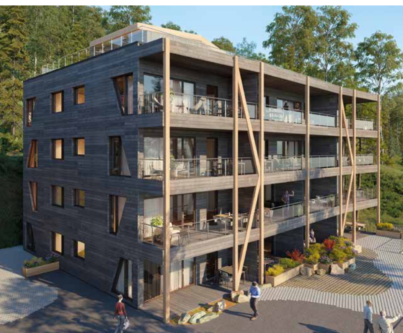
Slik vil blokkene se ut når de står ferdig. (Ill.: VY Communications)
