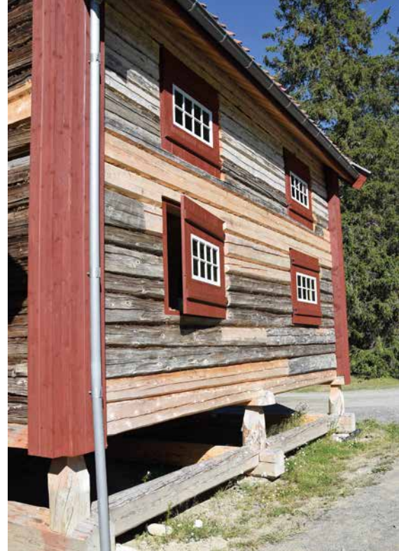
Bakveggen hadde mest råteskader. Her ble det også satt inn vinduer i luker som fungerer som rømningsvei. Spesialsnekret av Gaarder.
