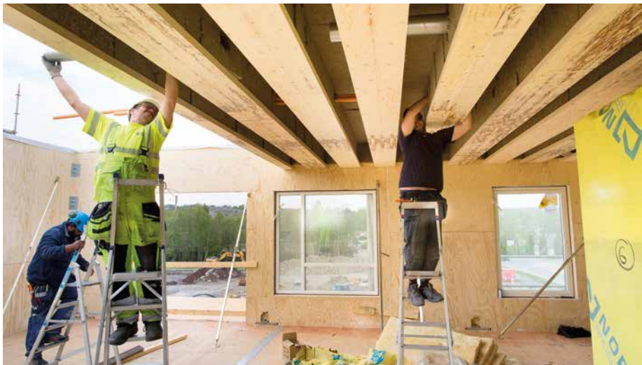
Etasjeskillet er 50 cm høyt og Kerto-bjerkene blir isolert med steinull. Ventilasjon og andre rør trekkes her for å unngå synlige kanaler i leilighetene. (Foto: Arca Nova)
