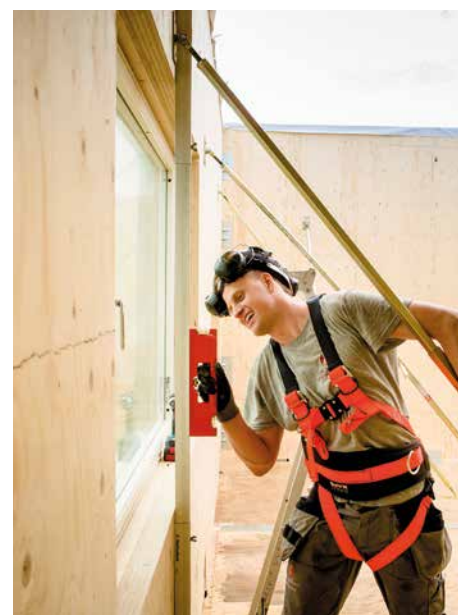
Sammen med bindingsverk, stiver finerplater på 67 mm tykkelse av veggene i de tre nederste etasjene. (Foto: Arca Nova)
