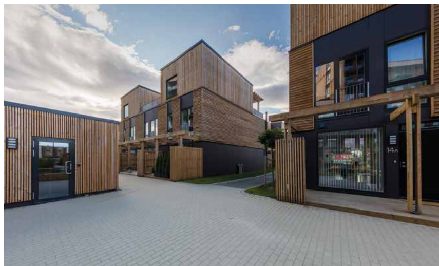
Rekkehus på Lilleby i Trondheim som er bygd med elementer fra Støren Treindustri. (Foto: Svein Erik Knoff)
