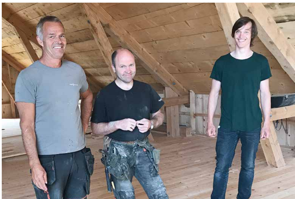
Byggmestrene Bjarne Harbo og John Olav Nessa og tømrer Jostein Flå var sentrale i arbeidet med låven. (Foto: Høie Ueland)
