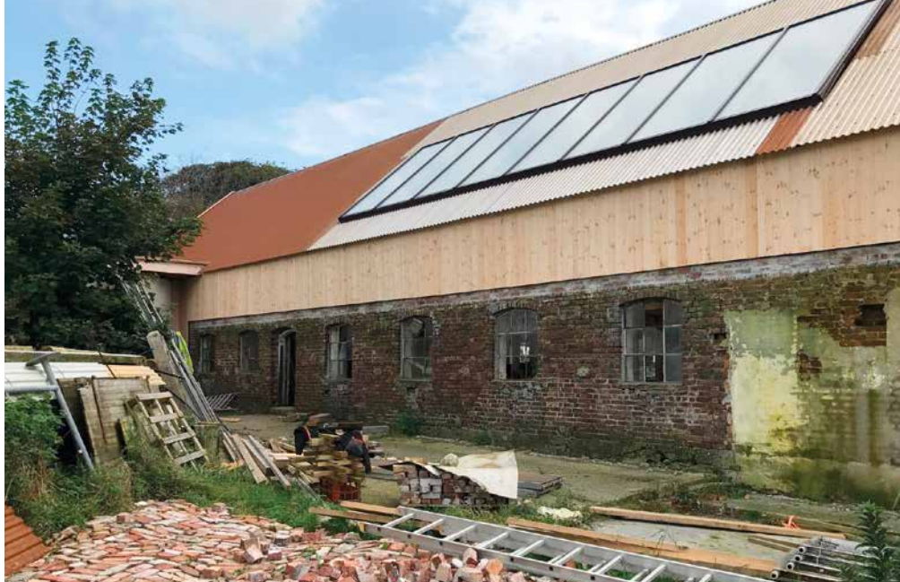
I taket er det et stort overlysvindu på 3 x 15 meter. Vindusrammene ble lagt inn i konstruksjonen før glassene kunne heises på plass. (Foto: Høie Ueland)
