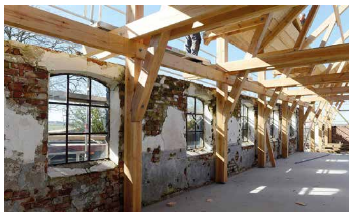
Teglsteinsveggen er forankret i stolpene. (Foto: Høie Ueland)
