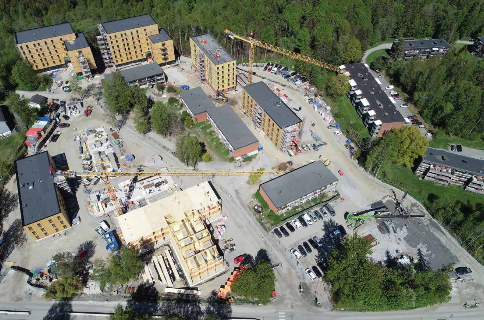
Skogveien skal stå ferdig i oktober 2021, nå er området en studie av ulike byggestadier. (Foto: Glenn Neerås Johansen, Veidekke)
