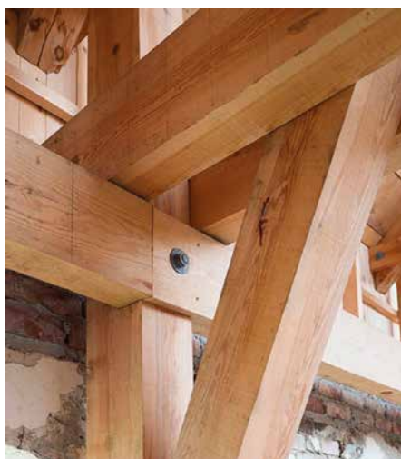
Bjelker og stolper er festet sammen med bolter og bulldog. Skråbånd og trekanter stiver av konstruksjonen. (Foto: Trodahl Arkitekter AS)
