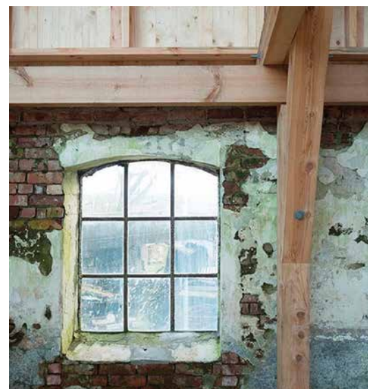
Gammel teglsteinsvegg støttes av ny furu kjerneved. (Foto: Trodahl Arkitekter AS)
