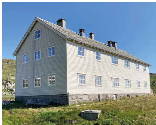
Etter to uker med lange arbeidsdager sto Tusenheimen ferdig med nye vinduer og ny kledning.
