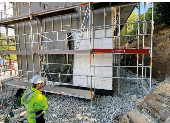
Husene er trukket så langt bak i fjellet som mulig. Det gir høyere grunnmurer og krever utfylling med mange kubikk.
