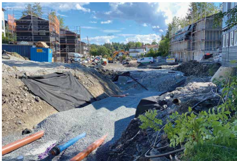
Grunnmurer ble støpt samtidig med det omfattende VA-anlegget. Det krevde logistikk på timenivå.
