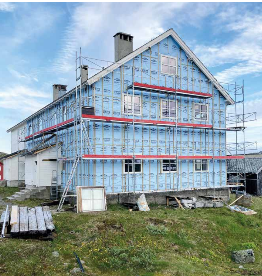
De fleste dagene var det sommer og sol – helt ideelt til å skifte kledning og sette i nye vinduer.
