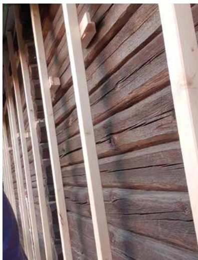
Oppretting av utvendig tømmervegg med 48x48.
