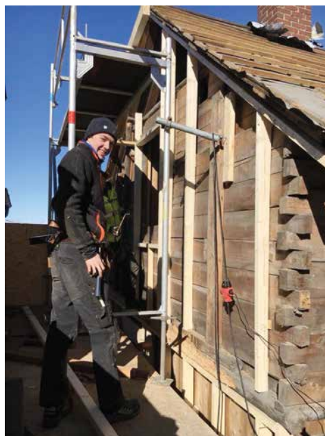
Johannes Time Bø leker ut til etterisolering med trefiberisolasjon. (Foto: Kjell Høie)
