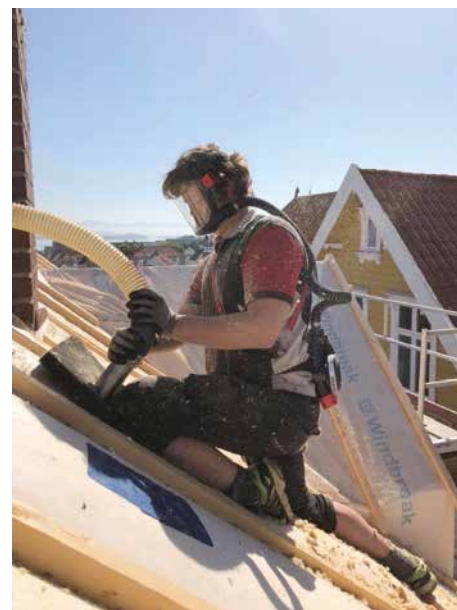
Etterisolering var en del av rehabiliteringen som Høie Ueand sto for. (Foto: Kjell Høie)
