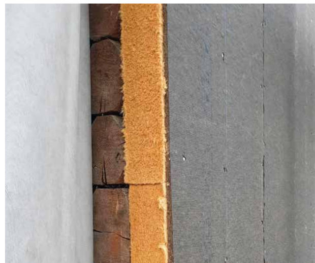
Rundt utvendig lafteknute er det isolert for hånd med trefiberplater.
