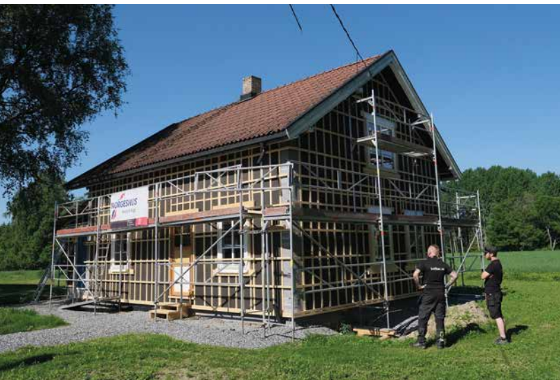
Huset i Skogbygda har totalt 115 m 2 veggareal og etterisoleres med trefiber i løpet av seks - sju timer.
