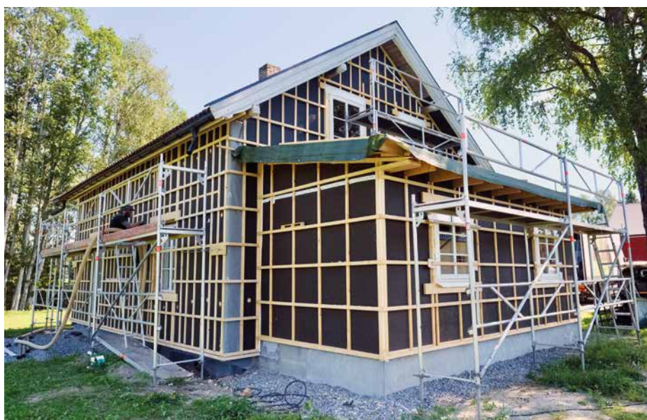
Det kan være utfordrende å blåse inn trefiberisolasjon i eldre trehus fordi veggene inne- holder mange klosser og bjelker som skaper lommer i veggene.
