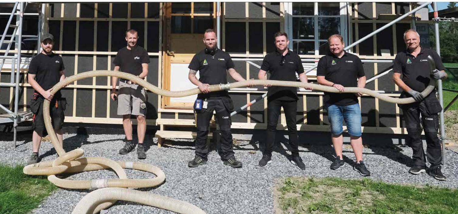
KLARE FOR ETTERISOLERING: Fra venstre Formann Fredrik Skårerflaen Throndsen og prosjektleder Joakim Andersen i Norges- hus Ringstad Bygg AS, blåseisolatør Thomas Sømme, distriktssjef Joakim Bang og salgssjef Roy E. Hansen i Nativo Trefiberisolasjon.
