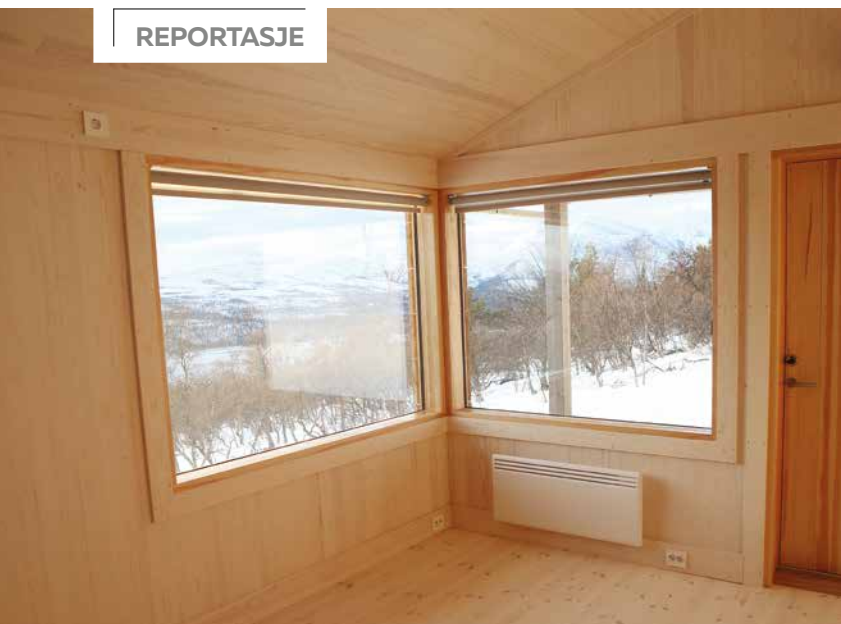
I stua er det kvistfri panel med skjult innfesting på vegger og i himlingen.
