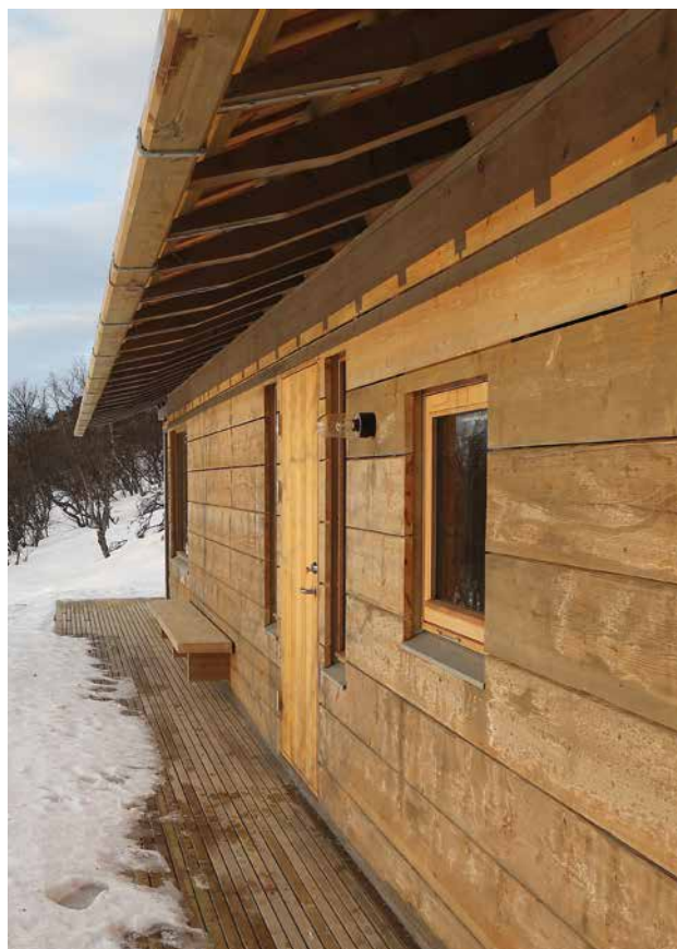
De utvendige kledningsborda er 28 centimeter breie og er behandlet med jernvitriol.
