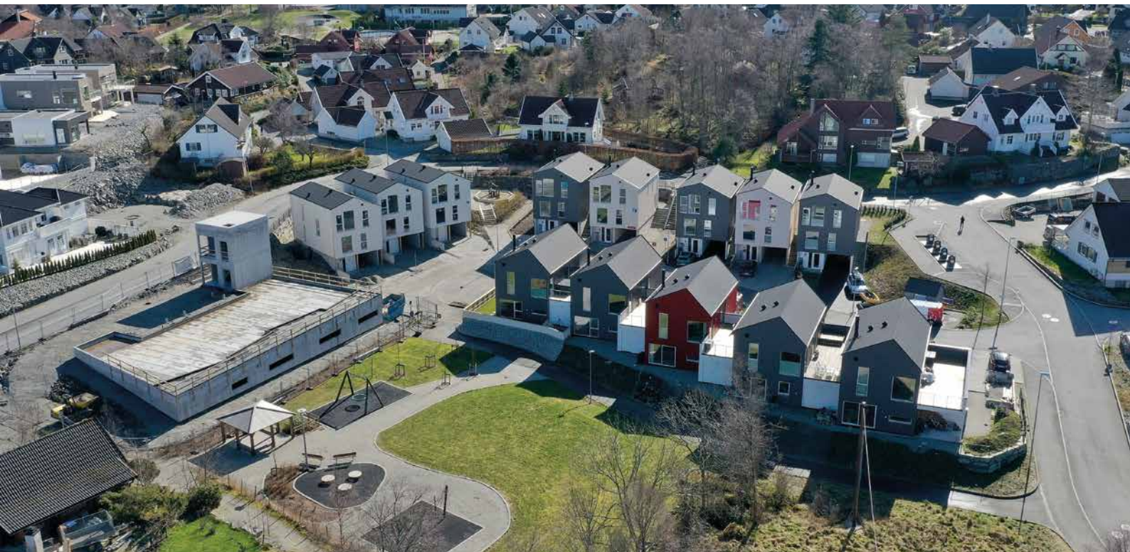
I Riska bydel i Sandnes har Øster Hus bygd eneboliger og eneboliger i rekke.
