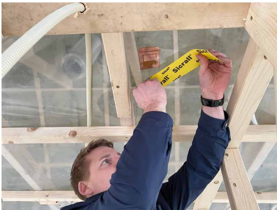
Sondre Hansson taper opp dampspærren etter å ha installert en fuktsensor i et nybygg.
