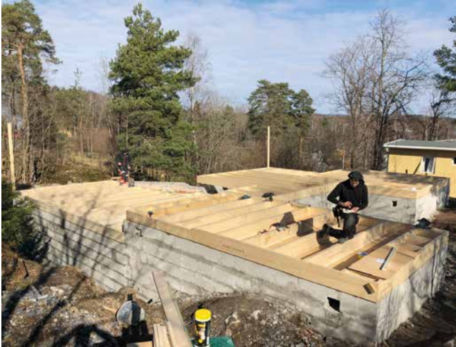
På Brønnøya i Oslofjorden er Tømrermester Kjetil Eriksen AS i gang med bjelkelaget til ei hytte. (Foto: Mats Eriksen, Kjetil Eriksen AS)
