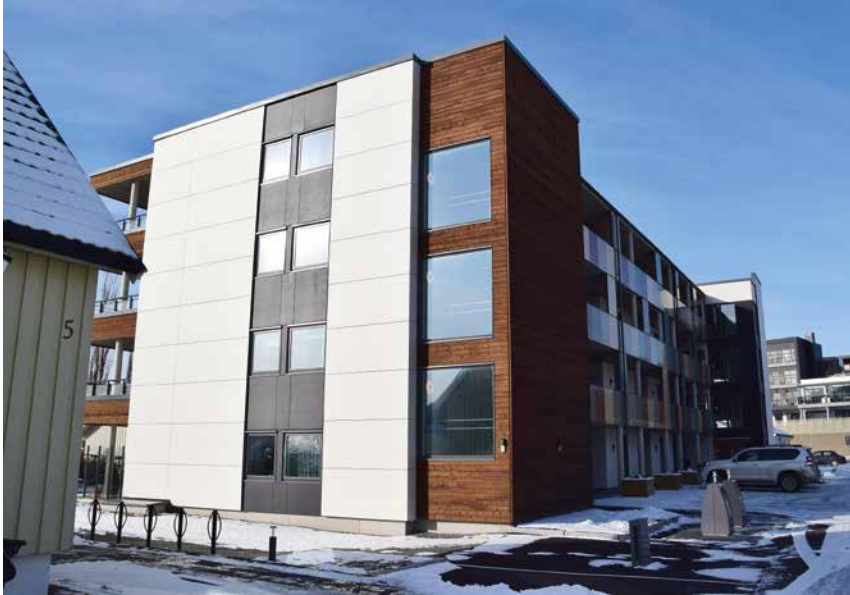
Et leilighetsbygg firmaet har bygd i Melhus sentrum.
