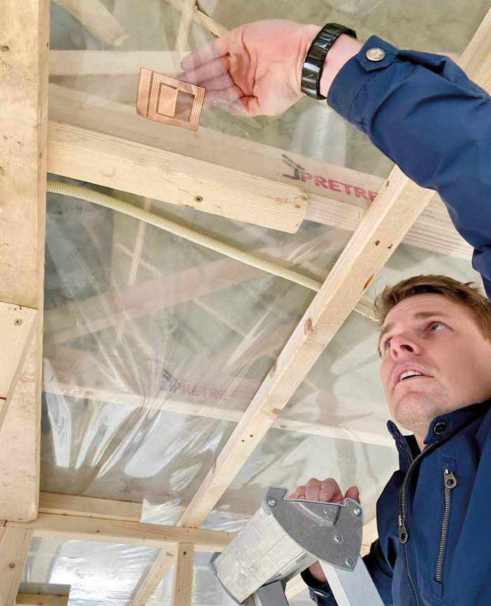
Taksmann og byggmester Sondre Hansson installerer en fuktsensor fra Invisense over dampspærren i et nybygg. - Her kan man oppdage en lekkasje uten å måtte åpne himlingen.
