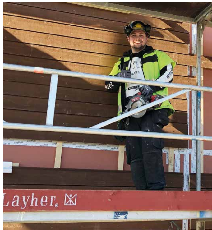
Arne Henrik Hasle Nilsen er i full gang på en av byggeplassene til Mesterbygg Moss AS. (Foto: Ulf Larsen)
