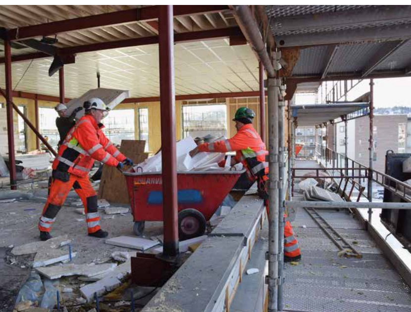
Isolasjonsplatene som ikke kan brukes igjen, bæres og kjøres ut til en ventende konteiner.
