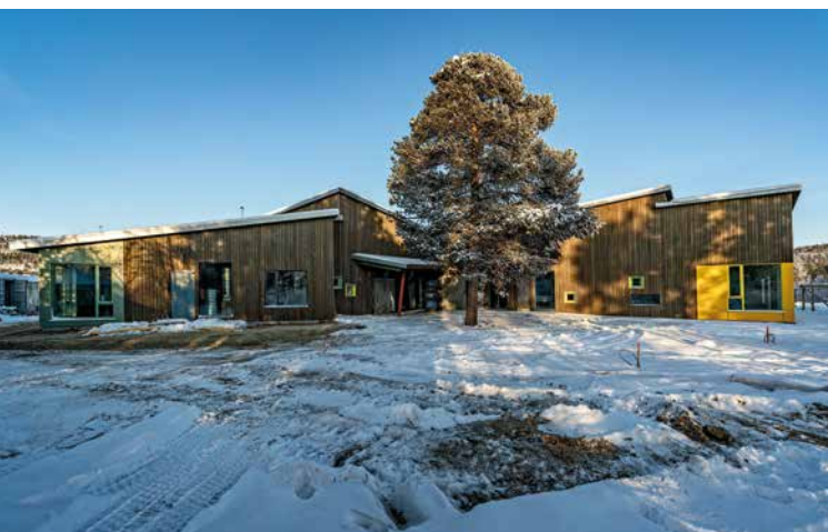
Den samiske barnehagen ble det siste bygget i bygda for Lindseth Bygg. Kommunen har leid inn tidligere Lindseth bygg-ansatte for å ta seg av gjestående arbeid. (Alle foto: Alf Ove Hansen)
