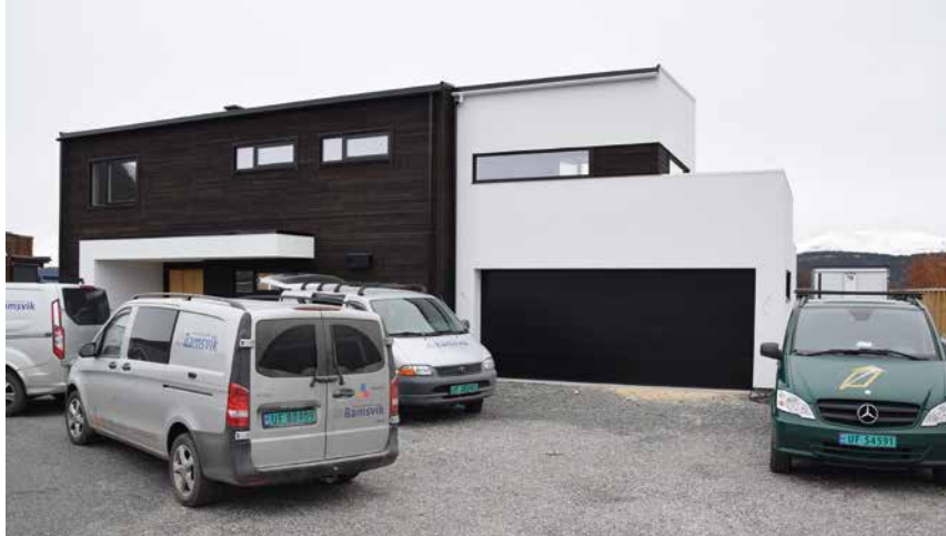
Ett av de siste husene som er under bygging, har pussede vegger på tak-utstikk og rundt garasjen med takterrasse.
