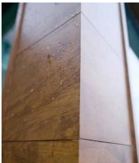
Finarbeid: Tømmerne hadde ikke montert Accoya før, men brukte samme tid som med andre typer kledninger.
