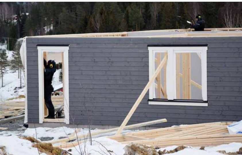
Tømrere i Blink Hus Sigdal setter sammen elementene til en tomannsbolig. Elementene kommer fra selskapets egen fabrikk i Eggedal.
